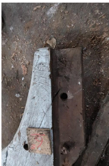
Marque de charpentier tracé à la reinette sur un élément en bois déposé après l'incendie en 2019 de la maison de Saint-Dinan. Phot. Fanny Gosselin IVR53_20252210640NUCA
