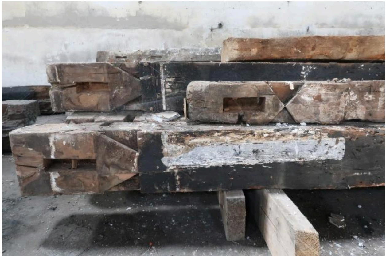
Assemblages en queue d'aronde et tenon-mortaise visibles en sous-face de solives déposées après l'incendie en 2019 de la Maison de Saint-Dinan et de ses extensions.
