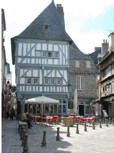
Maison d'angle dont les étages en encorbellement sont contreventés par des écharpes et potelets. Phot. Ville de Dinan IVR53_20252210634NUCA
