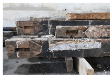
Assemblages en queue d'aronde et tenon-mortaise visibles en sous-face de solives déposées après l'incendie en 2019 de la Maison de Saint-Dinan et de ses extensions. Phot. Fanny Gosselin IVR53_20252210642NUCA
