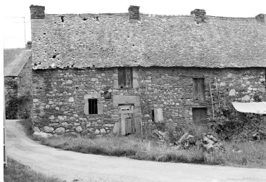
Maison : élévation sud (état en 1983) Phot. Norbert Lambart IVR53_19835600194X
