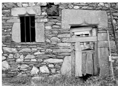
Maison, élévation sud : les baies du rez-de-chaussée (état en 1983) Phot. Norbert Lambart IVR53_19835600196X
