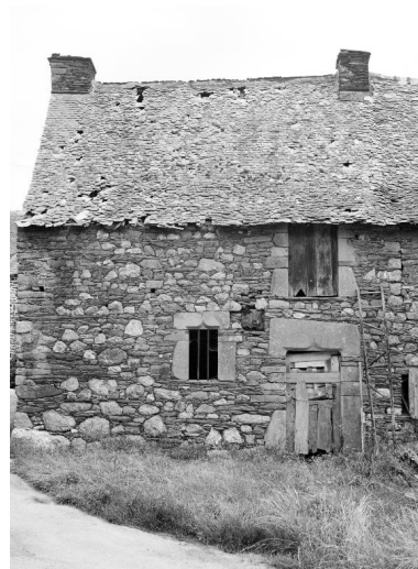
Maison : élévation sud (état en 1983) Phot. Norbert Lambart IVR53_19835600195X
