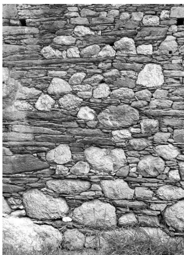
Maison, élévation sud : mise en oeuvre de l'appareil (état en 1983) Phot. Norbert Lambart IVR53_19835600197X
