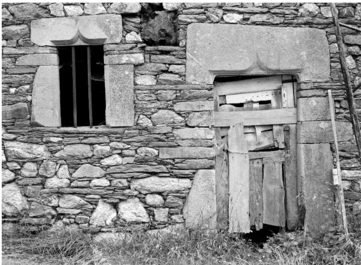
Maison, élévation sud : les baies du rez-de-chaussée (état en 1983)
