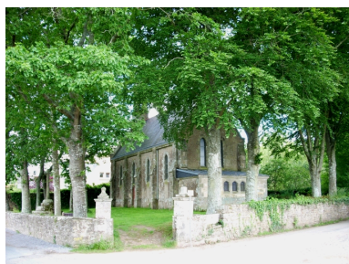
Quimper, chapelle de Cuzon : vue générale sud-est Phot. Gwénaél Fauchille IVR53_20082906395NUCA
