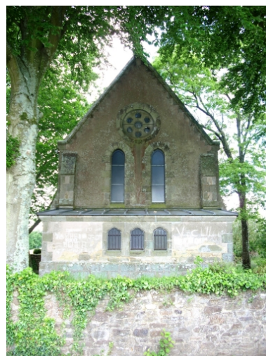
Quimper, chapelle de Cuzon : élévation est Phot. Gwénaél Fauchille IVR53_20082906397NUCA
