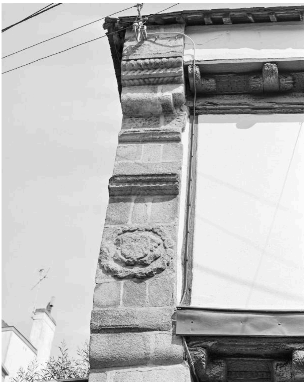
Godrons, moulures faisant office de larmiers et écu inclus dans une couronne sur le mur latéral gauche (état en 1978).
