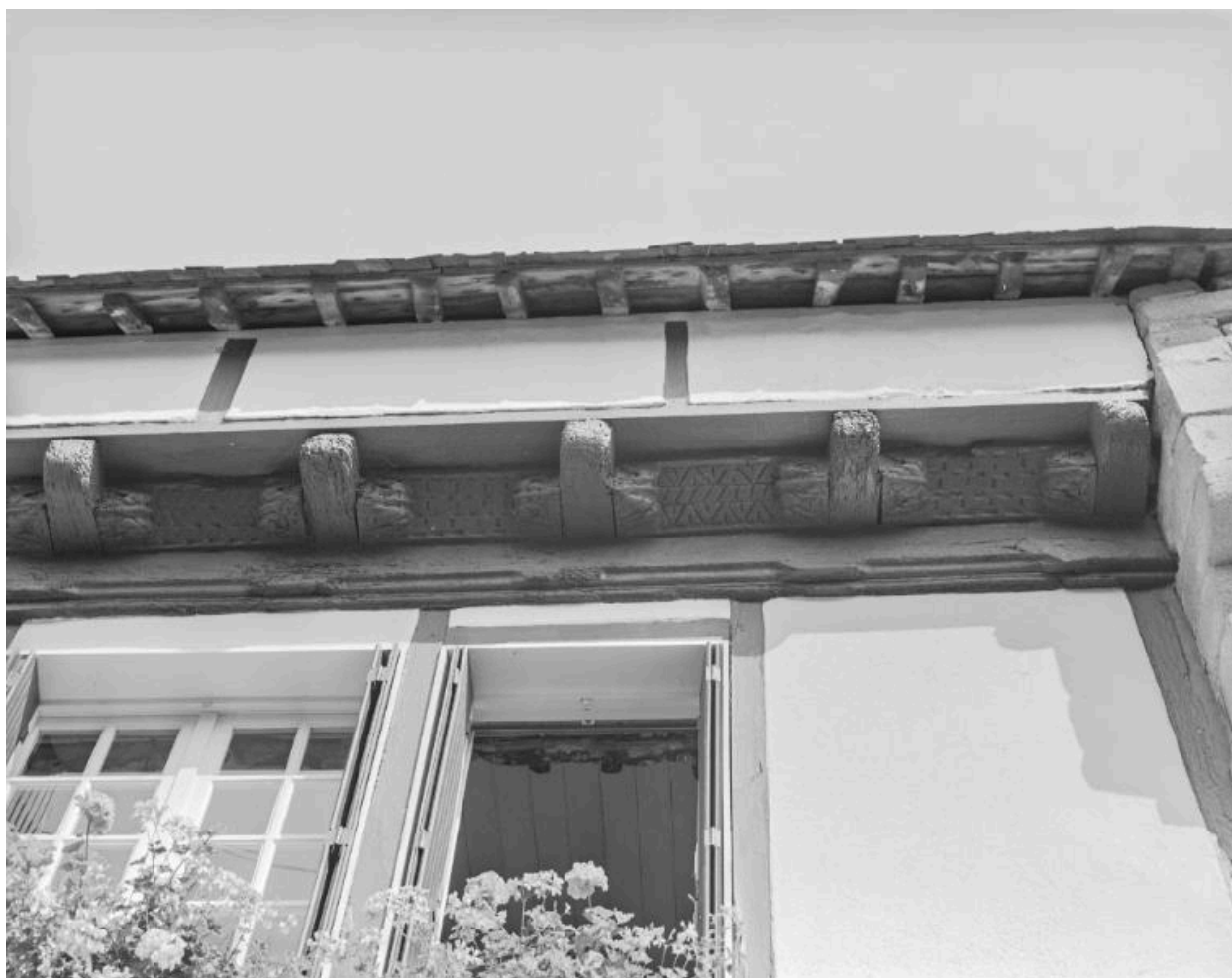
Entretroises de l'encorbellement supérieur, aux décors géométriques (état en 1978).
