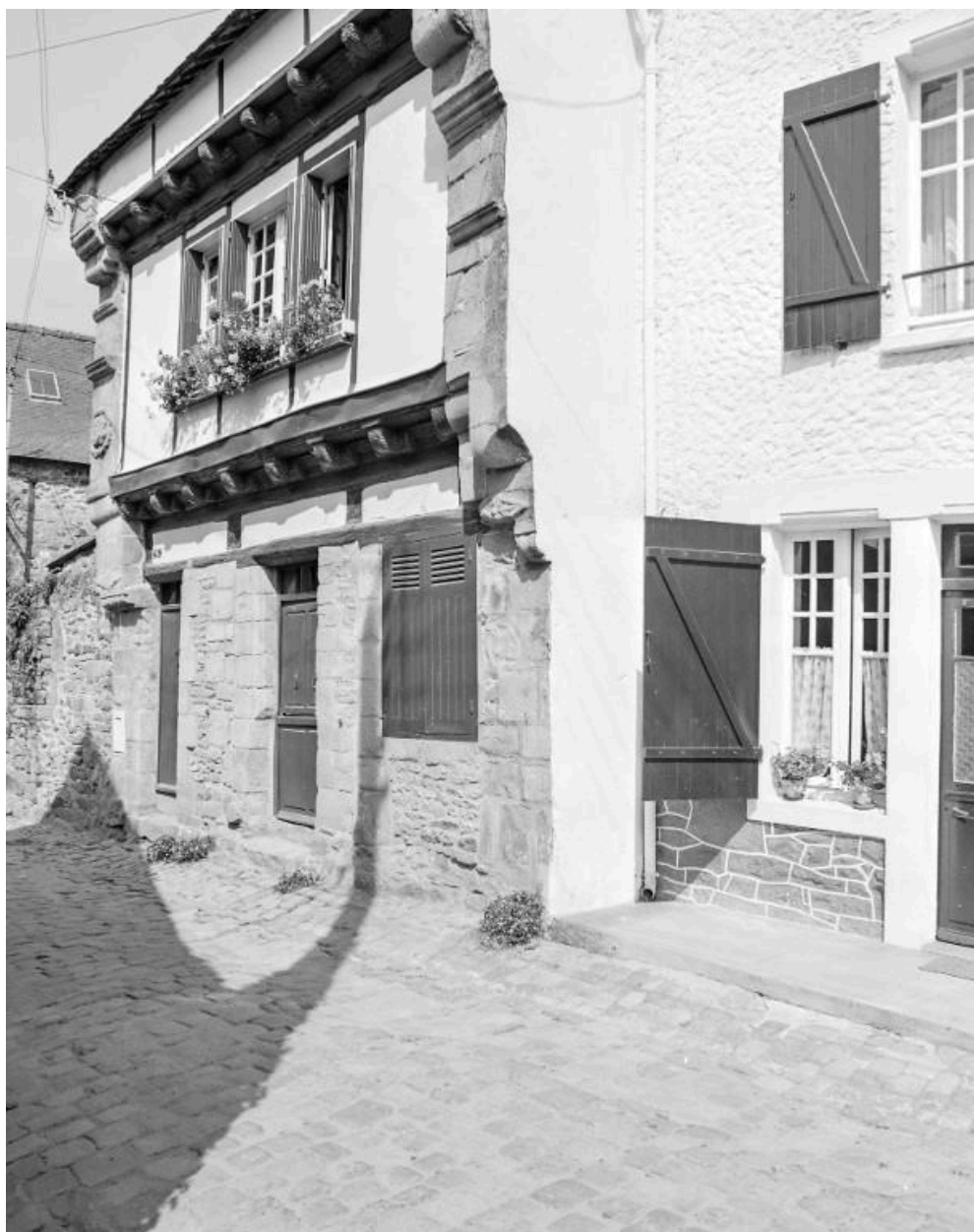
Façade sur rue dont l'étage et le surcroît sont en pan de bois en encorbellement. Un motif losangé orne le premier ressaut des deux murs latéraux (état en 1978).
