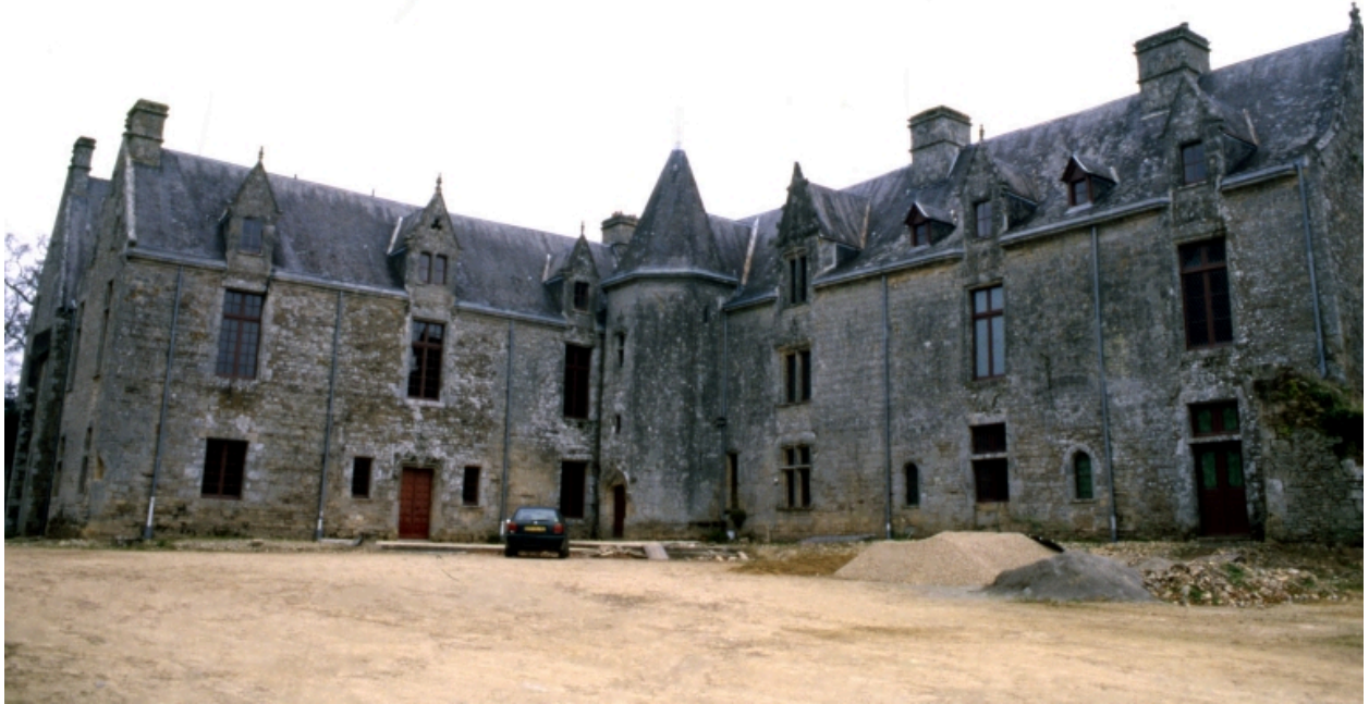
Château : les élévations sur cour (état en 2004)
