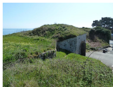
Saint-Pierre-Quiberon, batterie de Beg Rohu. Plate-forme de tir et traverse terrassée avec abri. Phot. Patrick Jadé IVR53_20165606076NUCA
