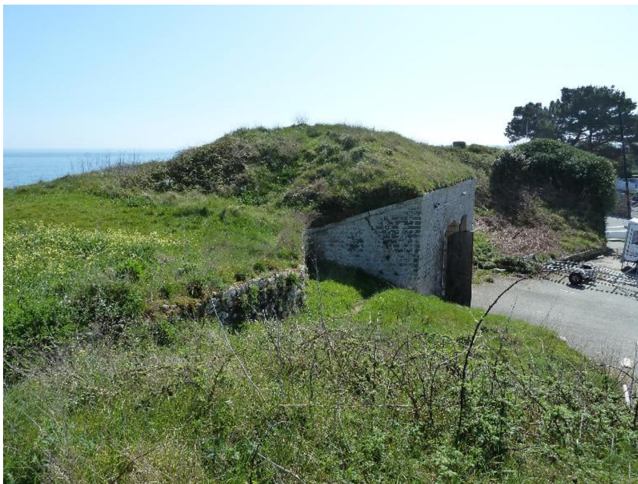
Saint-Pierre-Quiberon, batterie de Beg Rohu. Plate-forme de tir et traverse terrassée avec abri.
