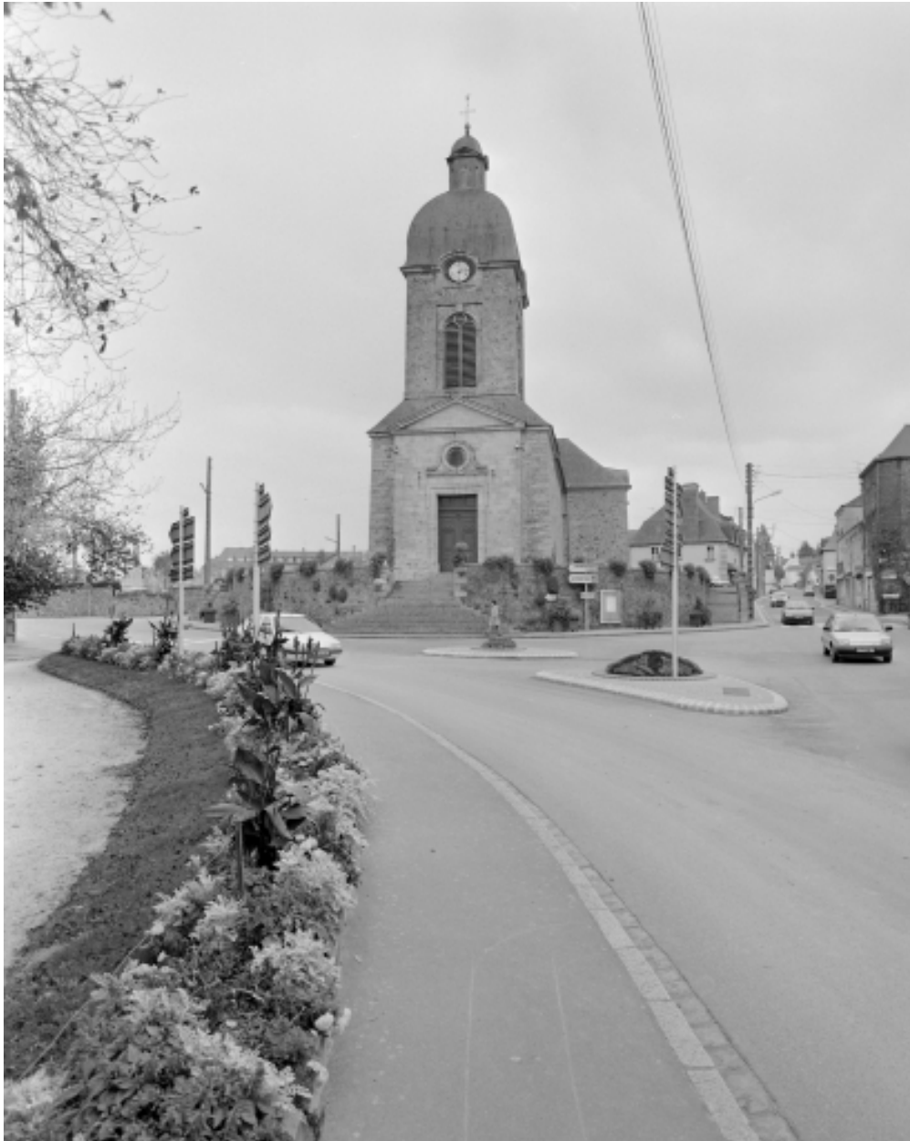
Vue générale ouest ; état en 1992
