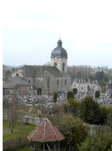
Vue de situation nord est Phot. Guy Artur, Phot. Norbert Lambart IVR53_20033500698NUCA
