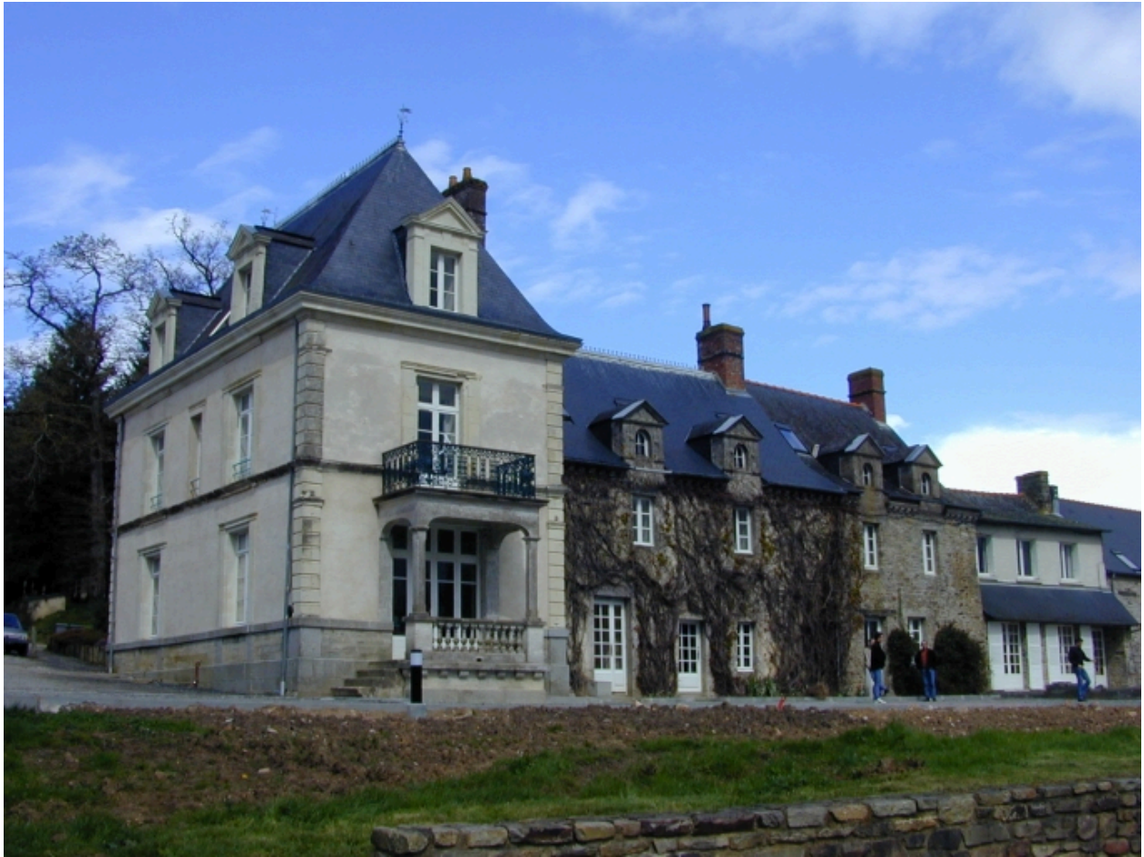
Le corps de logis : vue générale sud-ouest
