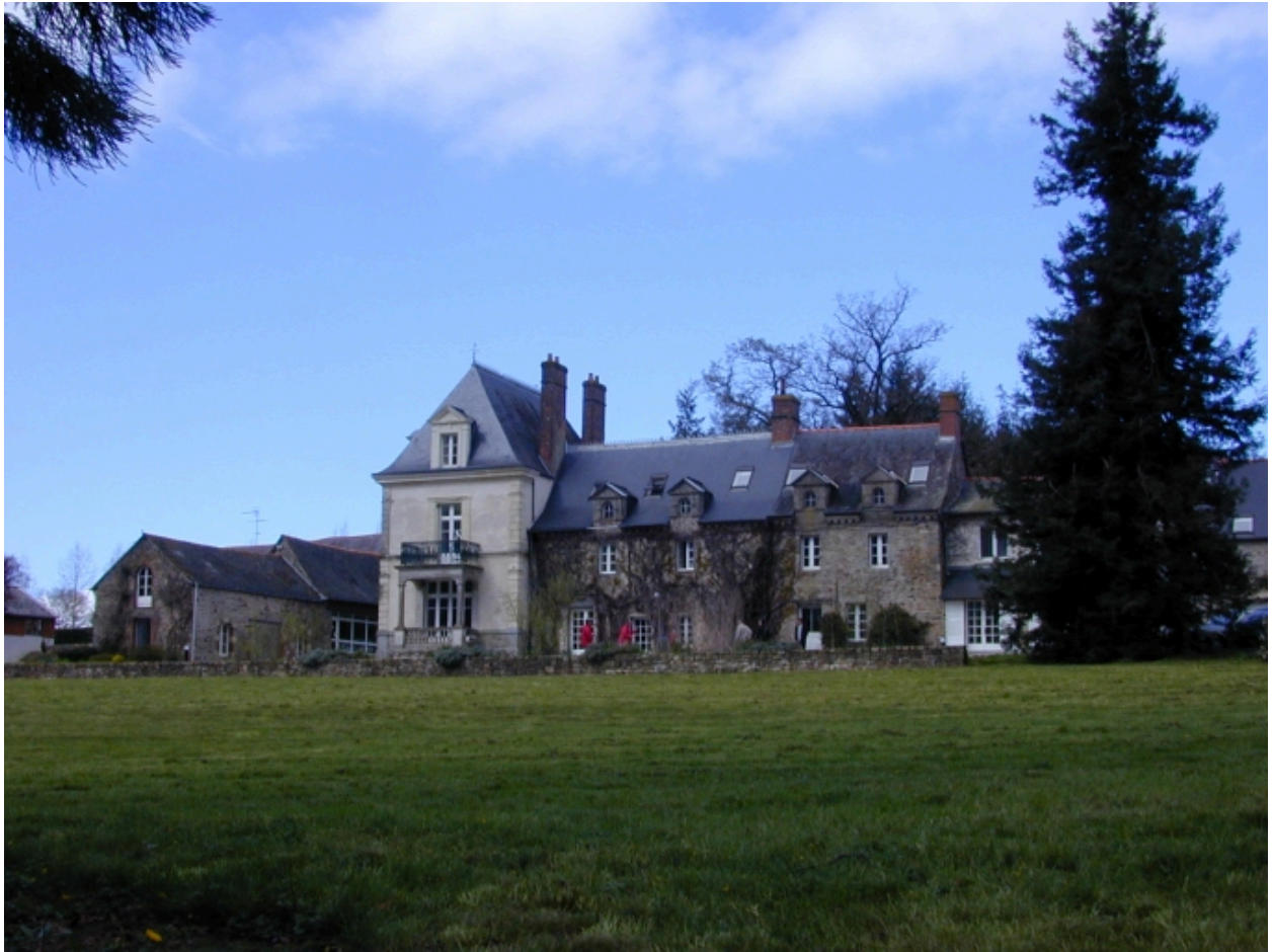
Le manoir au milieu de son parc : vue de situation sud-est
