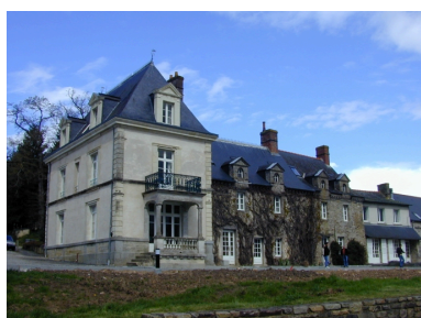
Le corps de logis : vue générale sud-ouest Phot. Xavier Gilbert IVR53_20013509192NUCA
