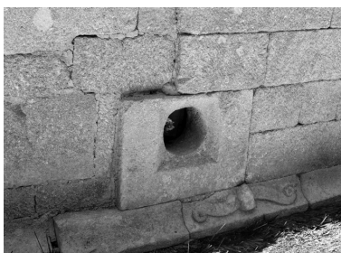
Détail de la façade. Phot. Auteur inconnu IVR53_19745600145X
