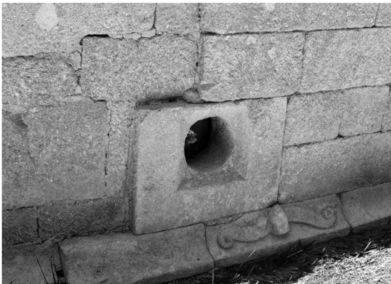
Détail de la façade.
