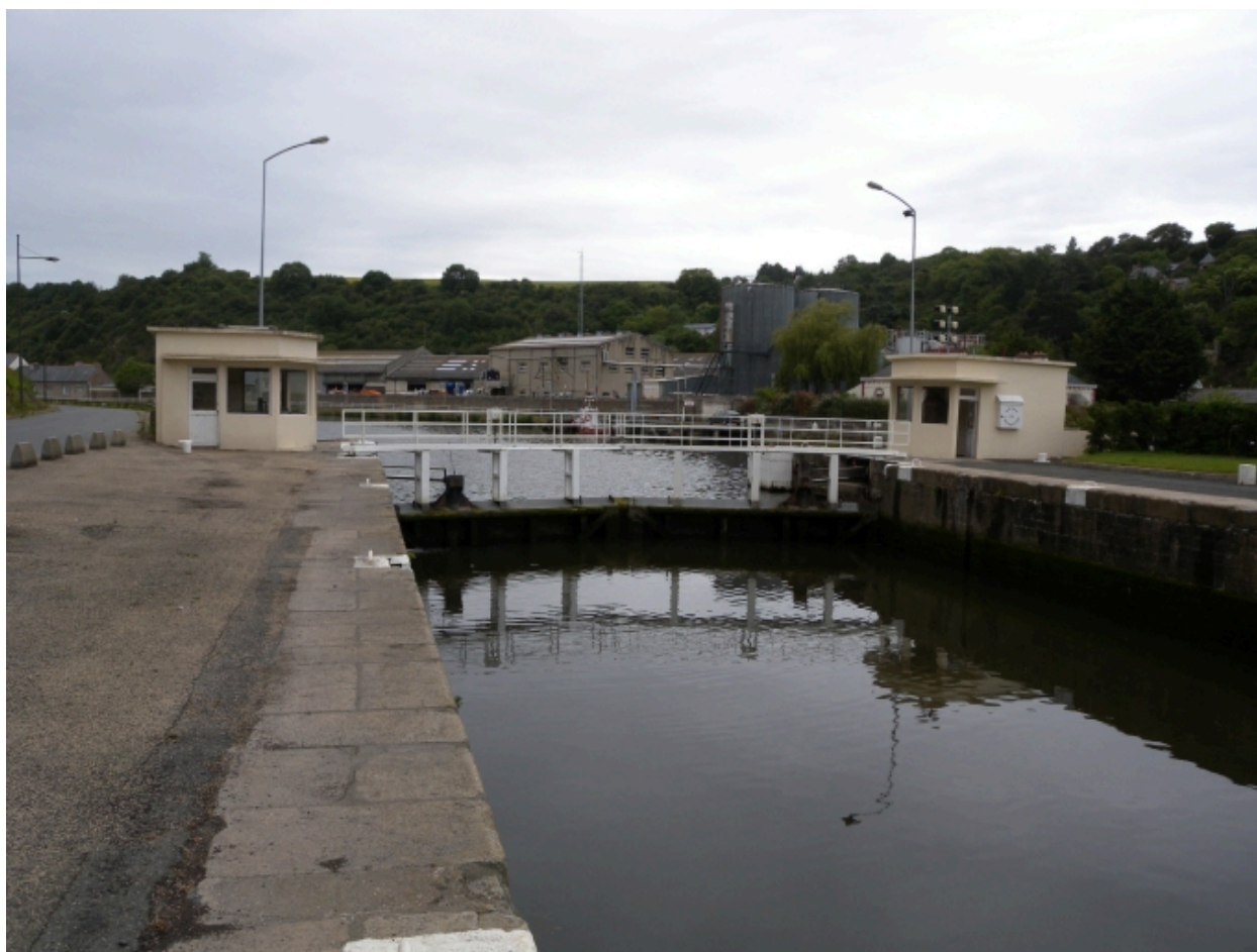
Vue du bassin à flot au niveau de l'écluse
