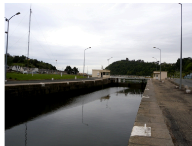
Vue du bassin à flot Phot. Guy Prigent IVR53_20082213132NUCA
