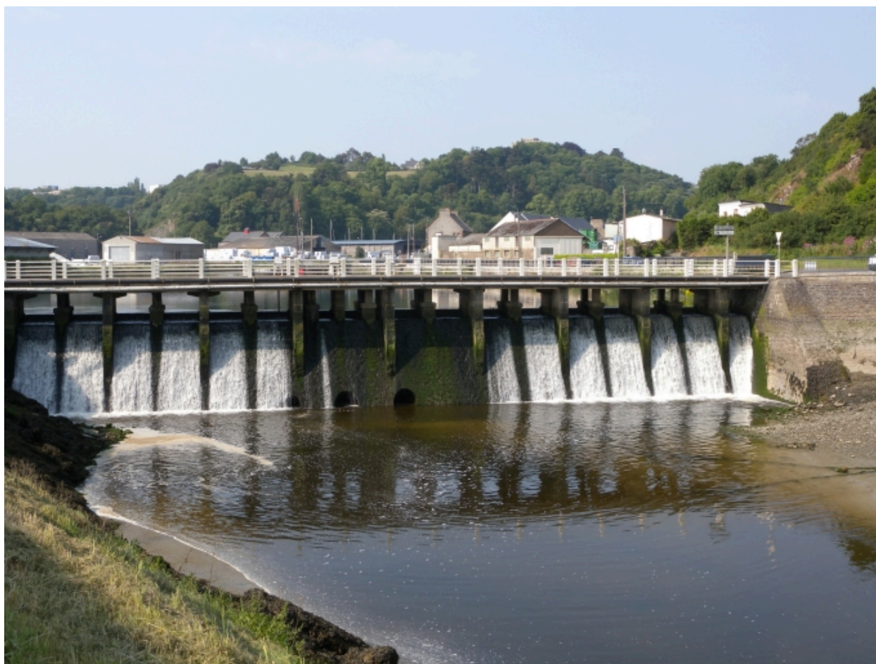
Vue du pont déversoir
