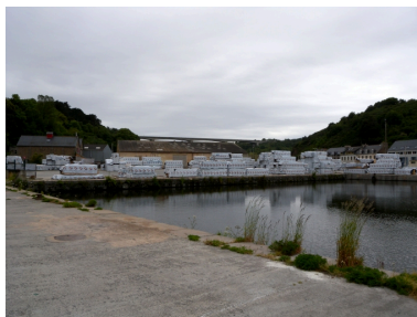
Vue de la partie Sud du bassin à flot Le Gouales de Mézaubran Phot. Guy Prigent IVR53_20082213133NUCA
