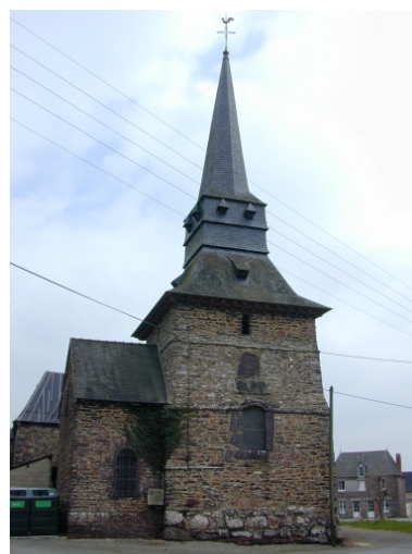
Détail : face ouest, la tour Phot. Malo Pichot IVR53_20023509846NUCA
