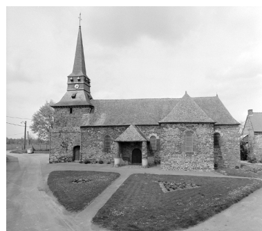
Vue générale sud Phot. Guy Artur, Phot. Norbert Lambert IVR53_19943500819X
