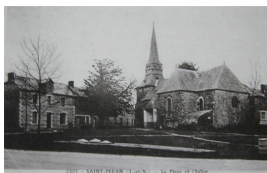
L'église paroissiale au début du 20e siècle Repro. Malo Pichot IVR53_20023509842NUC
