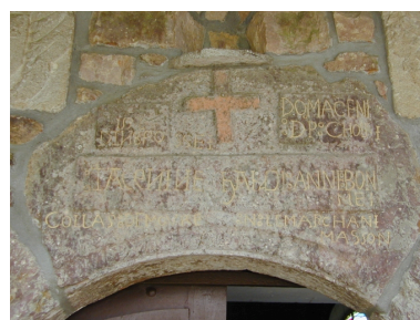
Détail : face sud, inscriptions de la porte datée 1592 Phot. Malo Pichot IVR53_20023509902NUCA
