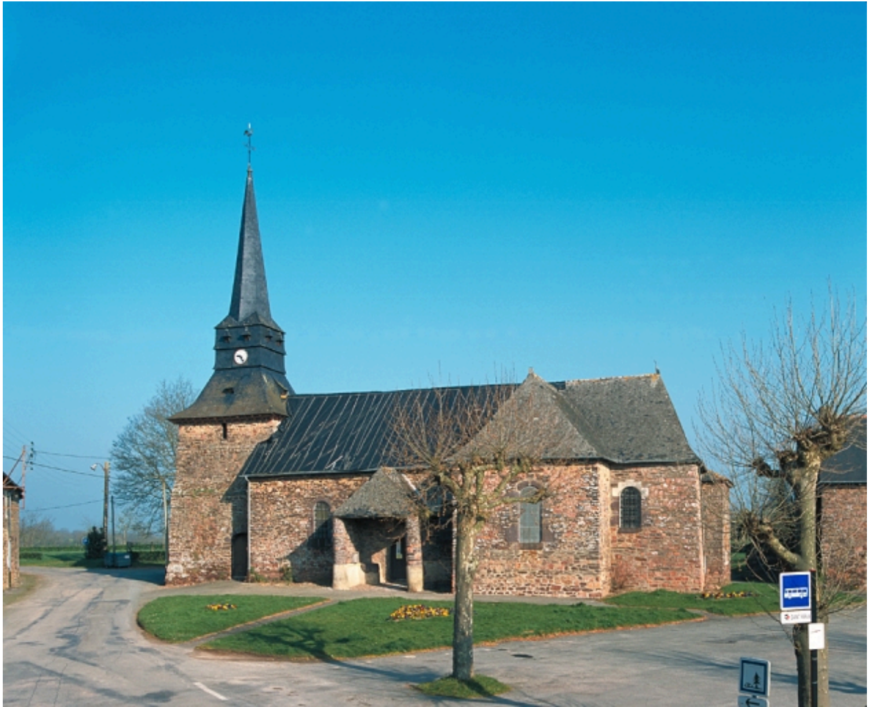
Vue générale sud
