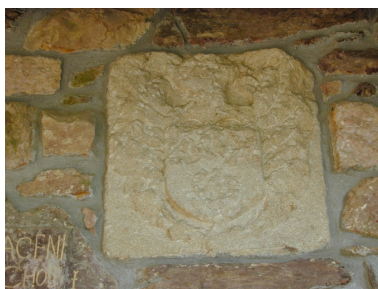
Détail : face sud, blason est sous le porche Phot. Malo Pichot IVR53_20023509904NUCA
