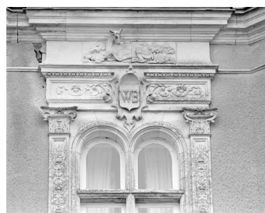
Elévation sud, travée centrale, détail de la sculpture au pied de la fenêtre centrale : attributs de la chasse. Phot. Guy Artur, Phot. Norbert Lambart IVR53_19963501640X
