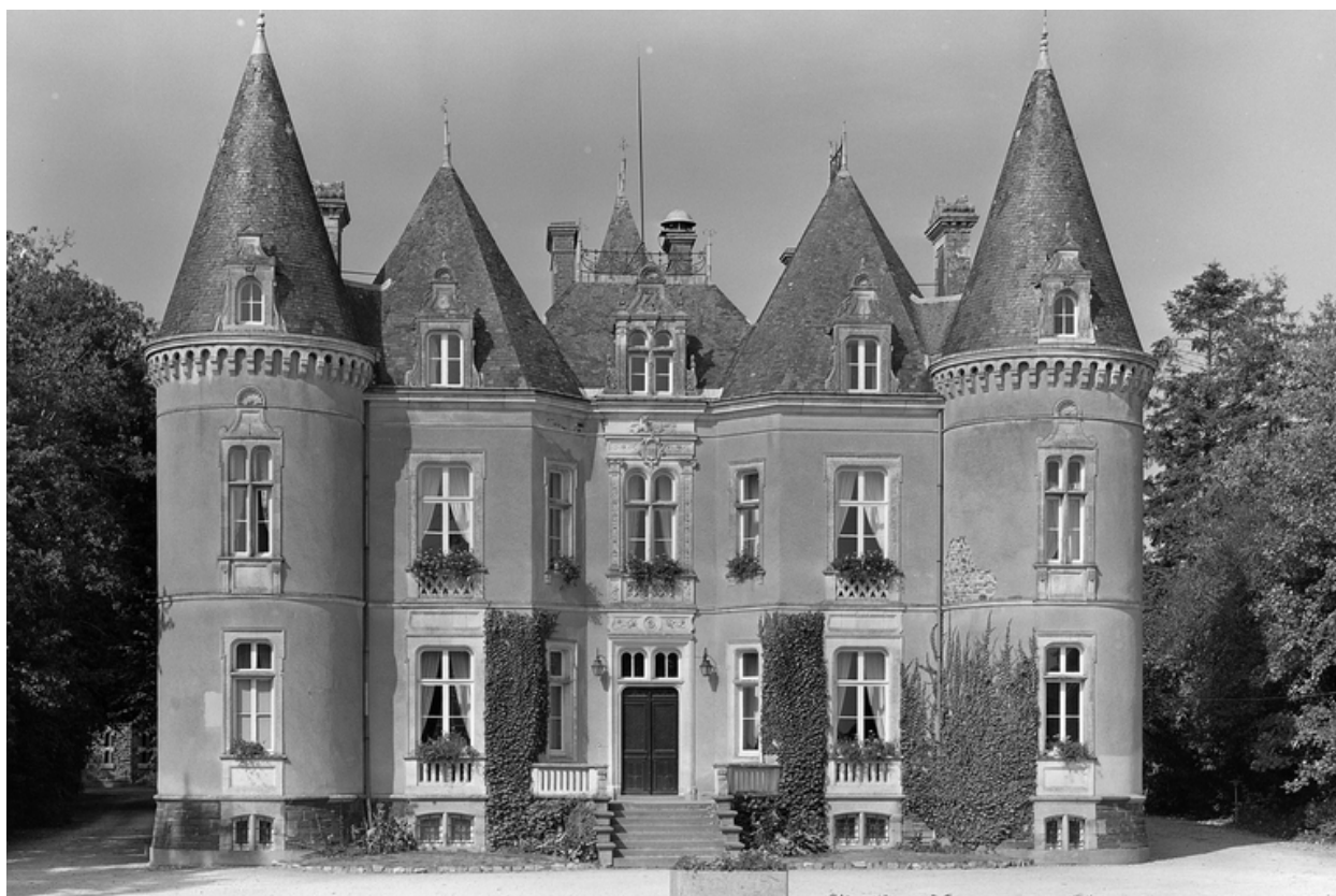
Vue générale du château.
