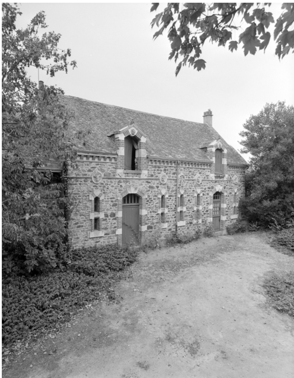
Communs : vue générale du bâtiment nord-est
