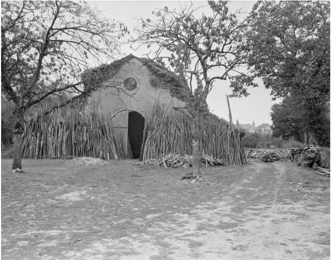
Vue du bâtiment du bûcher à l'arrière des communs.
