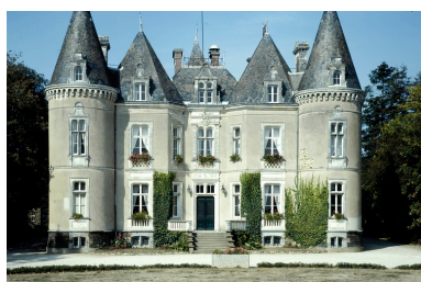
Vue générale Phot. Guy Artur, Phot. Norbert Lambart IVR53_19963501631VA
