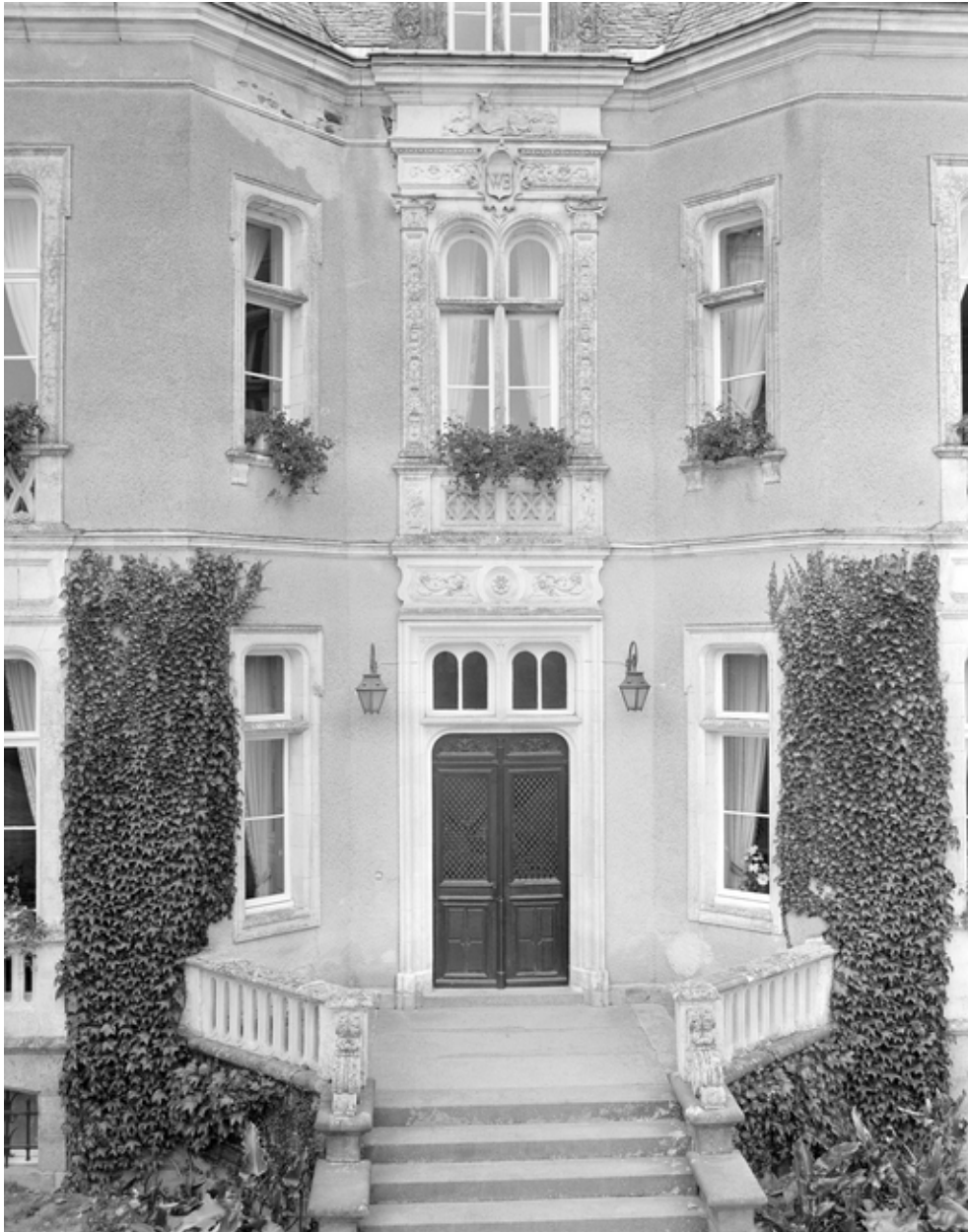
Elévation sud, détail de la travée centrale.
