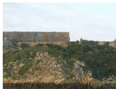
Vue latérale d'une poudrière Phot. Lénaïg L'Aot IVR53_20072908863NUCA
