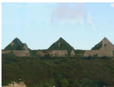
Vue des trois poudrières de l'île des Morts Phot. Lénaïg L'Aot IVR53_20072908862NUCA
