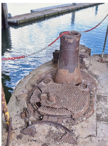
Vue de l'entrée de l'alvéole E (n° 17 et 18) : quai ouest n° 18 avec cabestan motorisé doté d'une commande à pied Phot. Bernard Bègne IVR53_20235600096NUCA
