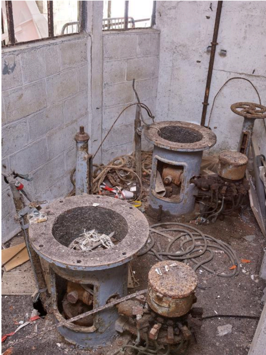
Vue de la salle des pompes située entre les alvéoles D (n° 19, 19a et 20) et E (n° 17 et 18) : les pompes ont été démontées
