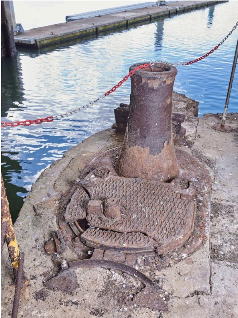
Vue de l'entrée de l'alvéole E (n° 17 et 18) : quai ouest n° 18 avec cabestan motorisé doté d'une commande à pied
