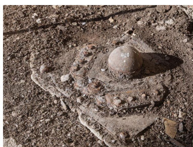
Vue de l'entrée de l'alvéole E (n° 17 et 18) : rotule métallique d'emboîtement qui permet la rotation de la porte blindée de l'alvéole Phot. Bernard Bègne IVR53_20235600095NUCA
