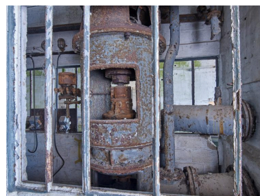
Vue de la salle des pompes située entre les alvéoles D (n° 19, 19a et 20) et E (n° 17 et 18) Phot. Bernard Bègne IVR53_20235600085NUCA
