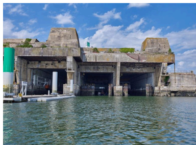
Vue de l'entrée des alvéoles E, F et G Phot. Bernard Bègne IVR53_20215600530NUCA
