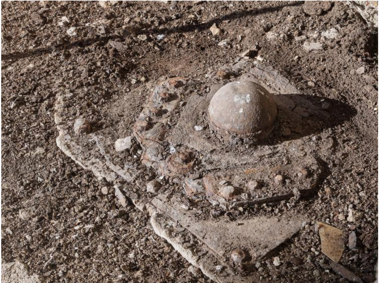
Vue de l'entrée de l'alvéole E (n° 17 et 18) : rotule métallique d'emboîtement qui permet la rotation de la porte blindée de l'alvéole
