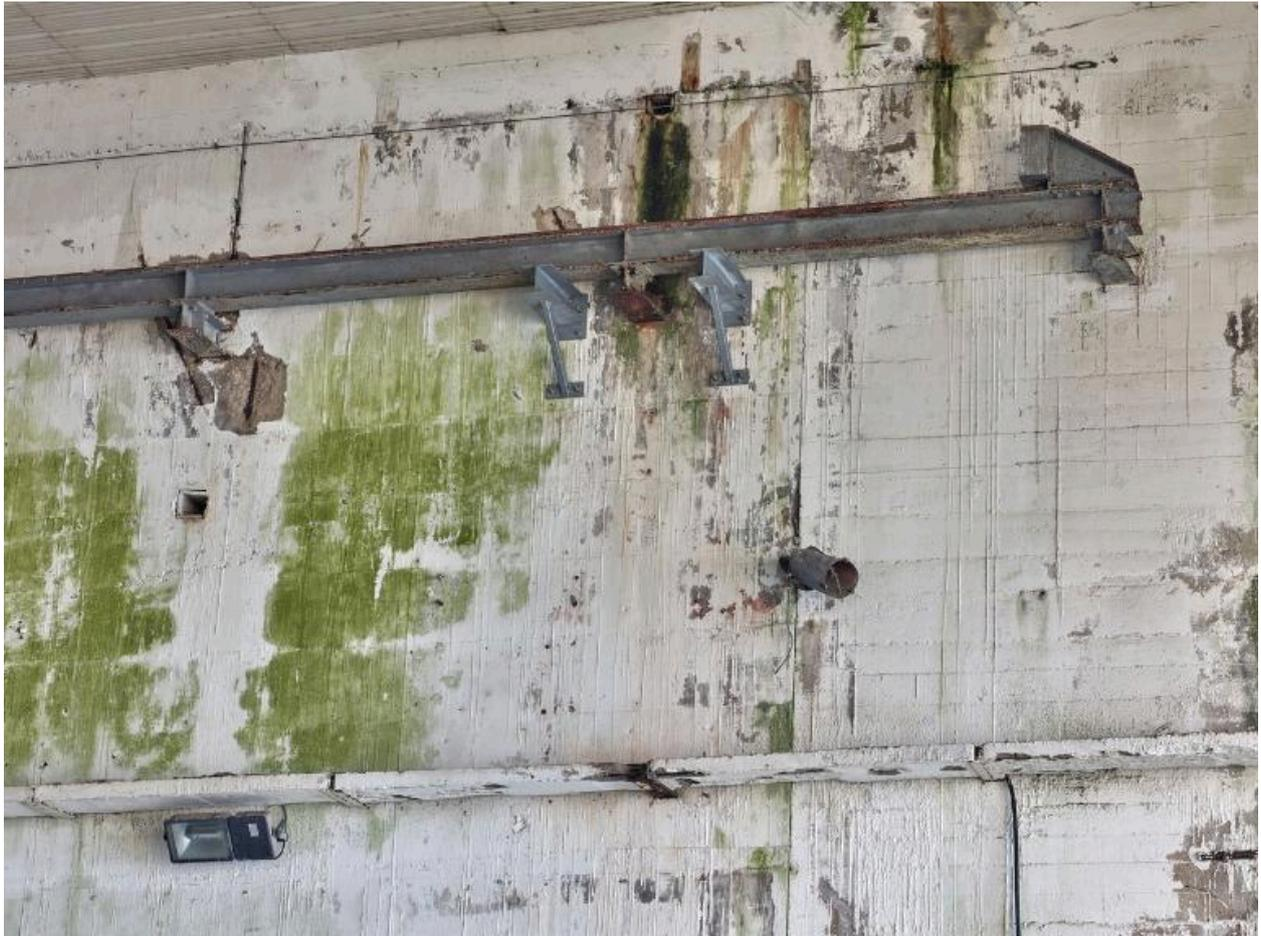
Vue de l'alcôve E (n° 17 et 18) : côté quai est n° 17, chemin de roulement du pont-roulant et projecteur dirigé vers les portes d'écluse
