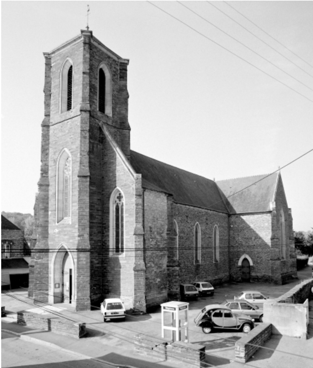
Elévation Nord-Est : vue générale
