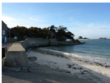
Vue générale du mur en béton, du blockhaus associé et de la cale neuve Phot. Guy Prigent IVR53_20082211200NUCA
