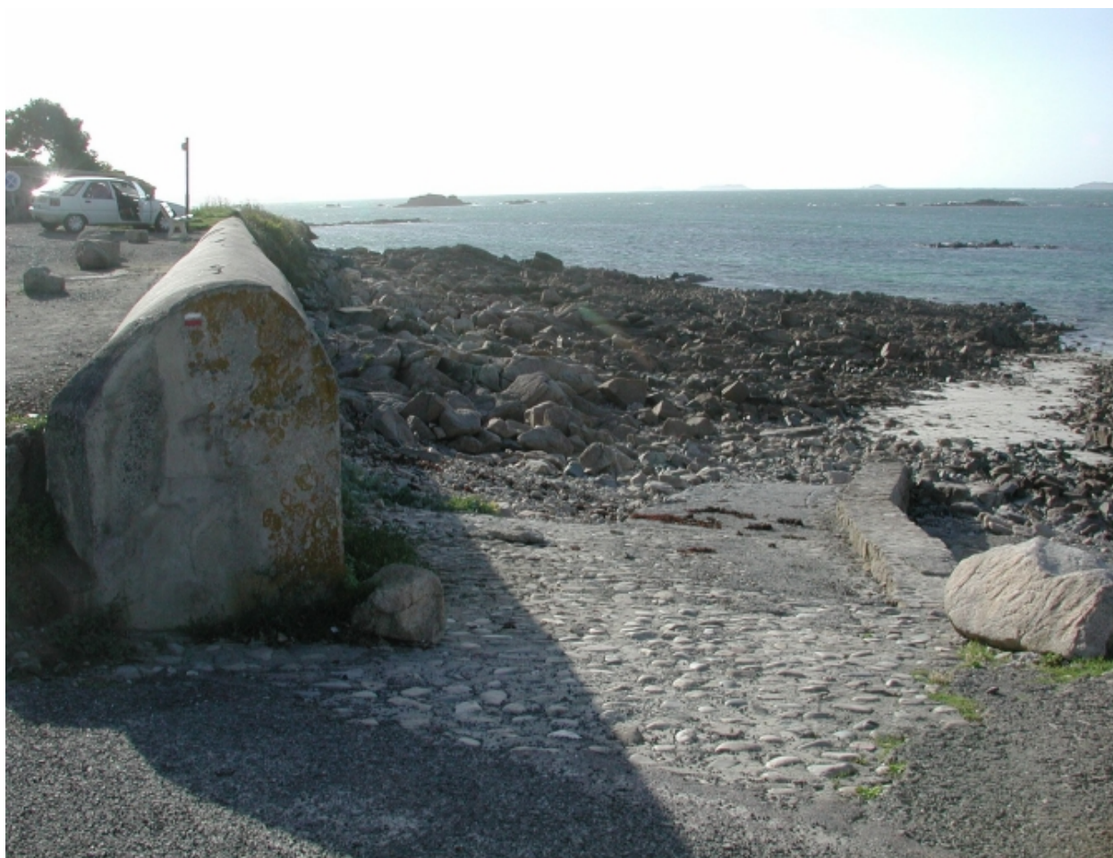
Vue de l'ancienne cale de Rohanig et du mur-digue qui la prolonge vers l'Ouest
