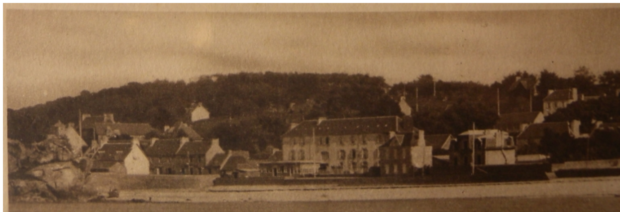
Vue du front de mer du Port-Blanc et en particulier du mur de défense contre la mer, avant la construction de la digue, 1er quart 20ème siècle (collection particulière)
