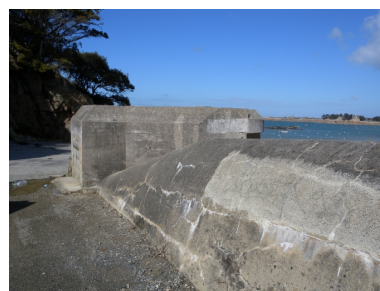
Vue du blockhaus situé au niveau de la cale neuve et dans le prolongement du mur de défense de la seconde guerre mondiale Phot. Guy Prigent IVR53_20082211197NUCA
