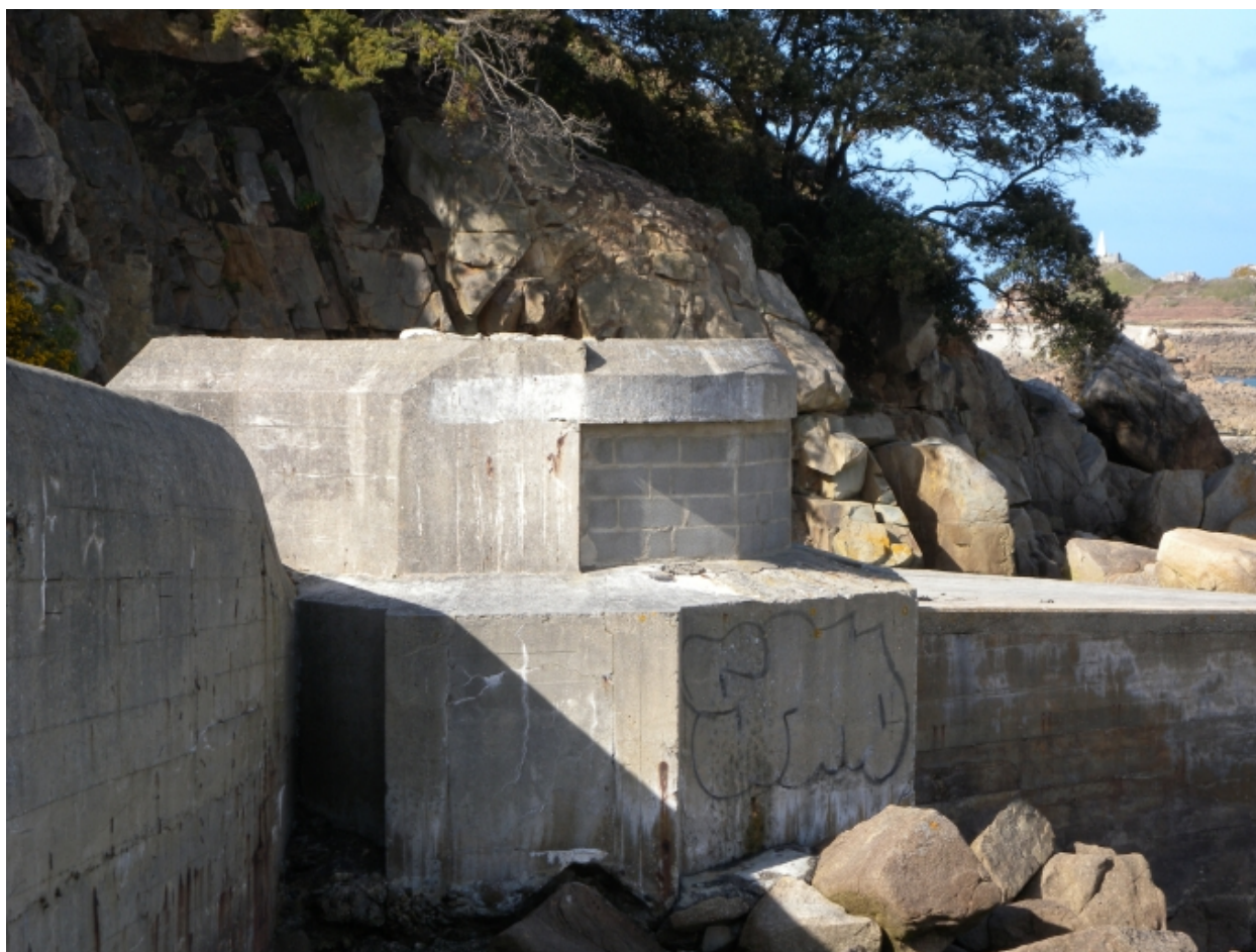
Vue du blockhaus et de la cale neuve à l'extrémité de la digue promenade
