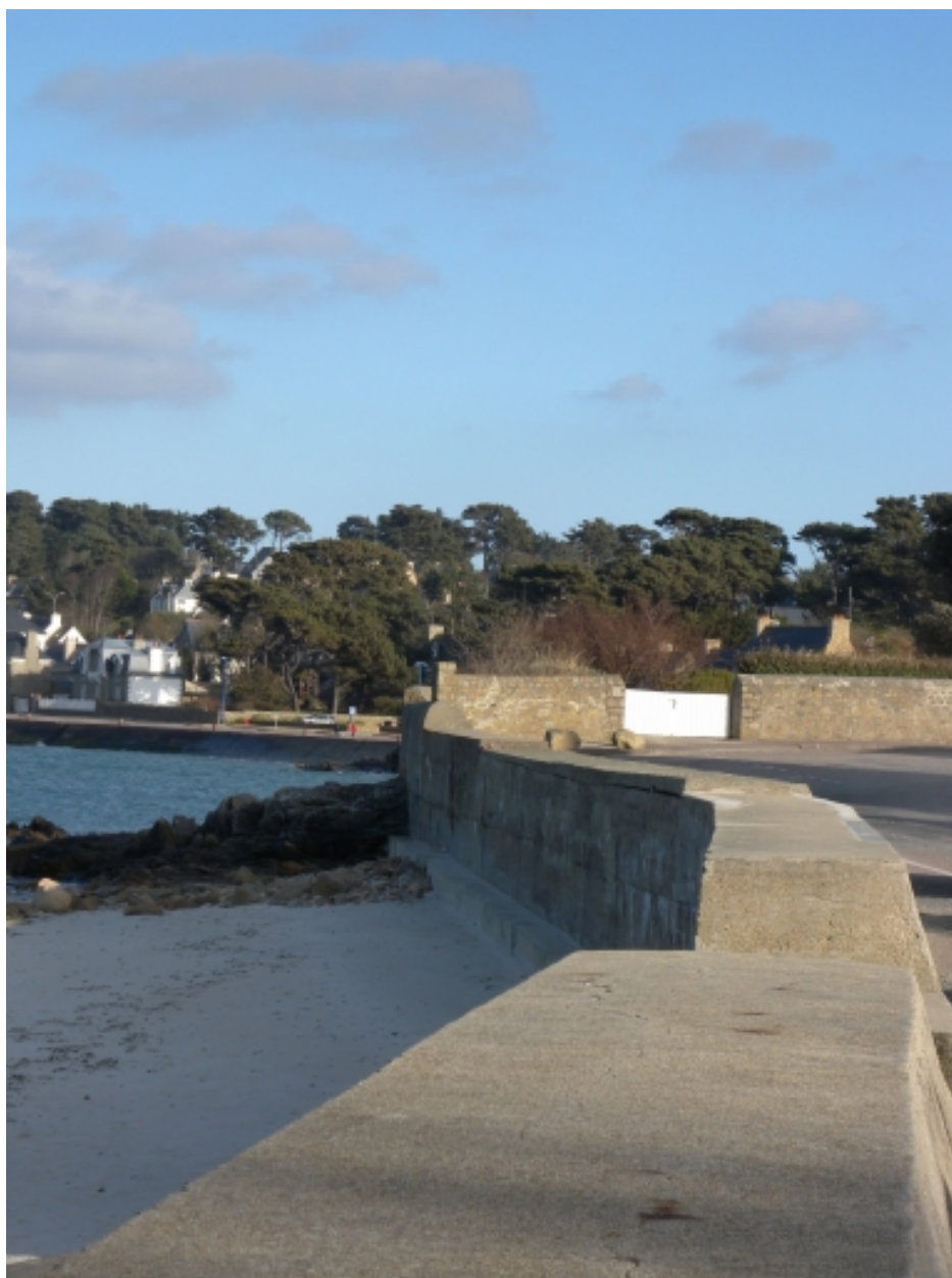
Vue du mur en béton de forme rectiligne, construit par les soldats allemands de l'organisation Todt
