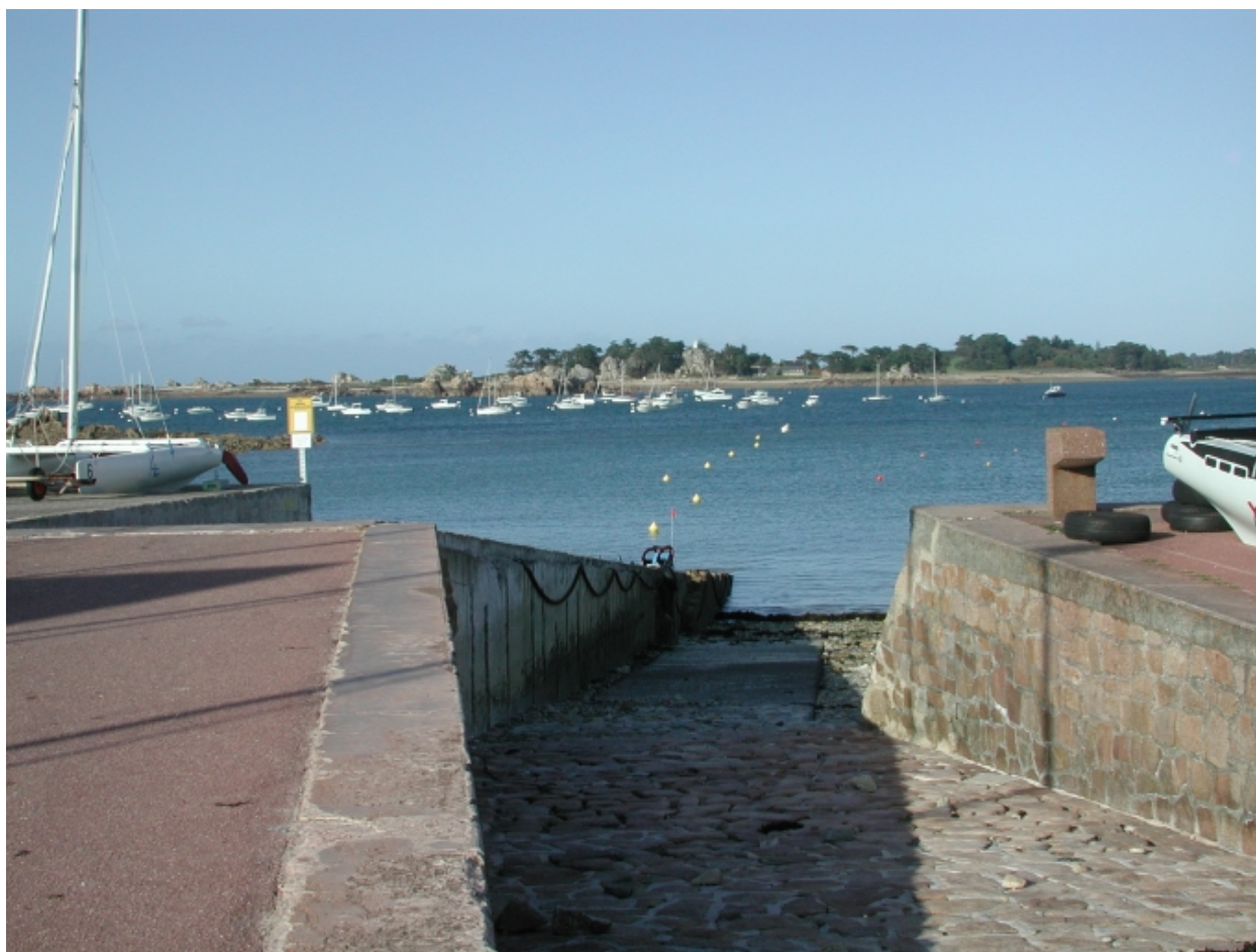
Vue de la cale de l'école de voile, perpendiculaire à la digue-promenade, côté Ouest
