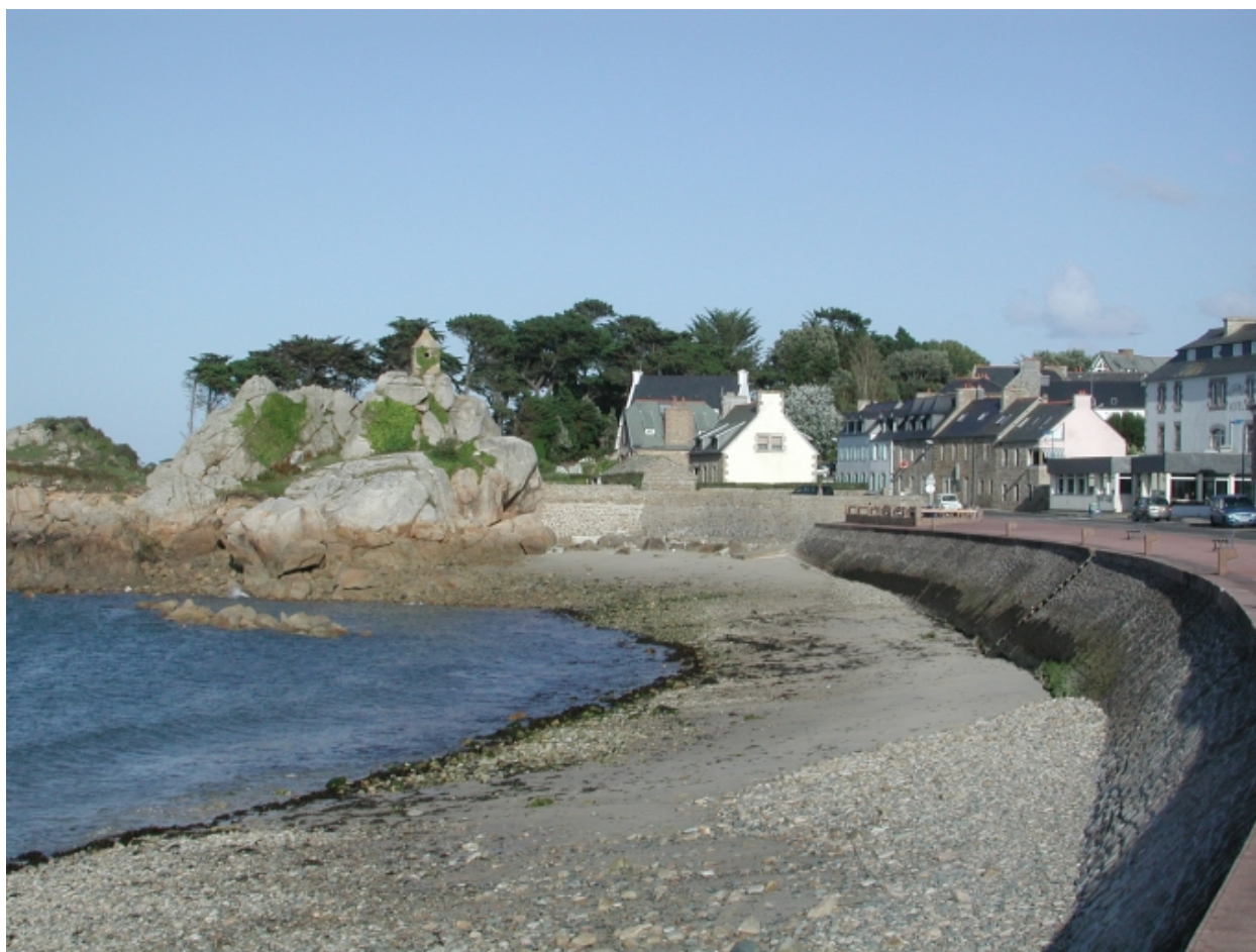
Vue générale de la digue-promenade
