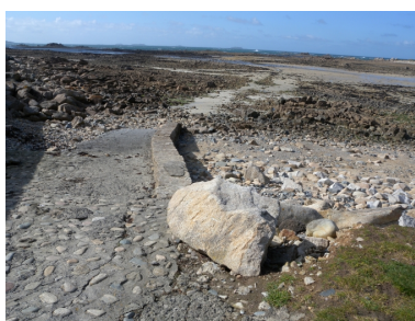
Vue de l'ancienne cale de Rohanig Phot. Guy Prigent IVR53_20082211205NUCA
