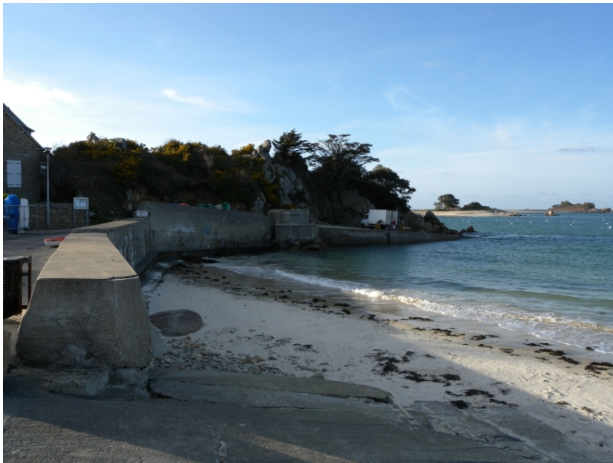
Vue générale du mur en béton, du blockhaus associé et de la cale neuve
