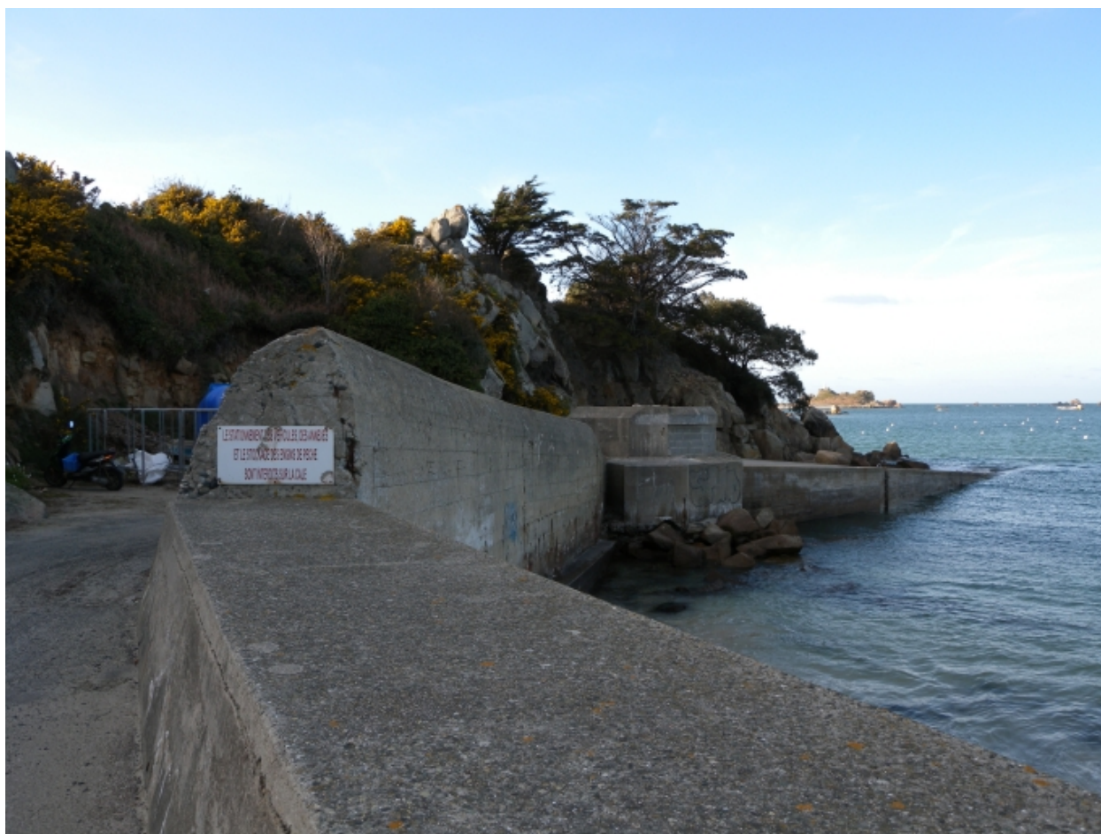
Vue de détail de la forme du mur et du parapet en béton de l'organisation Todt
