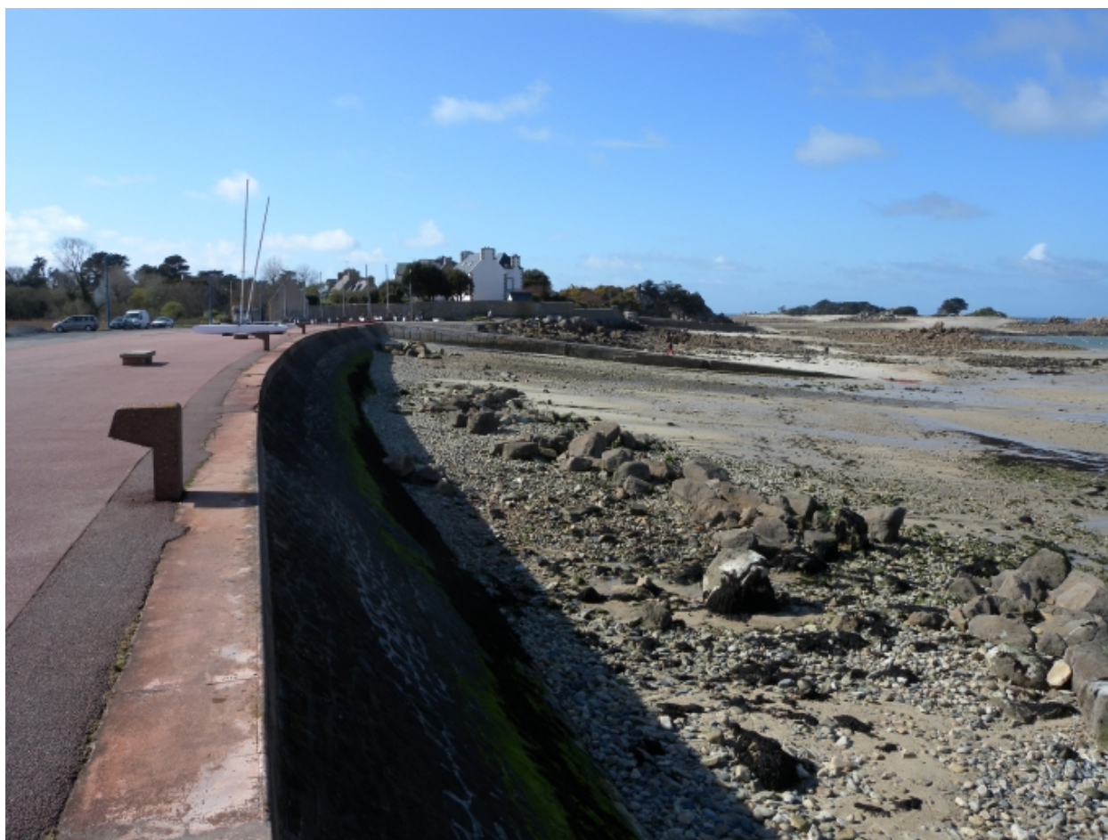
Vue du profil de la digue et des cales
