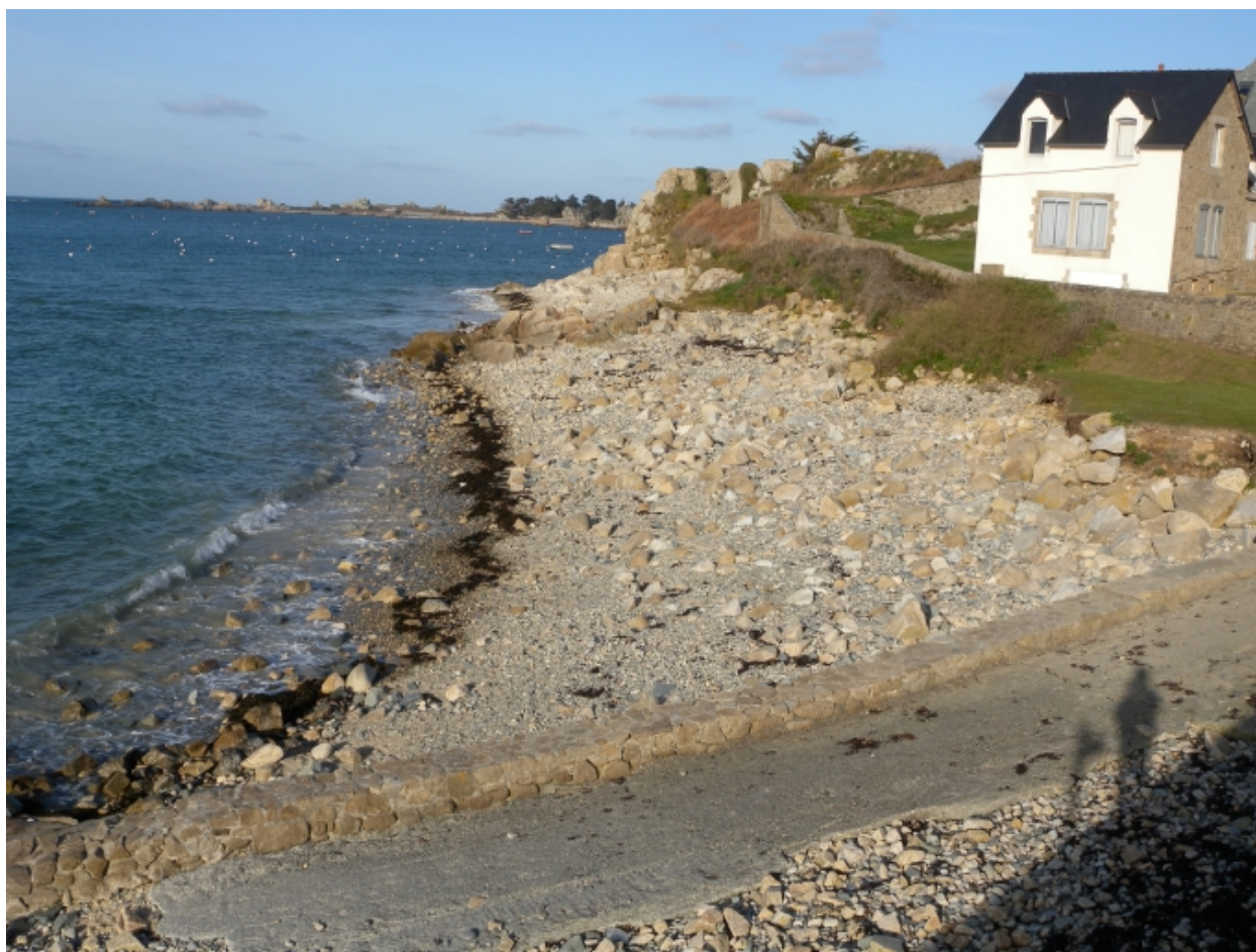
Vue d'ensemble de l'ancienne cale de Rohanig et les murs de défense contre la mer
