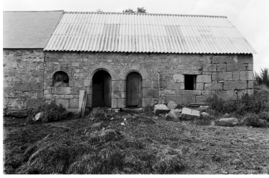
Vue générale Phot. Didier Cadiou IVR53_19672200161Z
