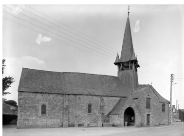
Elévation Sud : vue générale Phot. Guy Artur, Phot. Norbert Lambart IVR53_19773500416V
