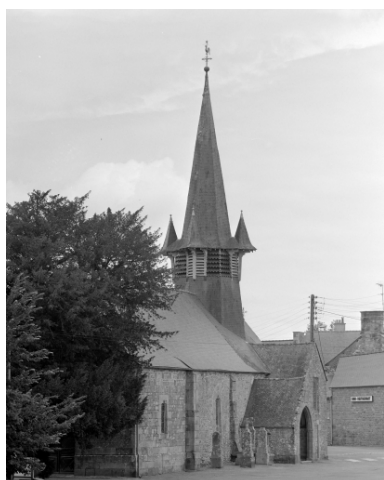
Elévation Sud-Ouest : vue générale Phot. Guy Artur, Phot. Norbert Lambart IVR53_19943501280X
