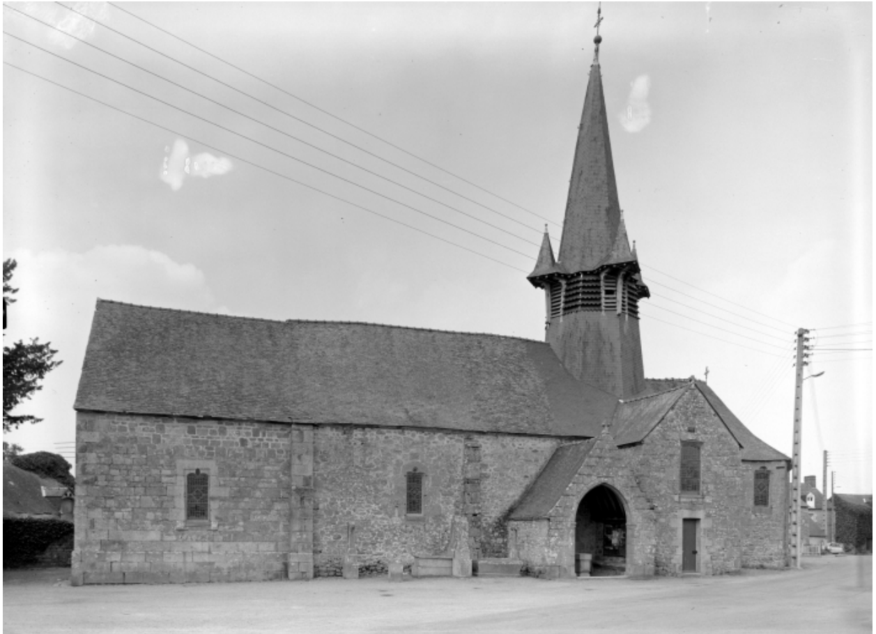
Elévation Sud : vue générale
