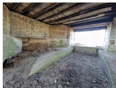
Vue de l'ensemble fortifié A 5 : bunker-casemate pour canon de 5 cm ou 7,5 cm, chambre de combat depuis l'entrée est. Rampes inclinées et rainures permettaient de faire monter puis de caler les roues de l'affût du canon
