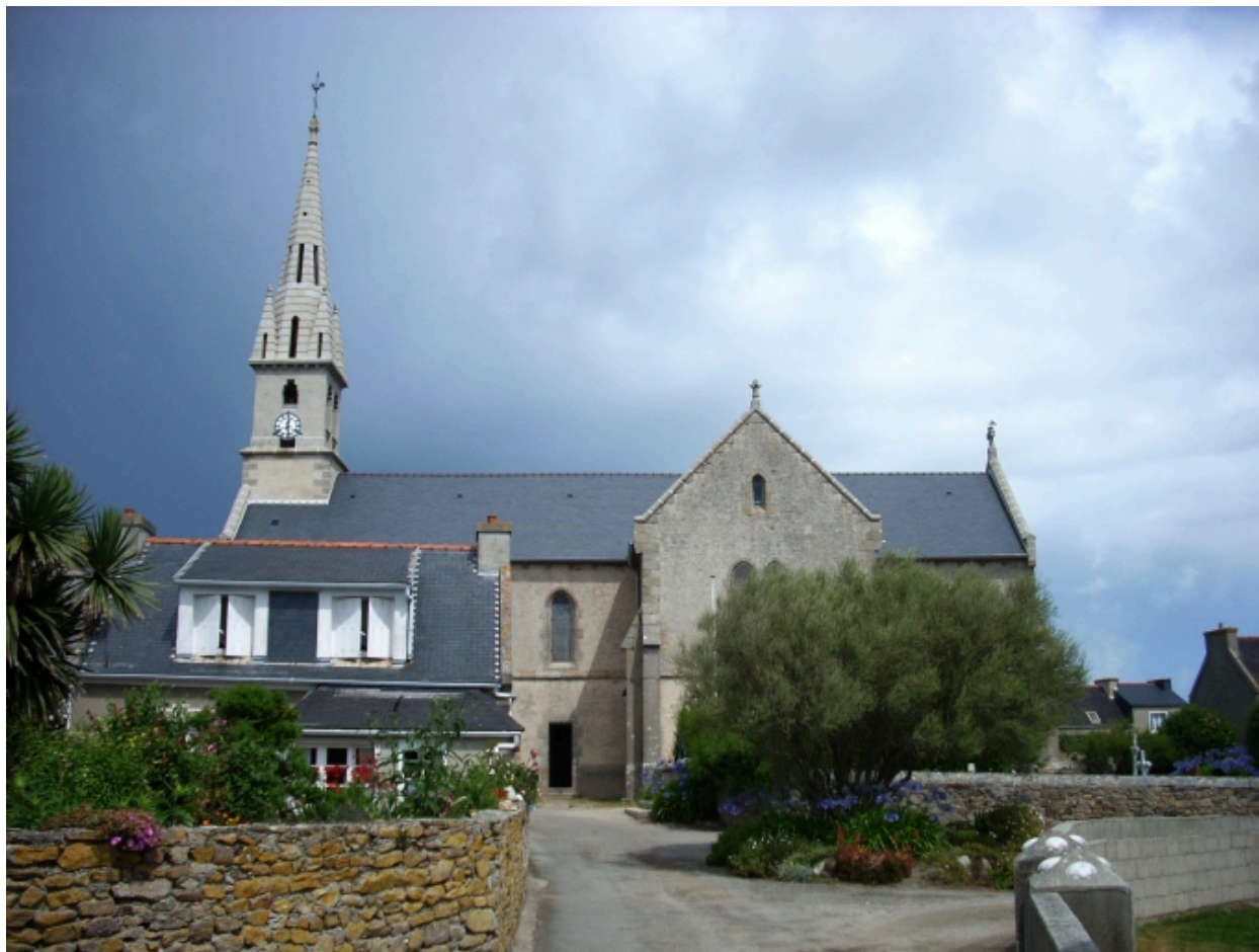
Ile-Molène, église paroissiale Saint-Ronan : élévation sud
