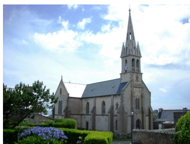
Ile-Molène, église paroissiale Saint-Ronan : vue générale nord-ouest Phot. Gwénaél Fauchille IVR53_20082906497NUCA
