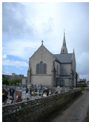
Ile-Molène, église paroissiale Saint-Ronan : vue générale nord-ouest Phot. Gwénaél Fauchille IVR53_20082906499NUCA
