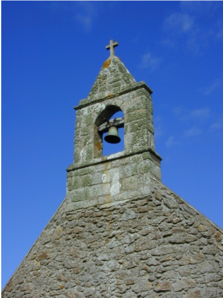
Détail : le clocher-mur vu de l'ouest
