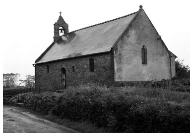
Vue générale sud-est Phot. Guy Artur, Phot. Norbert Lambart IVR53_19923500780X
