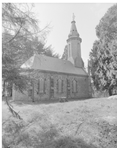
Elévation Nord : vue générale Phot. Bernard Bègne, Phot. M. Loyon IVR53_19933500325X
