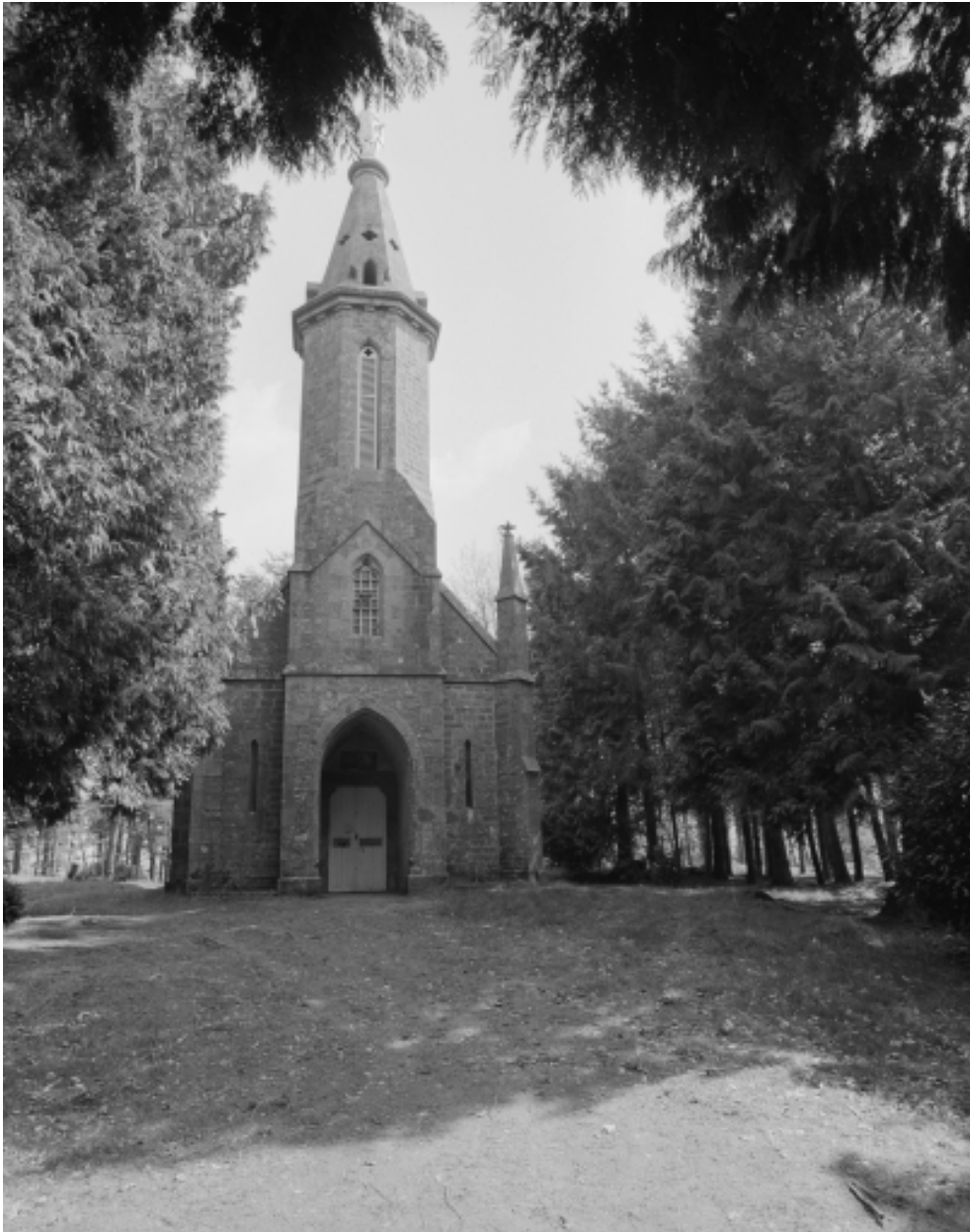
Elévation Ouest : vue générale
