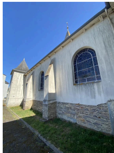
Vue sud-est Phot. Baptiste Oligo IVR53_20255610913NUCA
