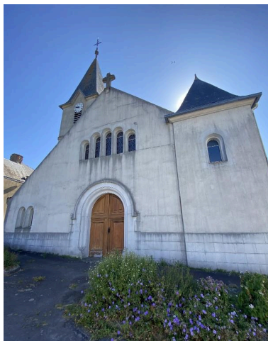
Vue ouest Phot. Baptiste Oligo IVR53_20255610918NUCA
