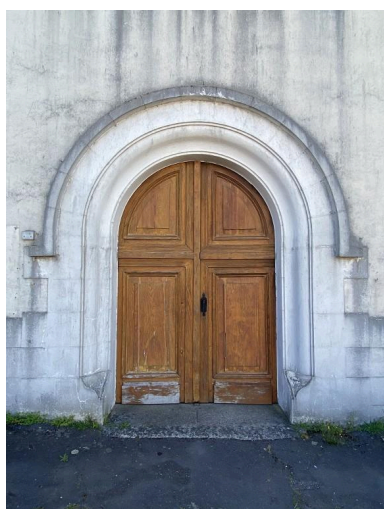
Porte, façade ouest Phot. Baptiste Oligo IVR53_20255610914NUCA
