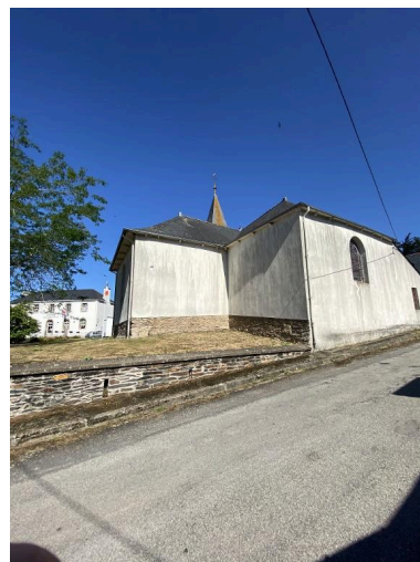
Vue sud-est Phot. Baptiste Oligo IVR53_20255610917NUCA
