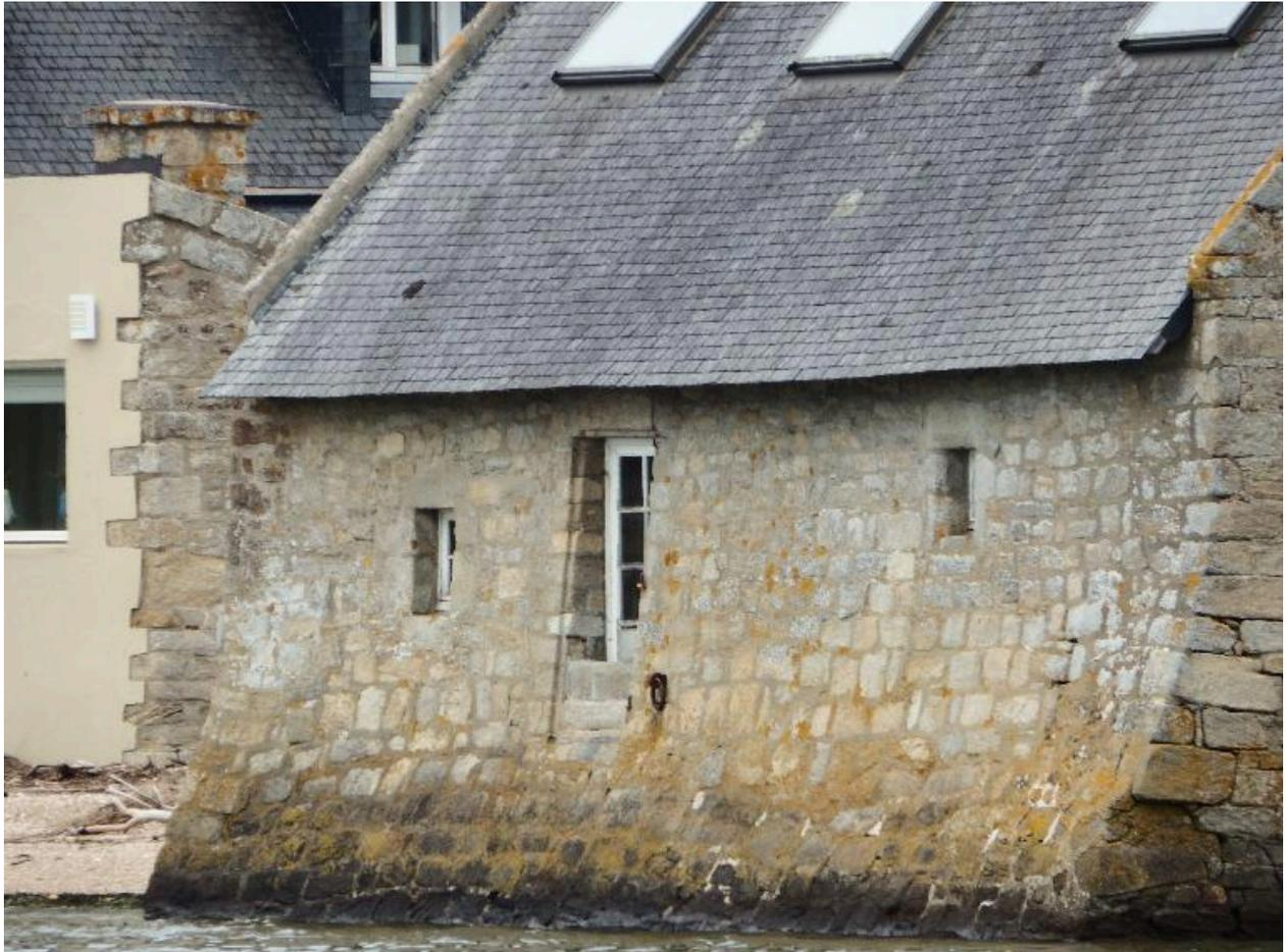
Façade aval, vue sur la porte haute. Un anneau d'amarrage est encore visible et l'on peut aussi distinguer des marches alors qu'habituellement les portes hautes étaient de simples ouvertures, accessibles par échelle.
