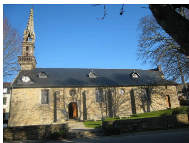
Vue générale de l'église Saint-Eloi Phot. Françoise Péron IVR53_20072908908NUCA
