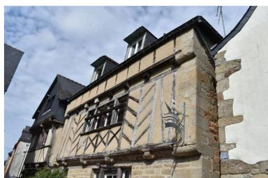
Détail de la façade en pan de bois avec encorbellement sur solives
