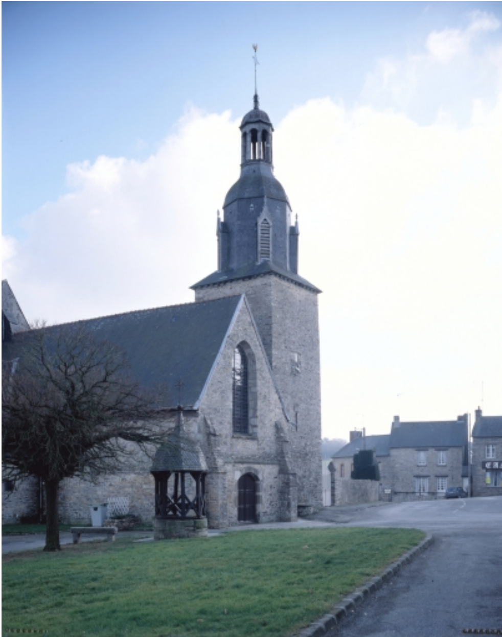
Elévation ouest : vue générale.
