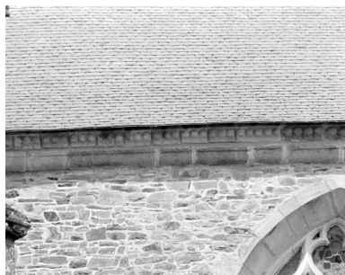
Elévation sud, mur sud du choeur, détail de la corniche. Phot. Guy Artur, Phot. Norbert Lambart IVR53_19843500422X
