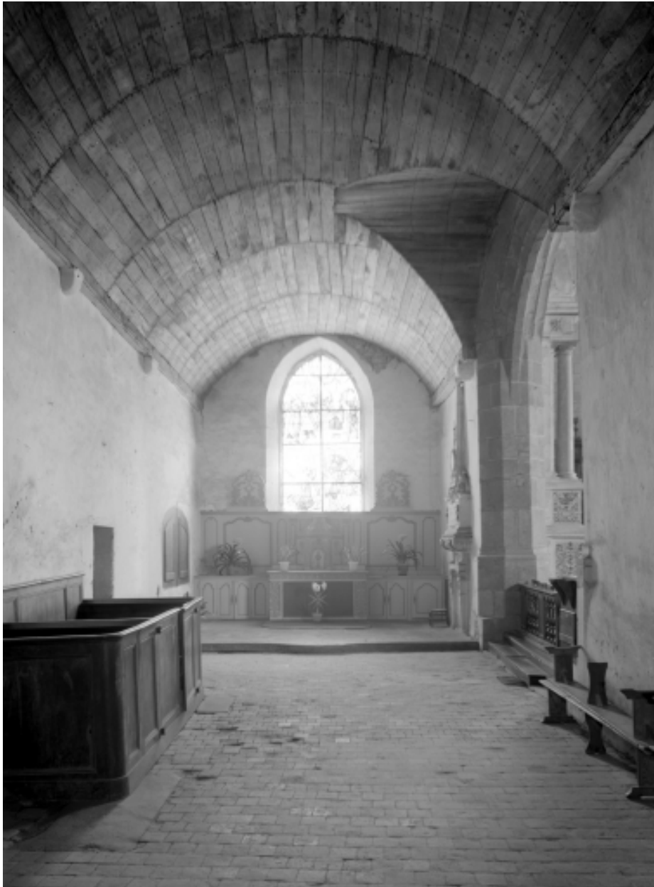
L'arcade prise du sud, vue générale vers l'est.
