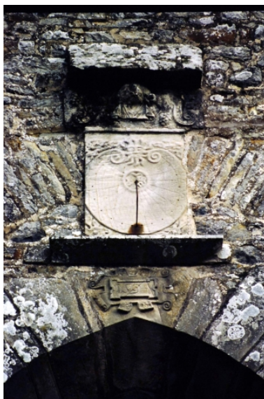
Elévation sud, détail blason et cadran solaire Phot. Auteur inconnu IVR53_19943503103ZA
