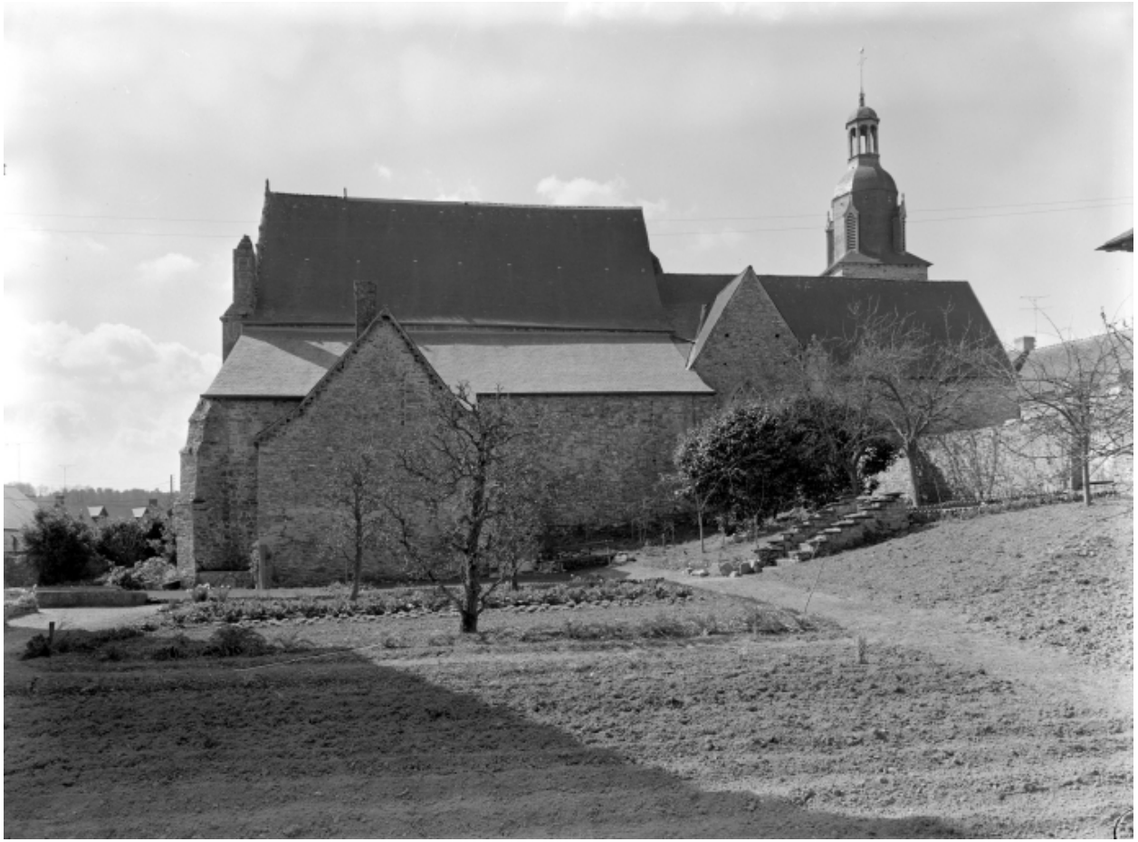
Elévation nord, vue générale prise du jardin du presbytère.
