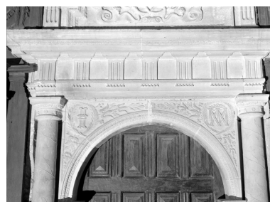
Porte sud de la sacristie, détail du premier entablement pris par dessous (frise sculptée) Phot. Guy Artur, Phot. Norbert Lambart IVR53_19843500548V
