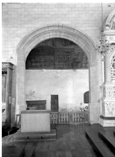
Chapelle nord n°2, vue axiale de l'arcade prise du sud. Phot. Guy Artur, Phot. Norbert Lambart IVR53_19843500551V
