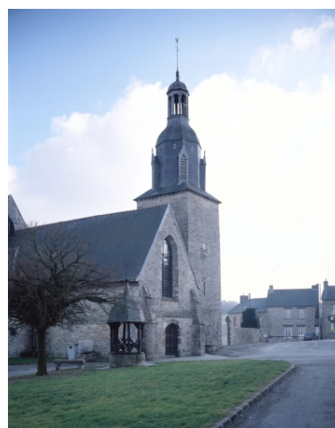
Elévation ouest : vue générale. Phot. Guy Artur, Phot. Norbert Lambart IVR53_19913500018VA
