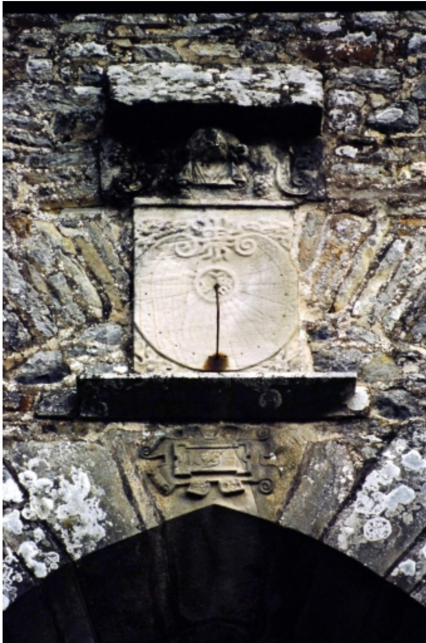
Elévation sud, détail blason et cadran solaire
