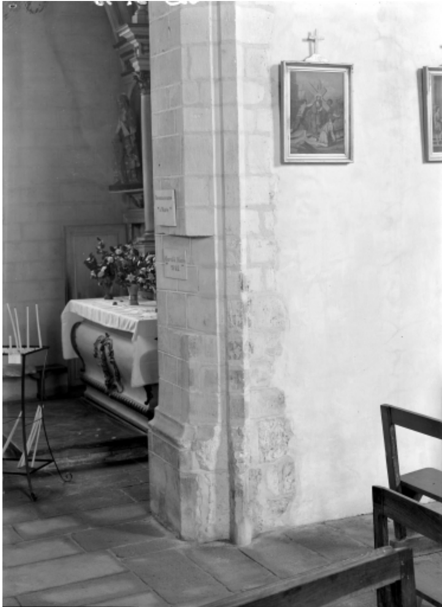
Chapelle nord n°1, détail de la base de l'arc au sud.
