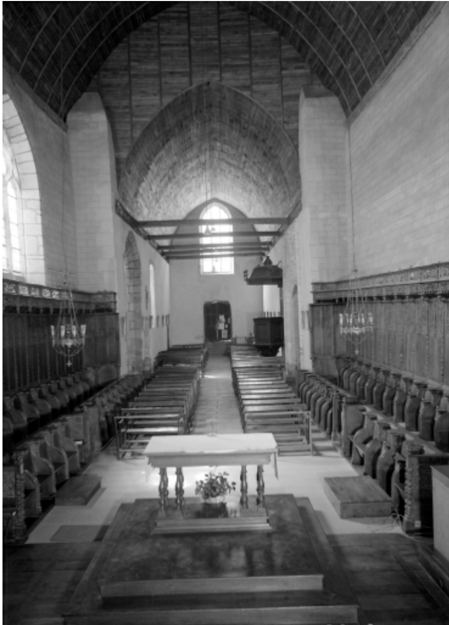
Vue générale de la nef vers l'ouest.
