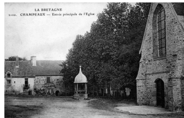
2100. Champeaux - Entrée principale de l'église. Carte postale ancienne. IVR53_19843501201V
