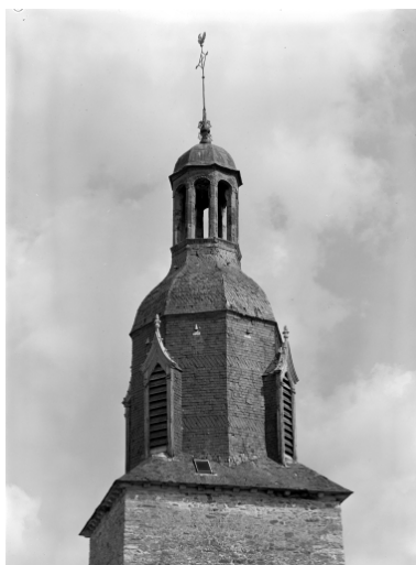
Clocher, détail de la toiture. Phot. Guy Artur, Phot. Norbert Lambart IVR53_19843500415V
