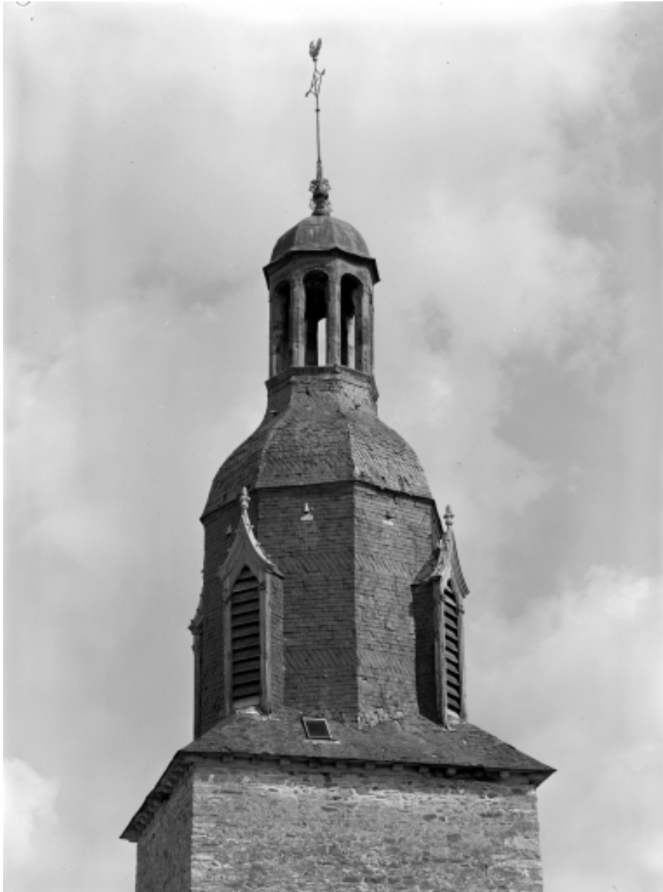
Clocher, détail de la toiture.
