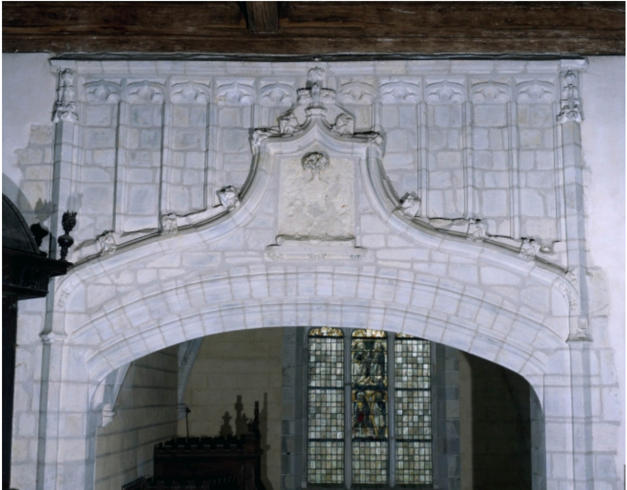
Détail sculpté de la partie supérieure de la porte.
