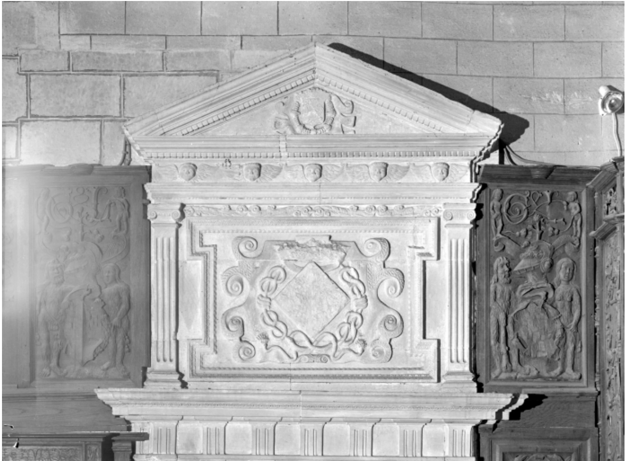
Porte sud de la sacristie, détail du couronnement dans son ensemble avec les deux écussons
