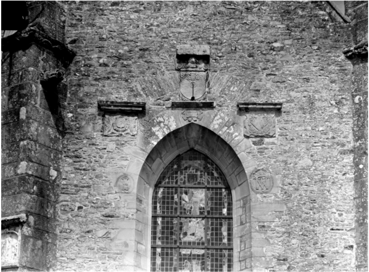
Elévation sud, détail blason et cadran solaire
