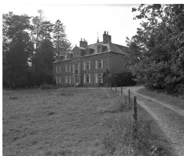
Vue générale sud-est Phot. Guy Artur IVR53_19773500157X
