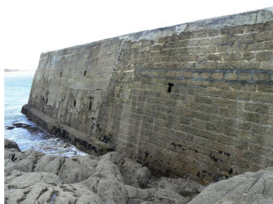
Extrémité du môle de la Grande Vache renforcé par du béton Phot. Julien Amghar IVR53_20082908554NUCA
