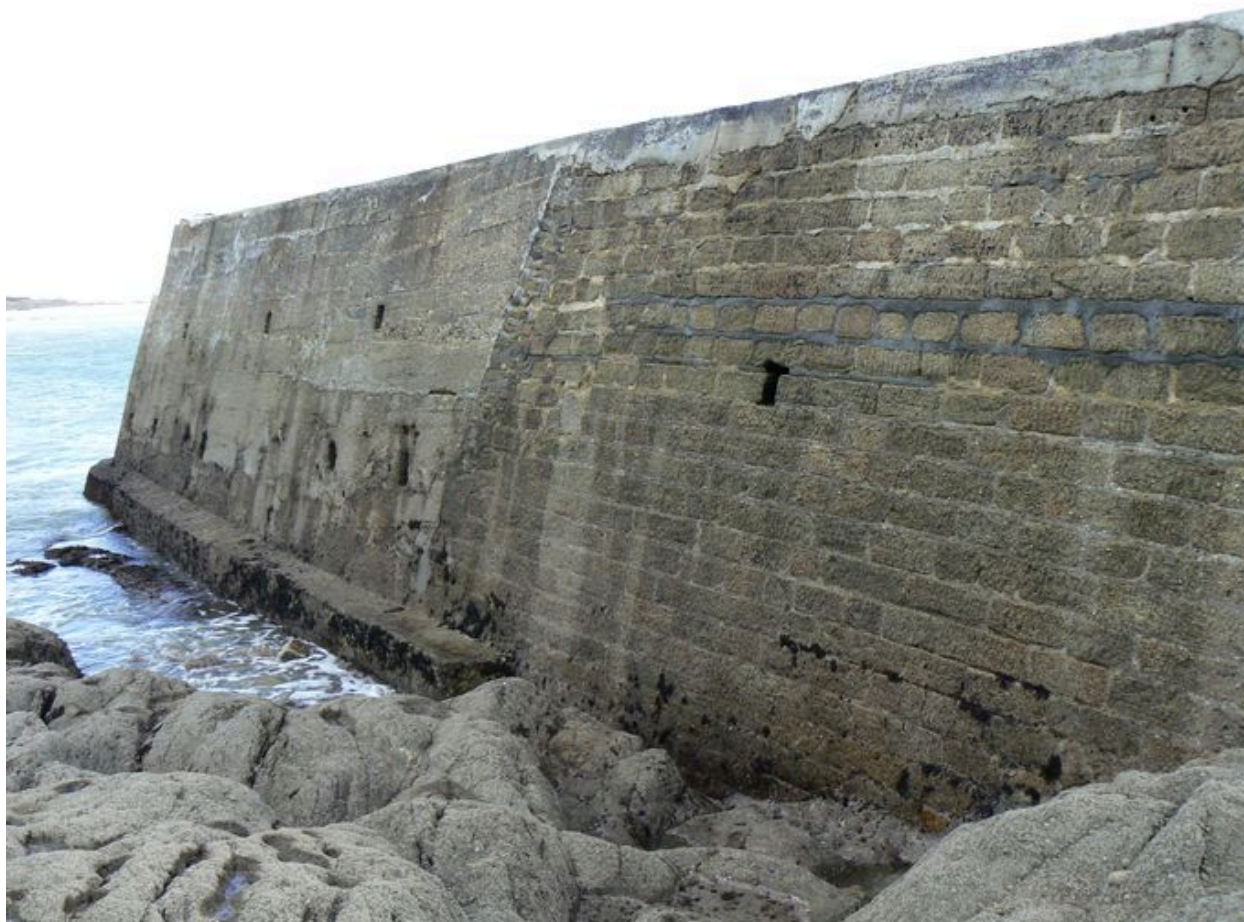
Extrémité du môle de la Grande Vache renforcé par du béton
