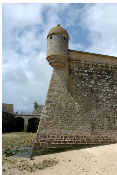
Vue de la citadelle de Port- Louis : échauguette de la demi- lune. En arrière-plan : le pont- dormant de la demi-lune et l'échauguette du bastion de Groix Phot. Guillaume Lécueillier IVR53_20065605217NUCA
