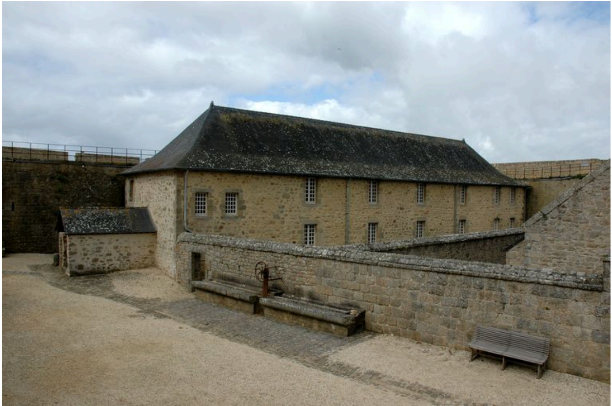
Vue de la citadelle de Port-Louis : arsenal avec son entrée couverte à l'épreuve d'un bombardement
