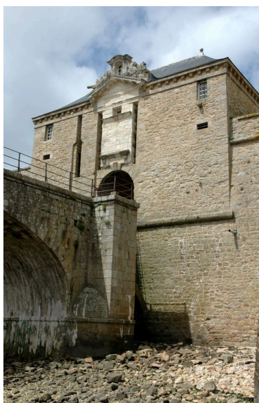
Vue de la citadelle de Port- Louis : pile du grand pont en granite permettant de franchir
