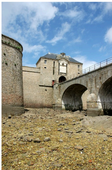
Vue de la citadelle de Port- Louis : piles du grand pont en granite permettant de franchir le canal, pont-levis et porte monumentale du corps de place Phot. Guillaume Lécueillier IVR53_20065605230NUCA
