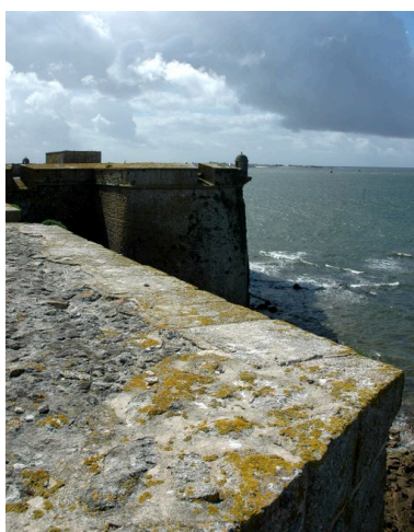
Vue de la citadelle de Port- Louis : embrasures plongeantes et échauguette du bastion à orillon des Chambres Phot. Guillaume Lécueillier IVR53_20065605272NUCA
