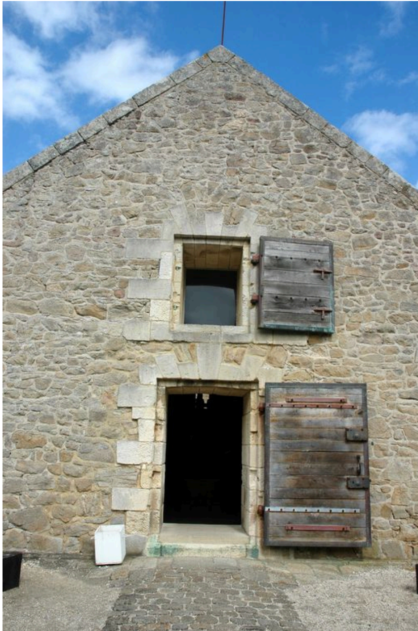
Vue de la citadelle de Port-Louis : entrée du magasin à poudre et sa baie d'aération
