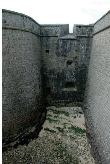
Vue de la citadelle de Port-Louis : embrasures sud protégées par l'orillon du bastion de Groix et flanquant la porte du corps de place Phot. Guillaume Lécueillier IVR53_20065605224NUCA
