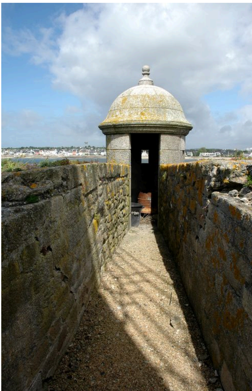
Vue de la citadelle de Port-Louis : échauguette du grand bastion
