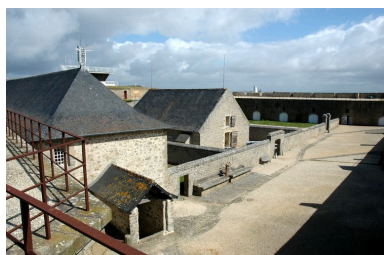
Vue de la citadelle de Port-Louis : arsenal, magasin à poudre et parc à boulets Phot. Guillaume Lécueillier IVR53_20065605261NUCA
