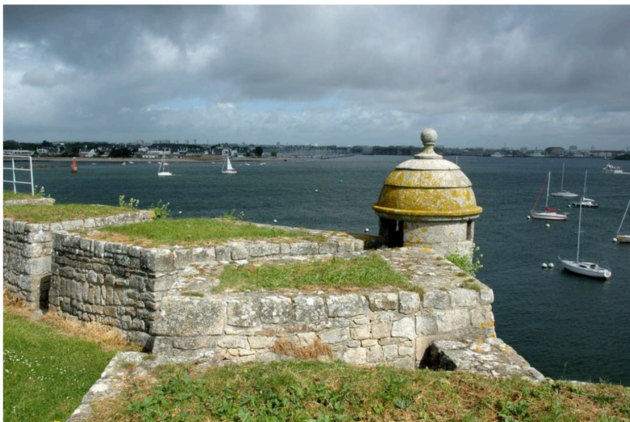
Vue de la citadelle de Port-Louis : bastion de la Brèche, embrasures plongeantes et échauguette
