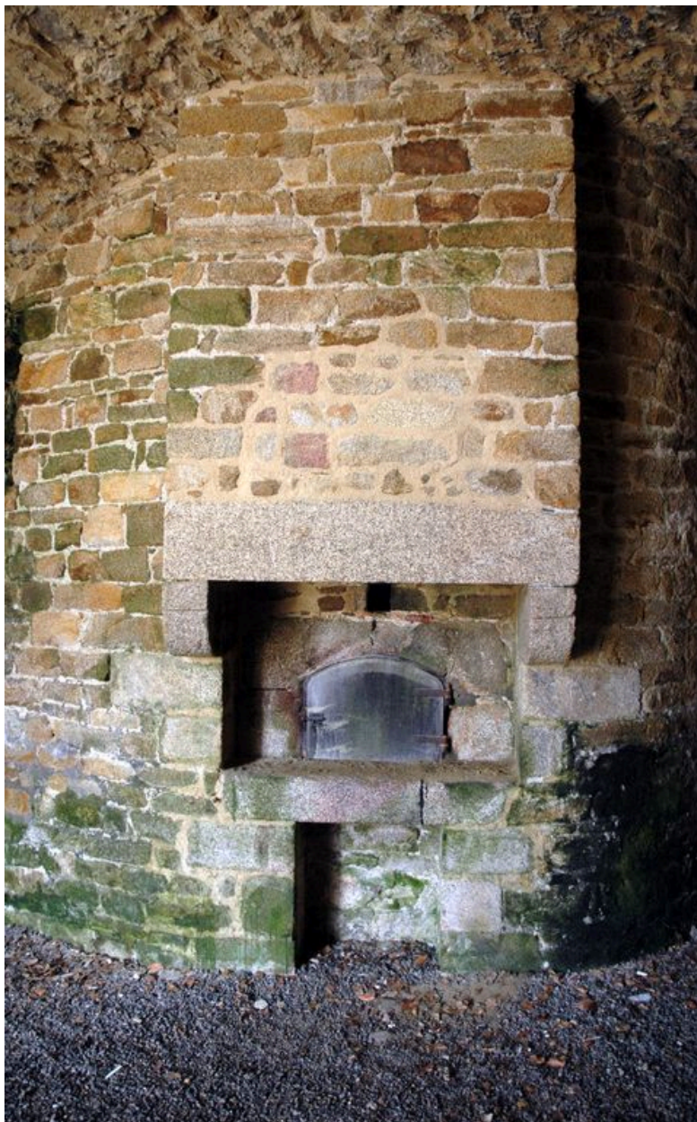
Vue de la citadelle de Port-Louis : four à pains aménagé dans une casemate du rempart
