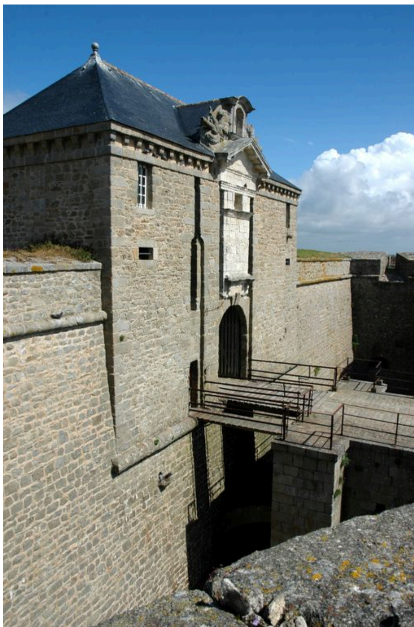
Vue de la citadelle de Port-Louis : pile du grand pont en granite permettant de franchir le canal, pont-levis et porte monumentale du corps de place
