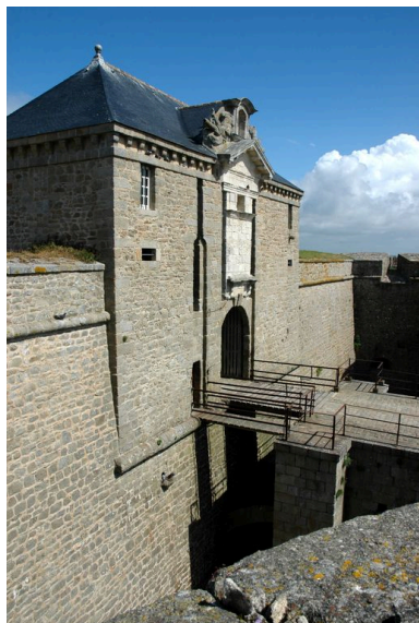
Vue de la citadelle de Port-Louis : pile du grand pont en granite permettant de franchir le canal, pont-levis et porte monumentale du corps de place Phot. Guillaume Lécueillier IVR53_20065605292NUCA
