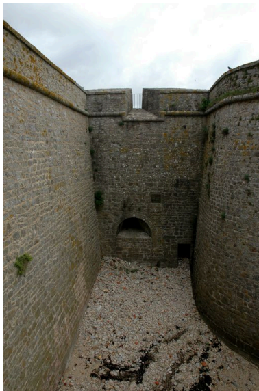
Vue de la citadelle de Port-Louis : embrasures nord protégées par l'orillon du bastion Dumourier et flanquant la porte du corps de place Phot. Guillaume Lécueillier IVR53_20065605225NUCA
