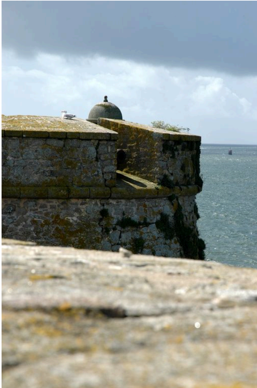
Vue de la citadelle de Port-Louis : embrasure plongeante et échauguette du bastion des Chambres
