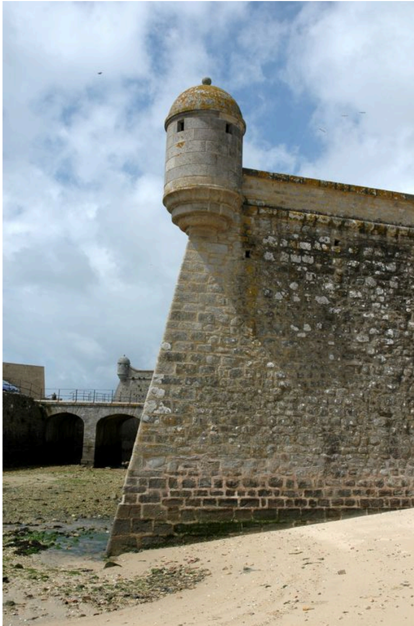
Vue de la citadelle de Port-Louis : échauguette de la demi-lune. En arrière-plan : le pont-dormant de la demi-lune et l'échauguette du bastion de Groix
