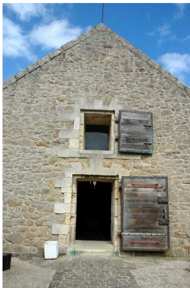
Vue de la citadelle de Port-Louis : entrée du magasin à poudre et sa baie d'aération Phot. Guillaume Lécueillier IVR53_20065605257NUCA
