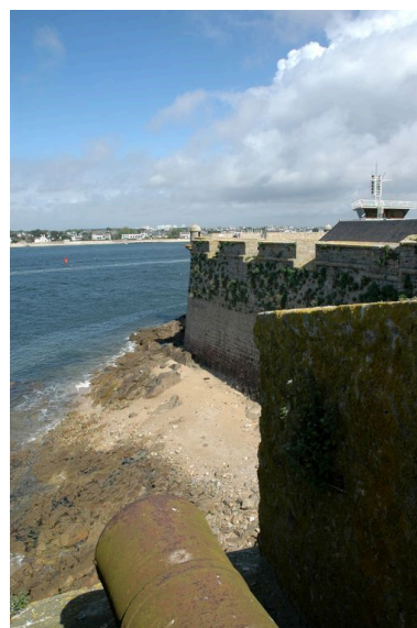
Vue de la citadelle de Port-Louis : embrasures plongeantes du bastion dit l'Irrégulier depuis le bastion des Chambres Phot. Guillaume Lécueillier IVR53_20065605277NUCA
