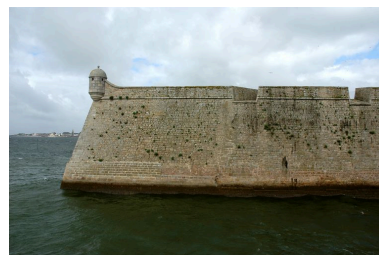
Vue de la citadelle de Port- Louis : embrasures plongeantes et échauguette du bastion de Groix Phot. Guillaume Lécueillier IVR53_20065605214NUCA
