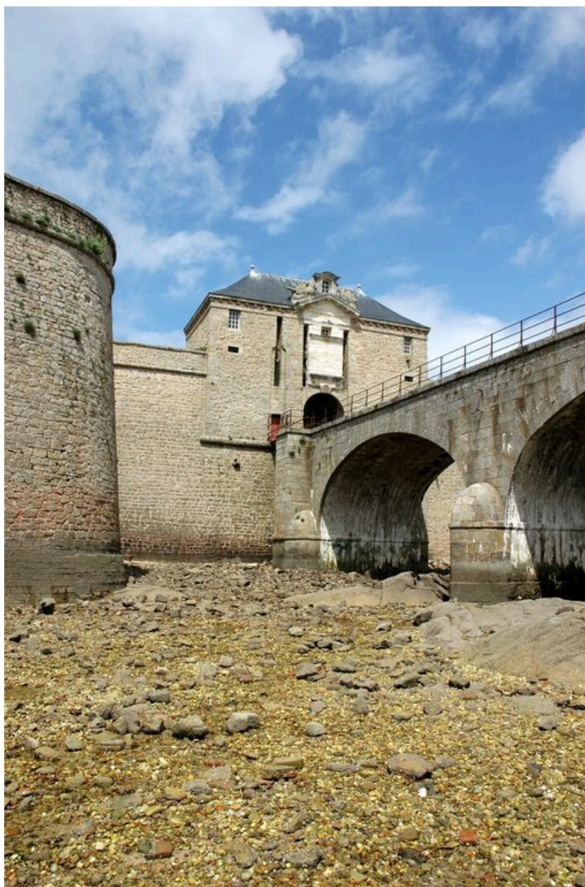
Vue de la citadelle de Port-Louis : piles du grand pont en granite permettant de franchir le canal, pont-levis et porte monumentale du corps de place
