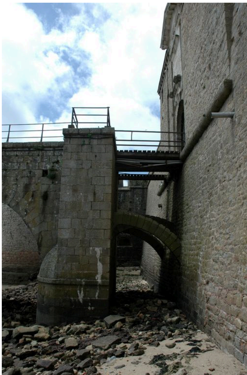
Vue de la citadelle de Port-Louis : pile du grand pont en granite permettant de franchir le canal, pont-levis et porte monumentale du corps de place. A signaler la présence de deux arcs boutants
