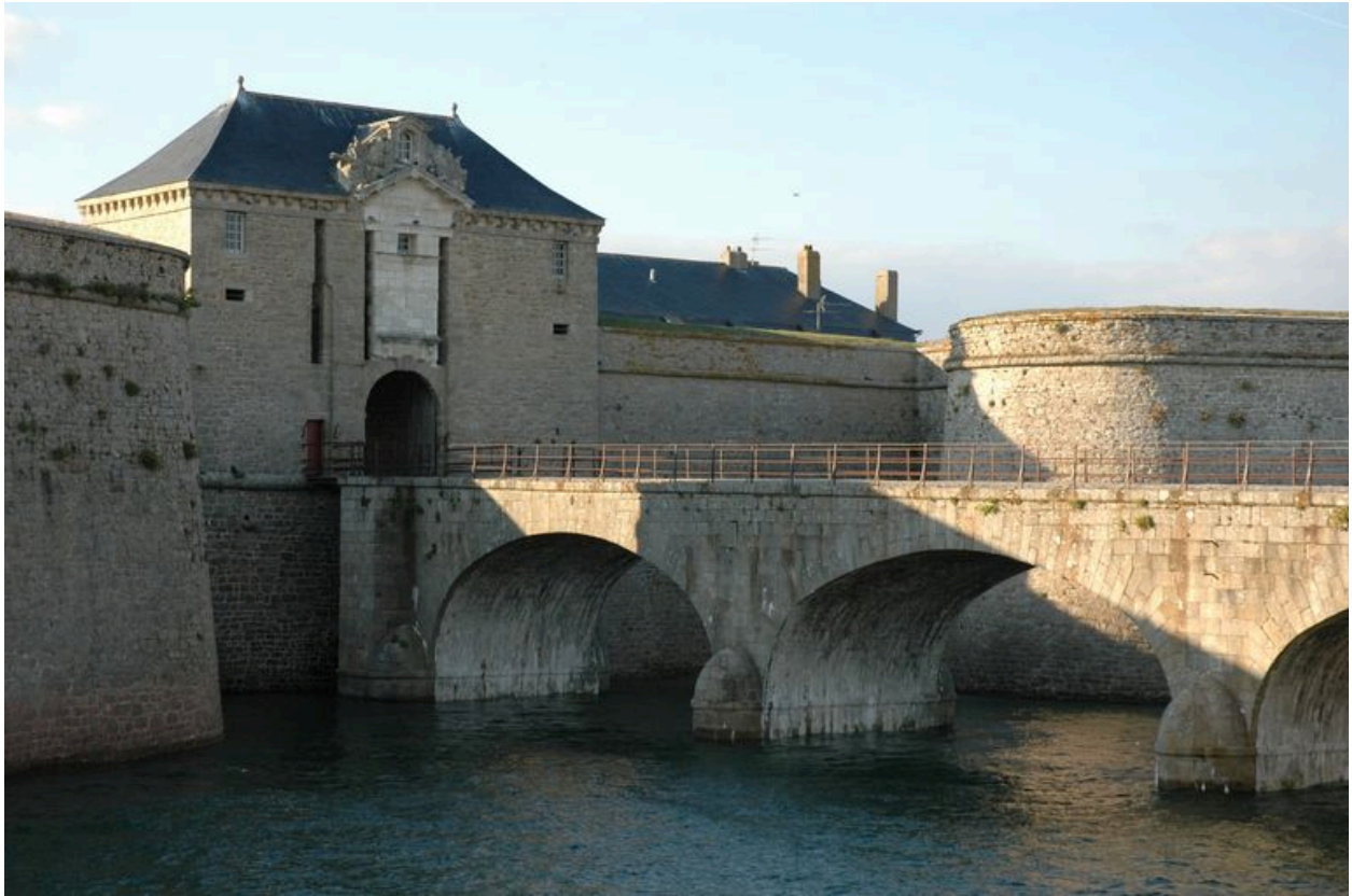
Vue de la citadelle de Port-Louis : porte monumentale du corps de place
