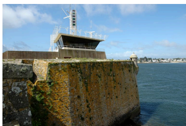
Vue de la citadelle de Port-Louis : sémaphore installé sur le grand bastion Phot. Guillaume Lécueillier IVR53_20065605262NUCA
