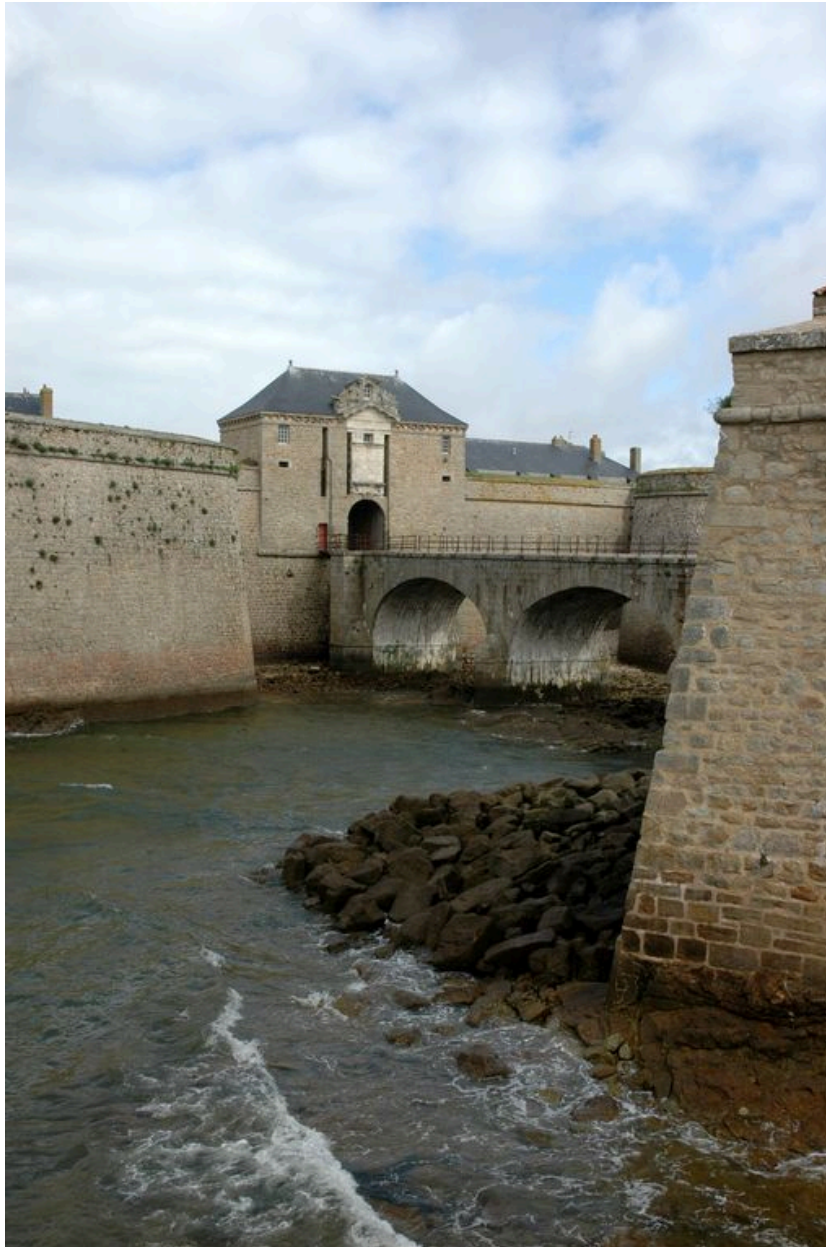
Vue de la citadelle de Port-Louis : porte monumentale du corps de place
