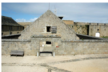
Vue de la citadelle de Port-Louis : magasin à poudre et son mur de sûreté Phot. Guillaume Lécueillier IVR53_20065605253NUCA
