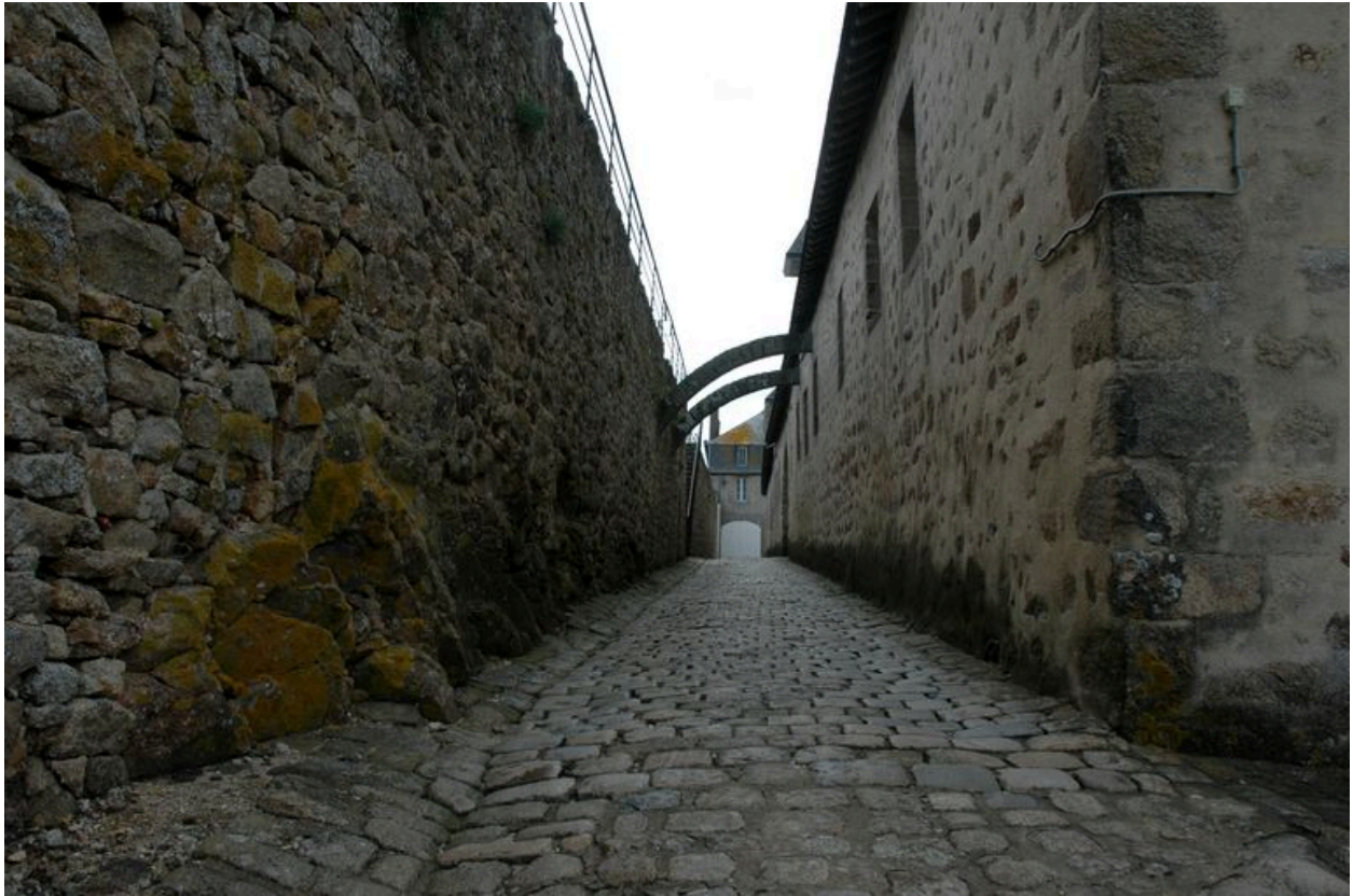
Vue de la citadelle de Port-Louis : passage situé entre le rempart et la caserne Lourmel. Arcs boutants servant de contrebutée de la charpente
