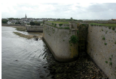
Vue de la citadelle de Port- Louis : embrasures rasantes de l'orillon nord du bastion Dumourier Phot. Guillaume Lécueillier IVR53_20065605236NUCA
