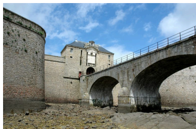
Vue de la citadelle de Port- Louis : piles du grand pont en granite permettant de franchir le canal, pont-levis et porte monumentale du corps de place Phot. Guillaume Lécueillier IVR53_20065605229NUCA
