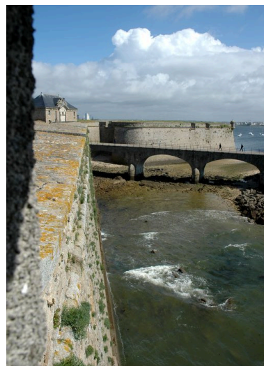
Vue de la citadelle de Port-Louis : grand pont en granite permettant de franchir le canal, pont-levis et porte monumentale du corps de place Phot. Guillaume Lécueillier IVR53_20065605290NUCA
