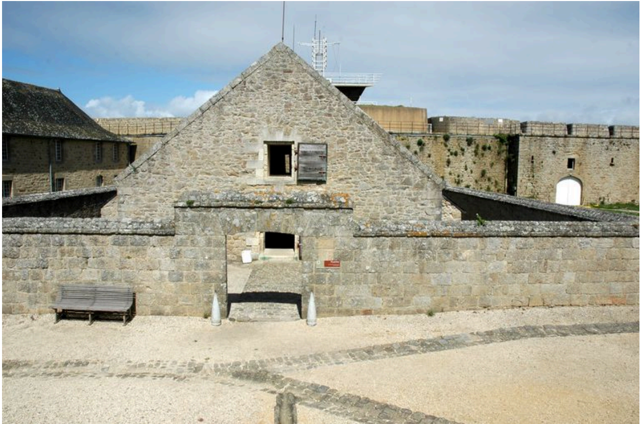
Vue de la citadelle de Port-Louis : magasin à poudre et son mur de sûreté
