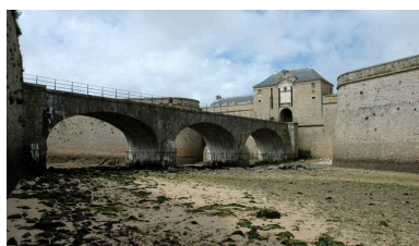
Vue de la citadelle de Port- Louis : grand pont en granite permettant de franchir le canal Phot. Guillaume Lécueillier IVR53_20065605219NUCA
