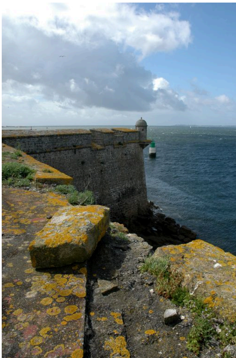
Vue de la citadelle de Port-Louis : embrasures plongeantes et échauguette du bastion dit l'Irrégulier
