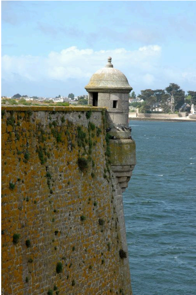
Vue de la citadelle de Port-Louis : échauguette du grand bastion
