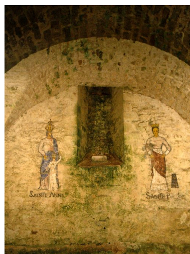
Vue de la citadelle de Port-Louis : peintures murales de la casemate du bastion de Groix Phot. Guillaume Lécueillier IVR53_20065605281NUCA
