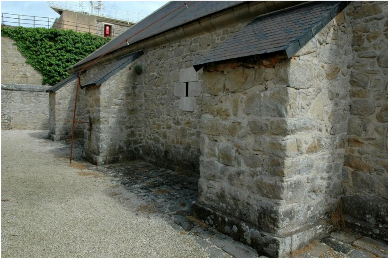
Vue de la citadelle de Port-Louis : contreforts du magasin à poudre
