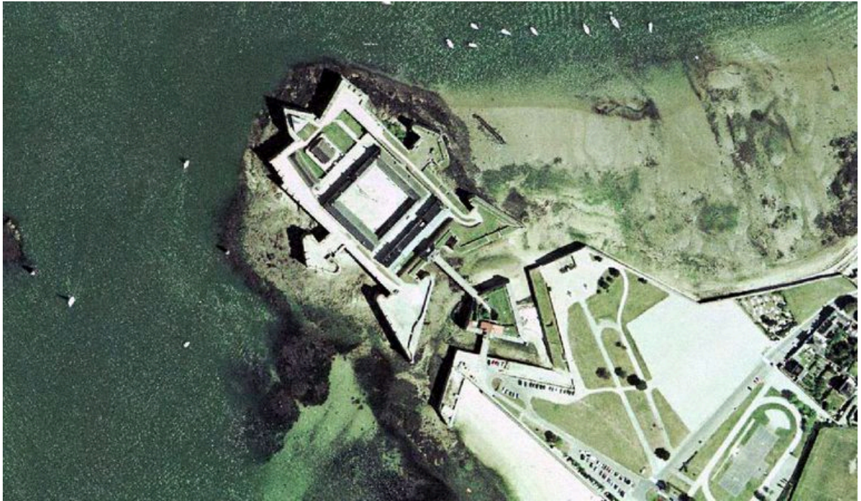
Vue aérienne verticale de la citadelle de Port-Louis (Orthophotographies littorales 2000)
