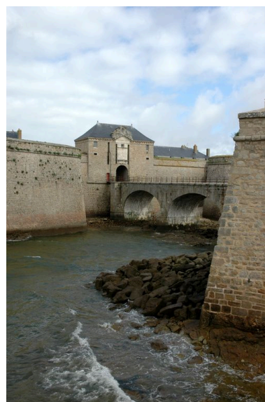
Vue de la citadelle de Port-Louis : porte monumentale du corps de place Phot. Guillaume Lécueillier IVR53_20065605215NUCA
