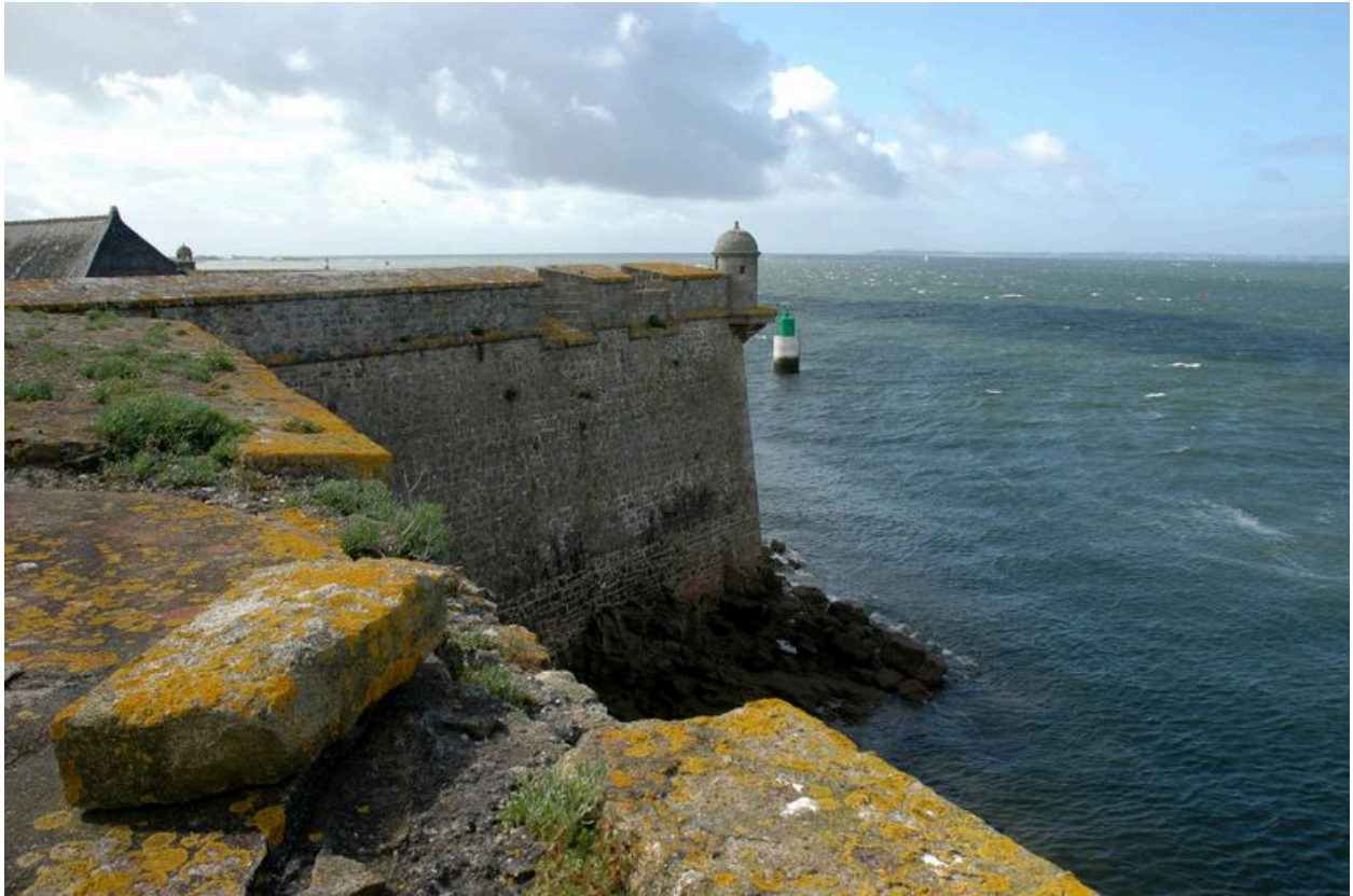
Vue de la citadelle de Port-Louis : embrasures plongeantes et échauguette du bastion dit l'Irrégulier
