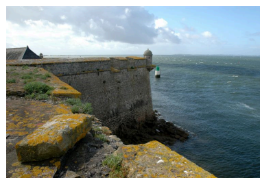
Vue de la citadelle de Port- Louis : embrasures plongeantes et échauguette du bastion dit l'Irrégulier Phot. Guillaume Lécueillier IVR53_20065605269NUCA
