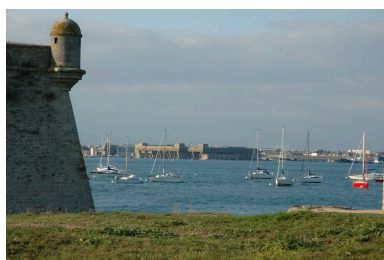
Vue de la citadelle de Port-Louis : échauguette couronnant la demi- lune. En arrière-plan : la base de sous-marins de Keroman Lorient Phot. Guillaume Lécueillier IVR53_20055603608NUCA
