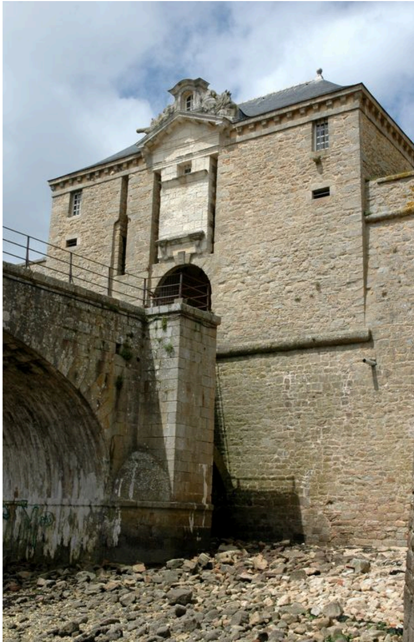
Vue de la citadelle de Port-Louis : pile du grand pont en granite permettant de franchir le canal, pont-levis et porte monumentale du corps de place
