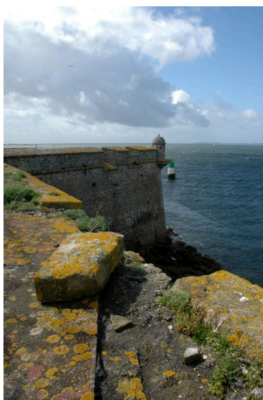
Vue de la citadelle de Port- Louis : embrasures plongeantes et échauguette du bastion dit l'Irrégulier Phot. Guillaume Lécueillier IVR53_20065605268NUCA
