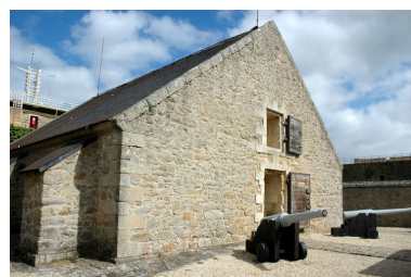
Vue de la citadelle de Port- Louis : magasin à poudre Phot. Guillaume Lécueillier IVR53_20065605254NUCA
