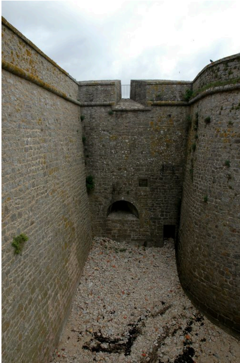
Vue de la citadelle de Port-Louis : embrasures nord protégées par l'orillon du bastion Dumourier et flanquant la porte du corps de place
