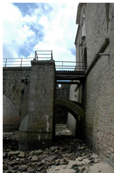
Vue de la citadelle de Port-Louis : pile du grand pont en granite permettant de franchir le canal, pont-levis et porte monumentale
