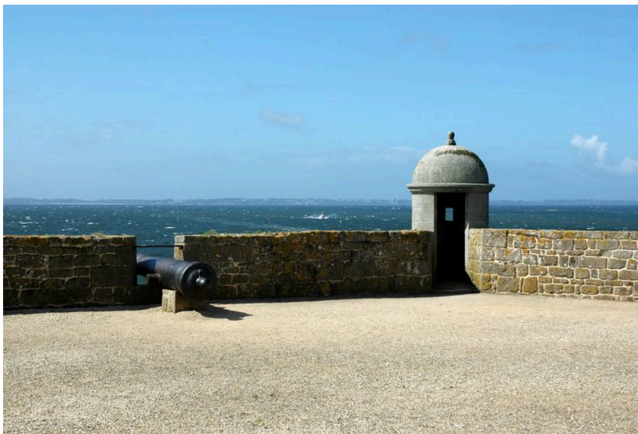
Vue de la citadelle de Port-Louis : embrasure plongeante et échauguette du bastion des Chambres
