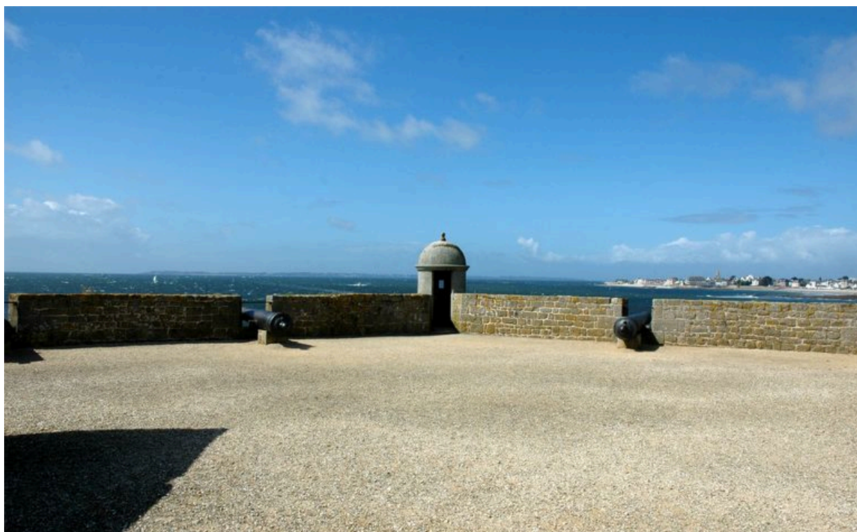
Vue de la citadelle de Port-Louis : embrasures plongeantes et échauguette du bastion des Chambres
