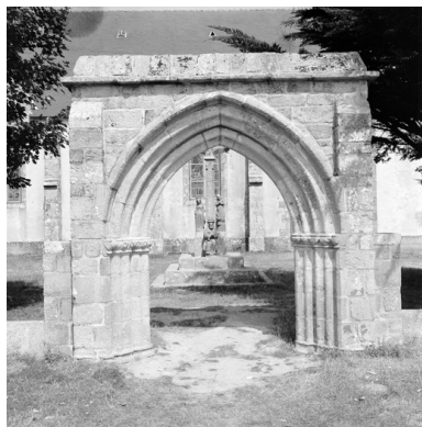
Plonévez-Porzay, chapelle Sainte-Anne-La-Palud : portail sud de l'enclos, état en 1969 Phot. Samson, Phot. Chevalier IVR53_19692900587X
