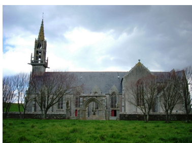
Plonévez-Porzay, chapelle Sainte- Anne-La-Palud : élévation sud Phot. Gwénaél Fauchille IVR53_20082905667NUCA
