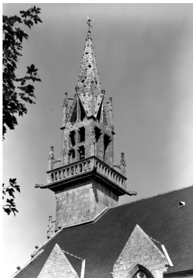
Plonévez-Porzay, chapelle Sainte- Anne-La-Palud : clocher, état en 1970 Phot. Guy Artur IVR53_19702901011V
