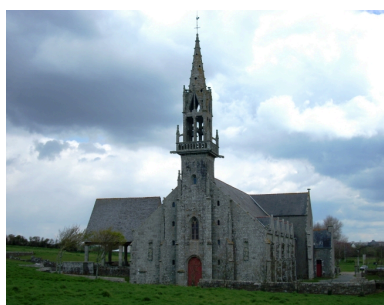
Plonévez-Porzay, chapelle Sainte-Anne-La-Palud : vue générale sud-ouest Phot. Gwénaél Fauchille IVR53_20082905666NUCA
