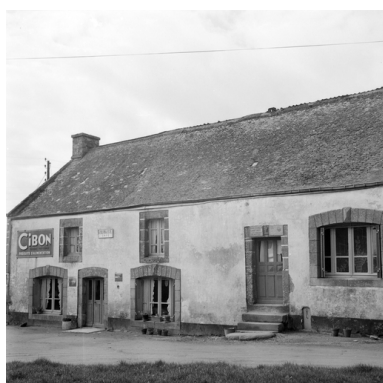
Quelven - Maison, parcelle 363 au sud-ouest de l'église, vue d'ensemble de la façade est. Phot. Brachet IVR53_19665601334X
