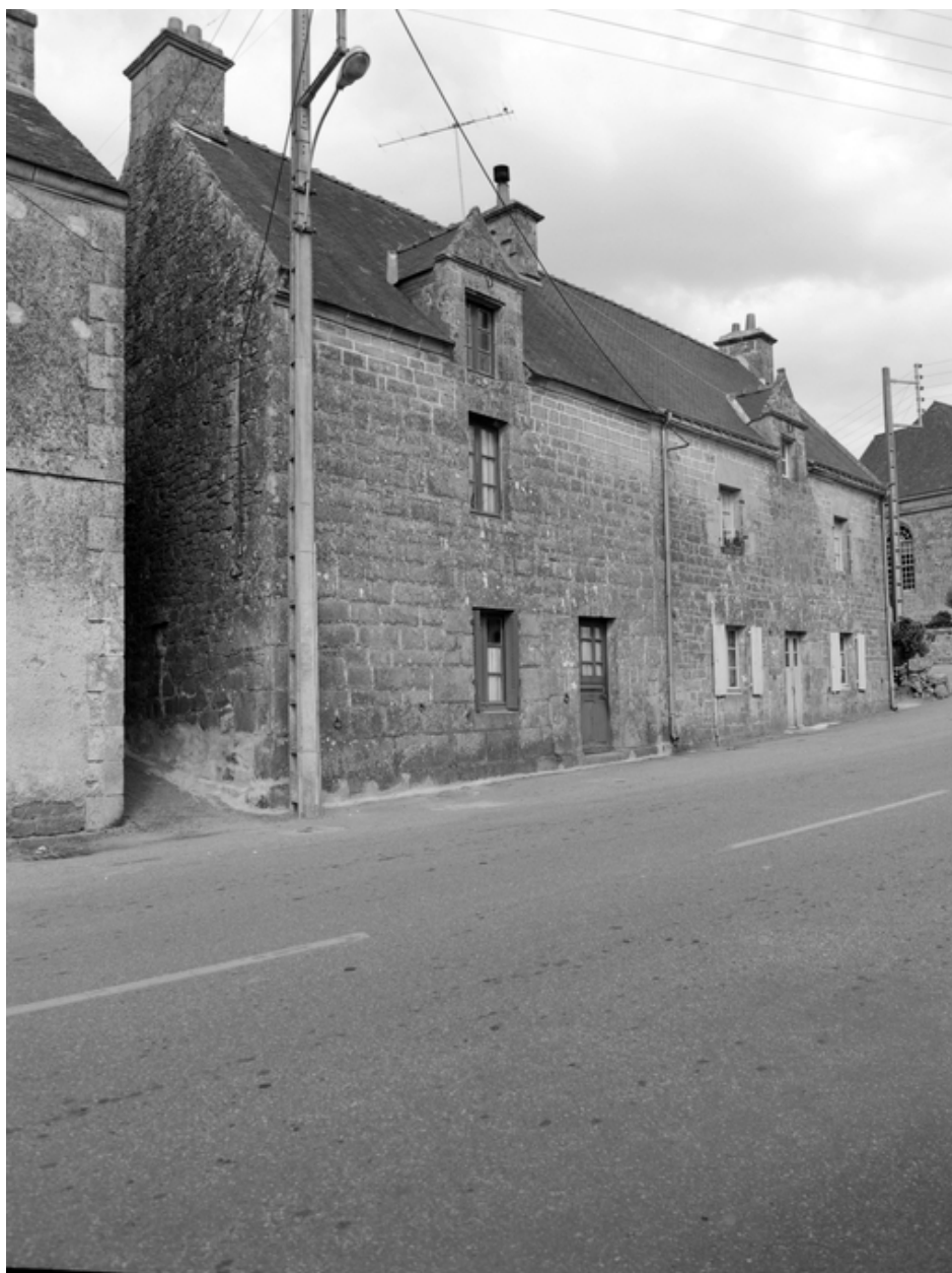
Bourg - Maison, vue générale des façades ouest.
