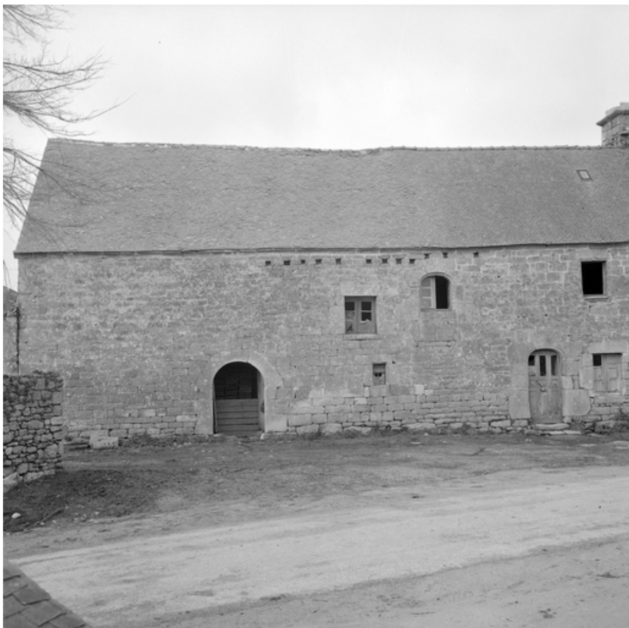
Quelven - Maison au sud-est de l'église, vue d'ensemble de la façade est.
