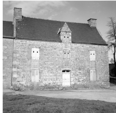
Quelven - Maison à l'ouest de l'église, vue d'ensemble de la façade sud. Phot. Brachet IVR53_19665601325V
