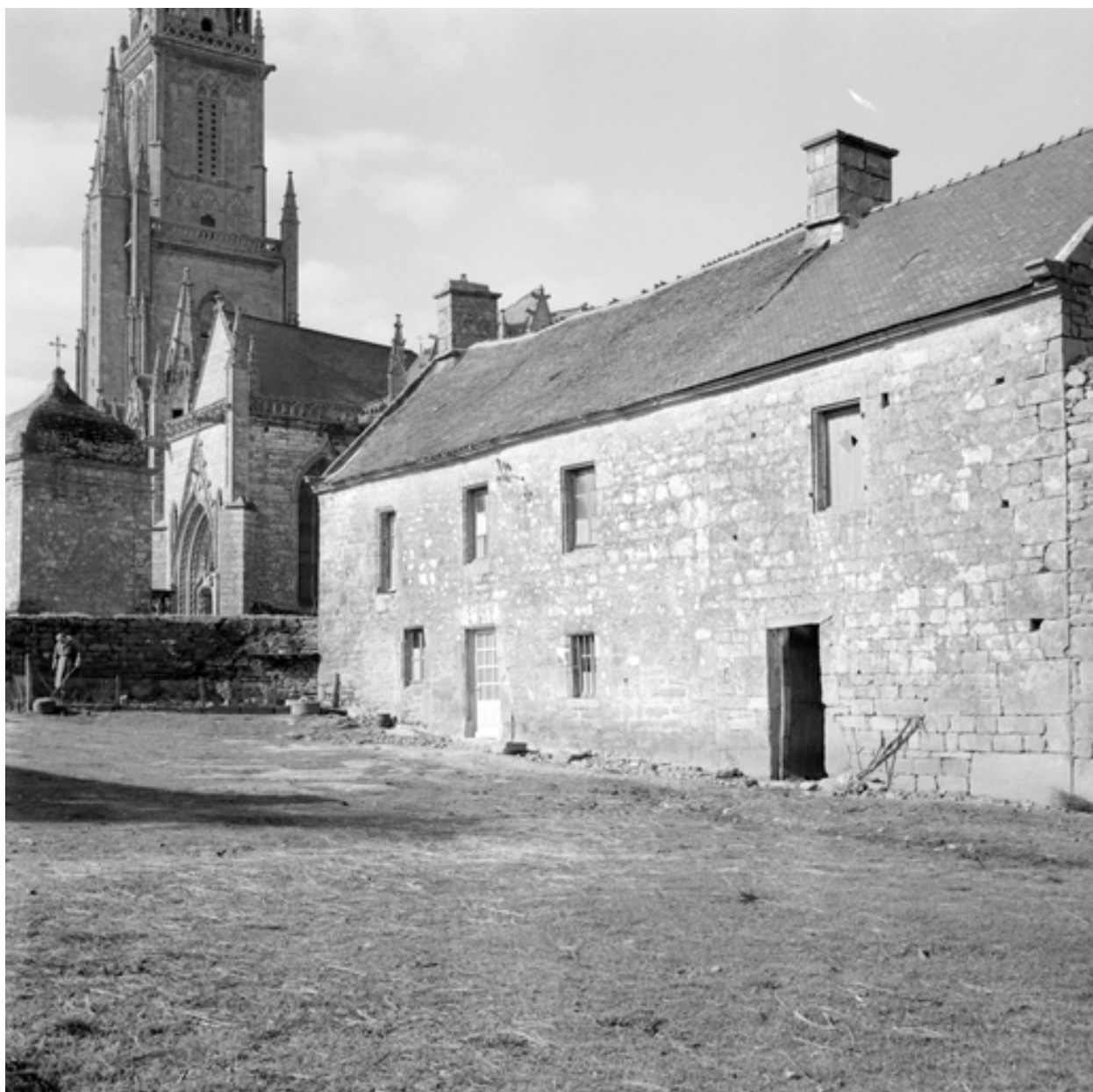
Quelven - Maison au sud-est de l'église, vue d'ensemble de la façade sud.
