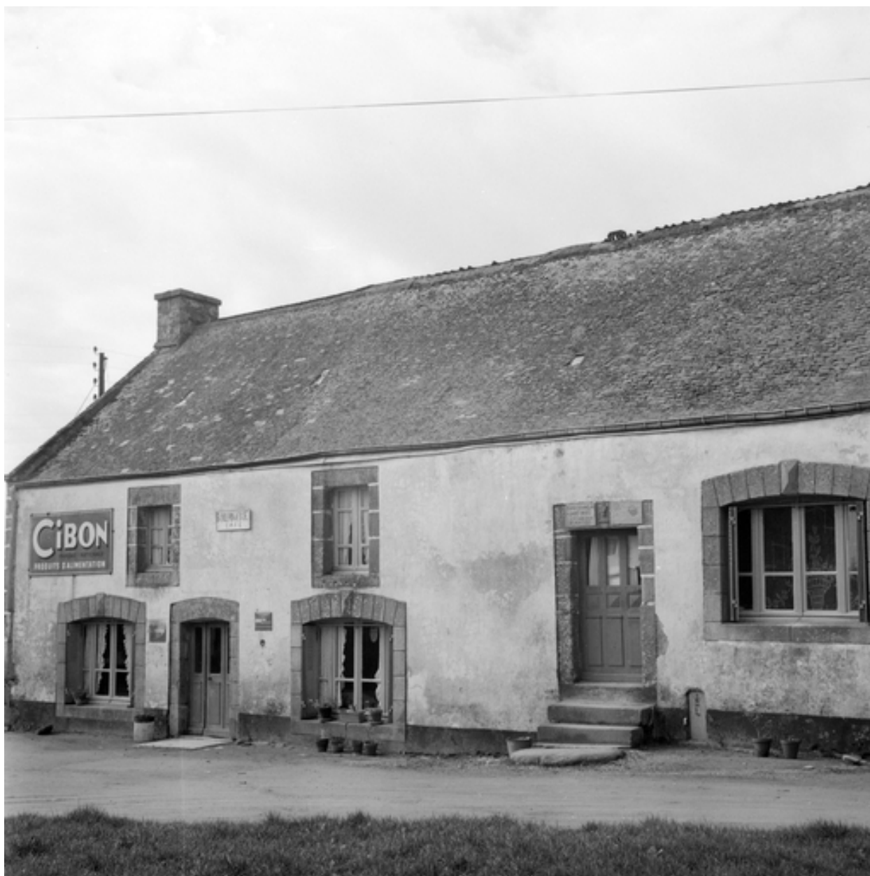
Quelven - Maison, parcelle 363 au sud-ouest de l'église, vue d'ensemble de la façade est.
