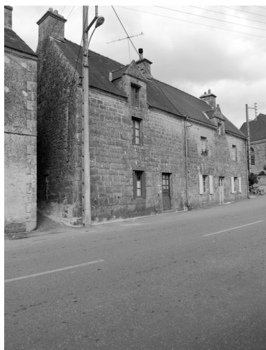
Bourg - Maison, vue générale des façades ouest. Phot. Auteur inconnu IVR53_19745600113X
