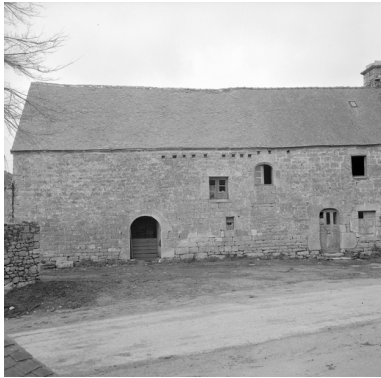
Quelven - Maison au sud-est de l'église, vue d'ensemble de la façade est. Phot. Brachet IVR53_19665601333X
