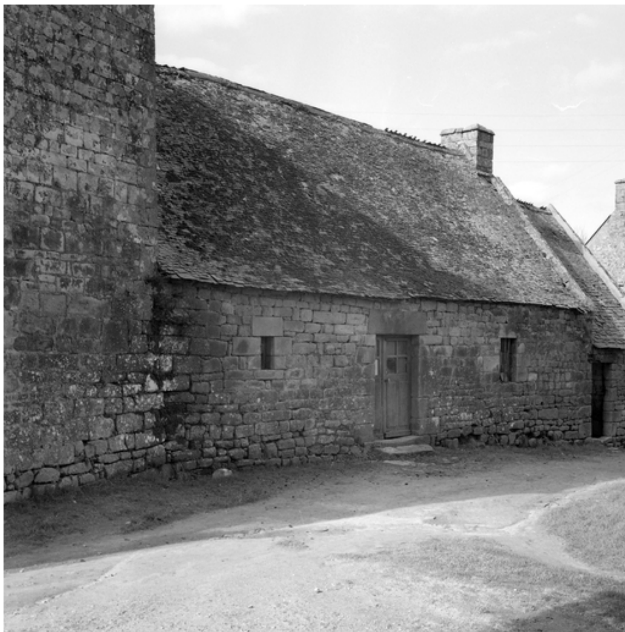
Quelven - Maison, parcelle 340, au nord-ouest de l'église, vue d'ensemble de la façade est.
