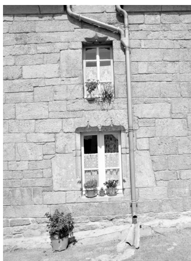
Kerauray - Ouvertures, détail. Phot. François Dagorn IVR53_19745600189X
