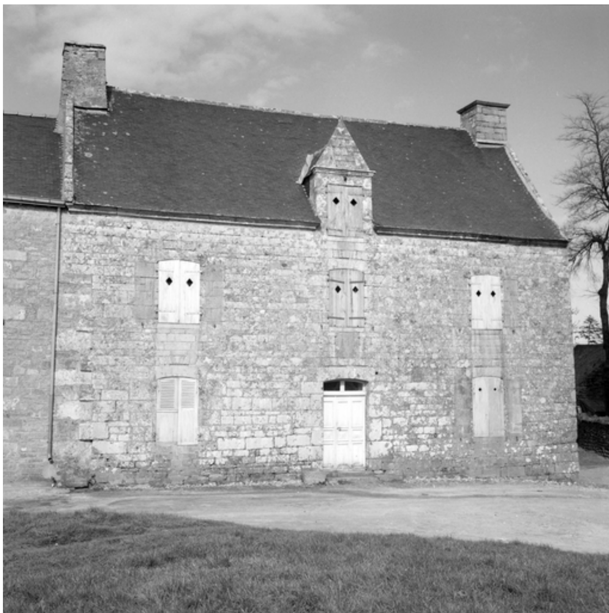
Quelven - Maison à l'ouest de l'église, vue d'ensemble de la façade sud.
