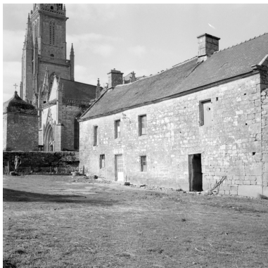
Quelven - Maison au sud-est de l'église, vue d'ensemble de la façade sud. Phot. Brachet IVR53_19665601331X
