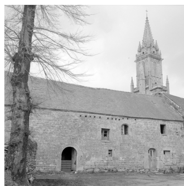
Quelven - Maison au sud-est de l'église, vue d'ensemble de la façade est. Phot. Brachet IVR53_19665601332X
