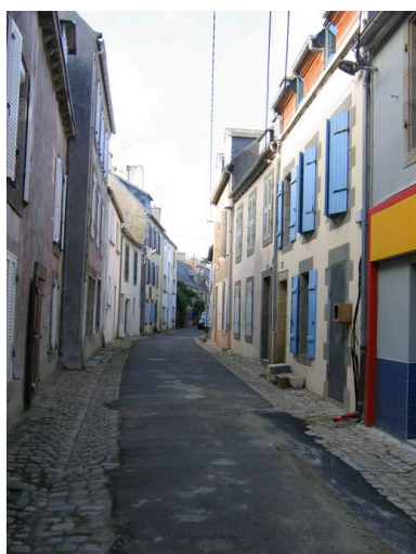
Vue générale de la rue de Dixmude Phot. Guillaume Marie IVR53_20062908296NUCA
