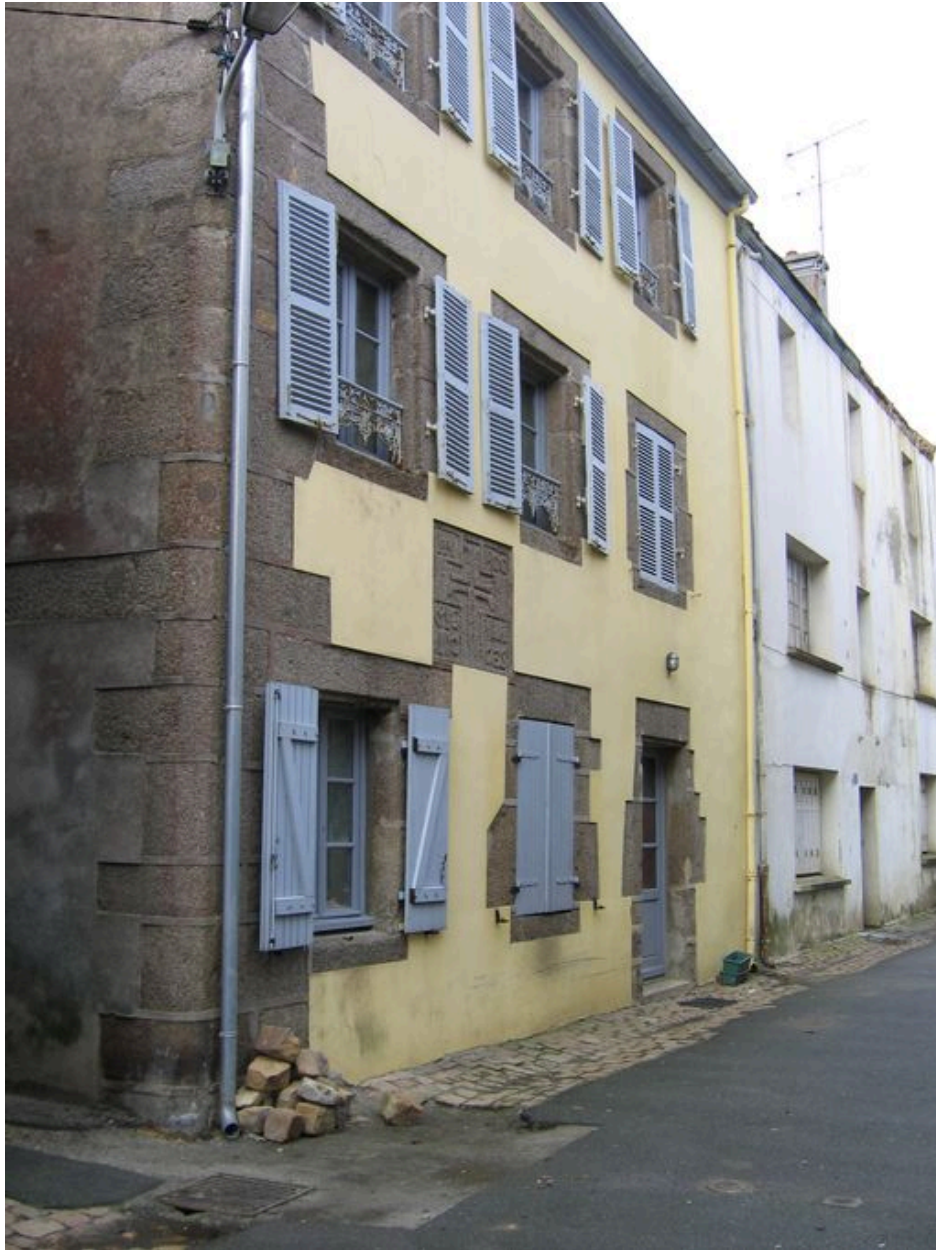
Maison Torrec de Basse-Maison au n° 3 de la rue
