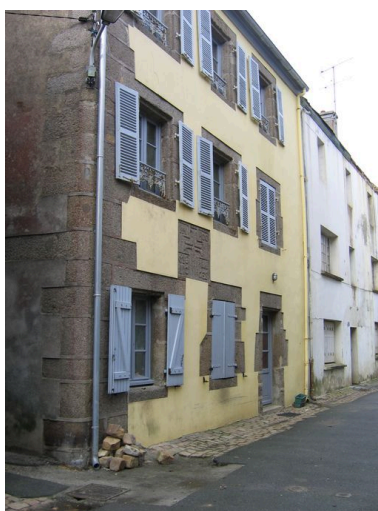
Maison Torrec de Basse- Maison au n° 3 de la rue Phot. Françoise Péron IVR53_20062908316NUCA
