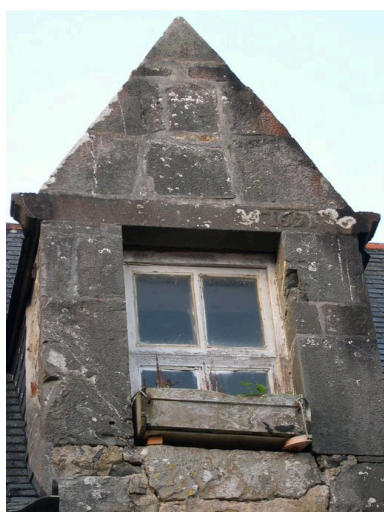
Lucarne jacobine du n° 7 rue de Dixmude Phot. Guillaume Marie IVR53_20062908465NUCA
