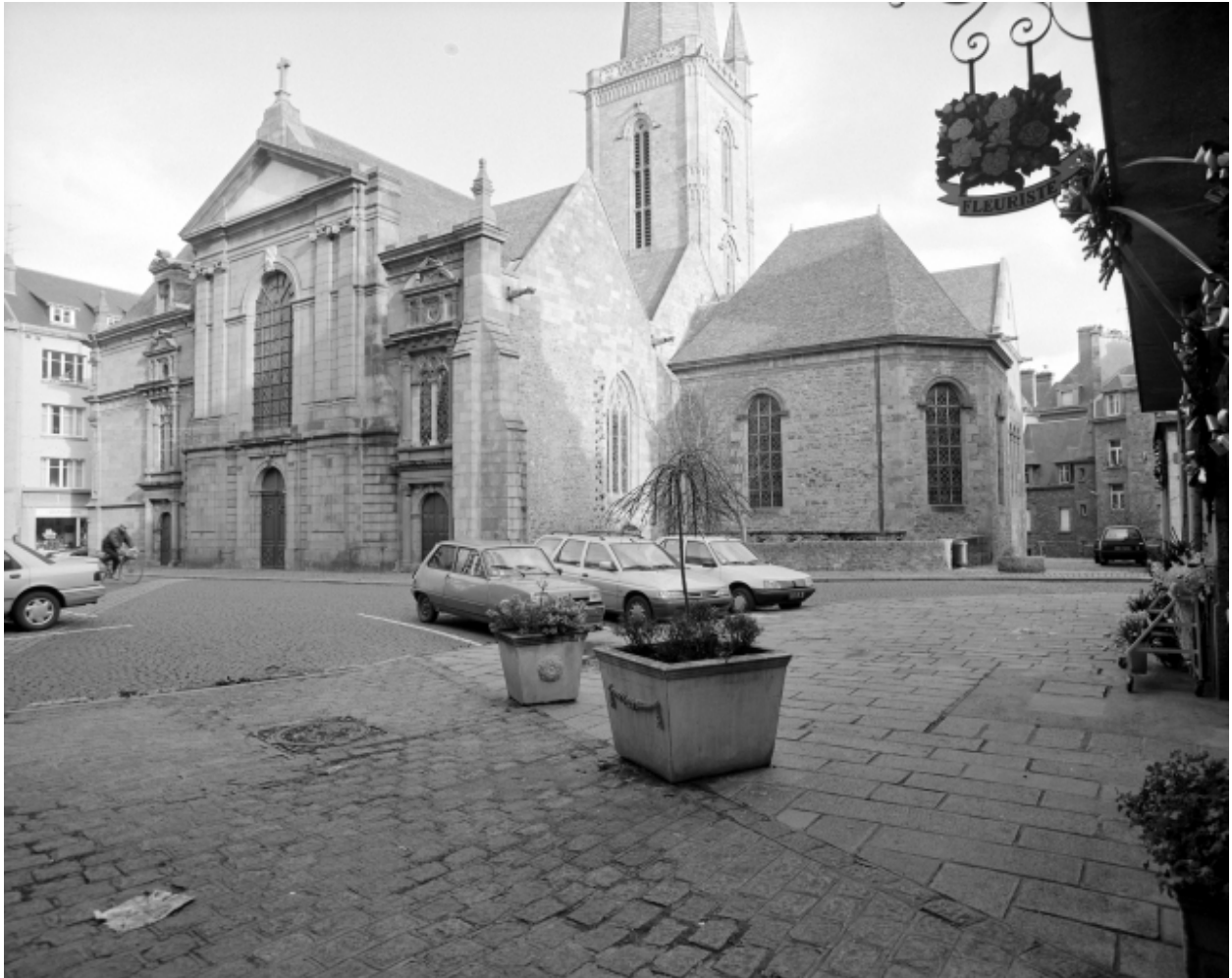
Elévation Sud-Ouest : vue générale
