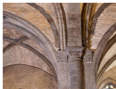
Décor des chapiteaux de la nef Phot. Bernard Bègne IVR53_20223500767NUCA
