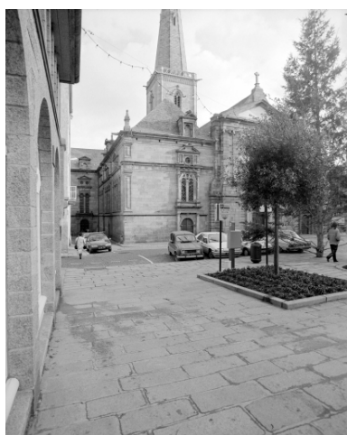
Elévation Nord-Ouest : vue générale Phot. A. Boden IVR53_19943500170X
