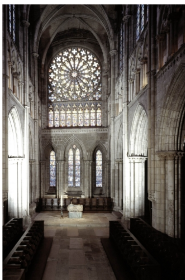
Vue intérieure vers le chœur Phot. Auteur inconnu IVR53_19963500049VA
