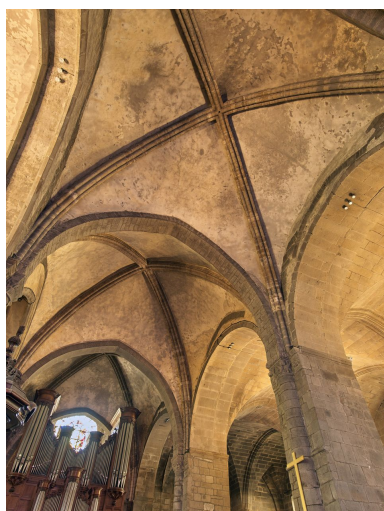
Les voutes de la nef Phot. Bernard Bègne IVR53_20223500763NUCA
