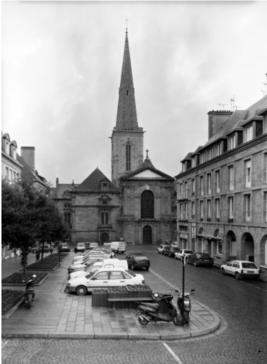
Elévation Ouest : vue générale
