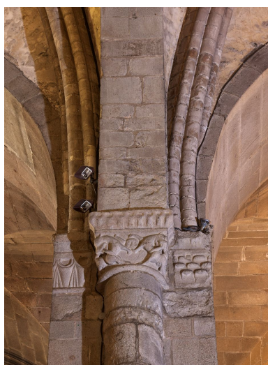
Décor des chapiteaux de la nef Phot. Bernard Bègne IVR53_20223500766NUCA
