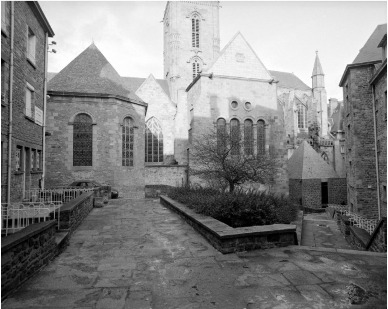
Elévation Sud : vue générale
