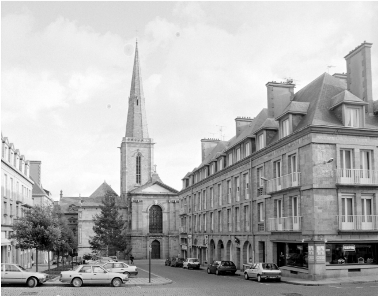
Elévation Ouest : vue générale
