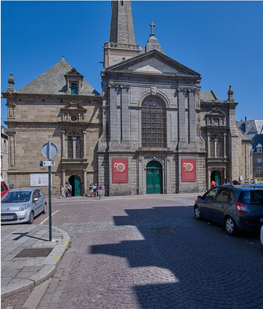
Elévation ouest, vue générale
