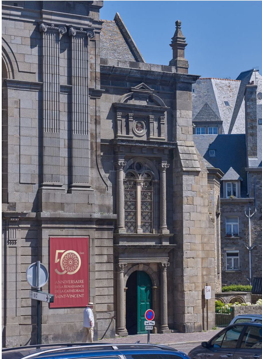
Portail d'entrée sud-ouest
