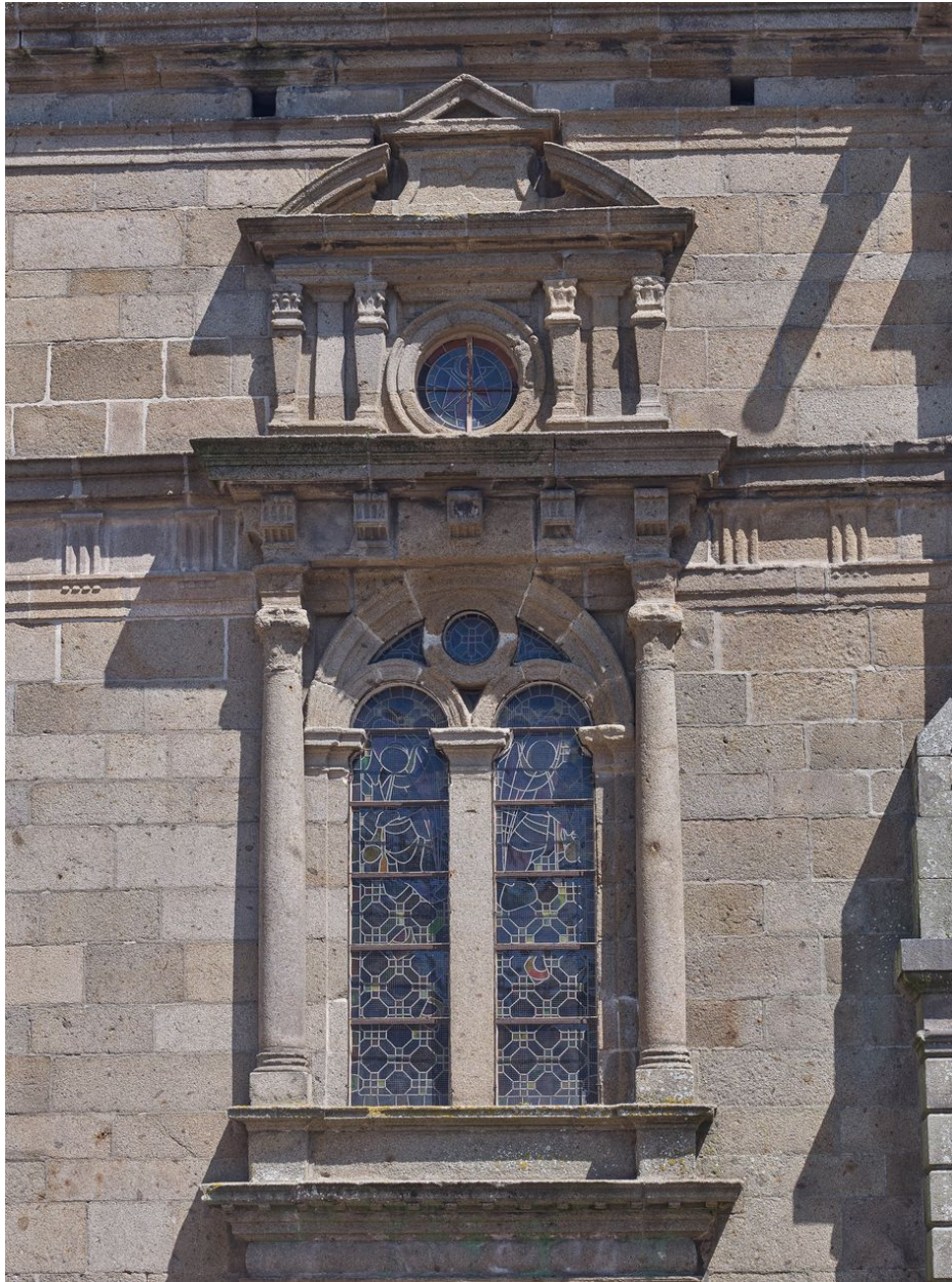
Façade occidentale, baie et détail du décor
