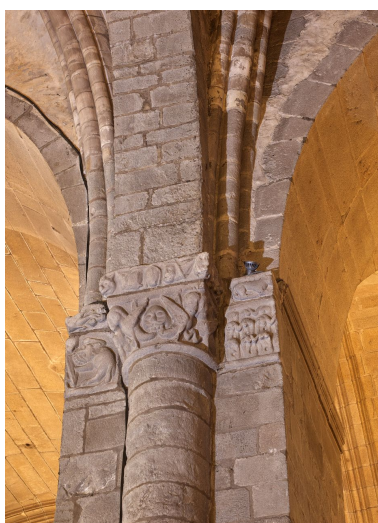
Décor des chapiteaux de la nef Phot. Bernard Bègne IVR53_20223500765NUCA
