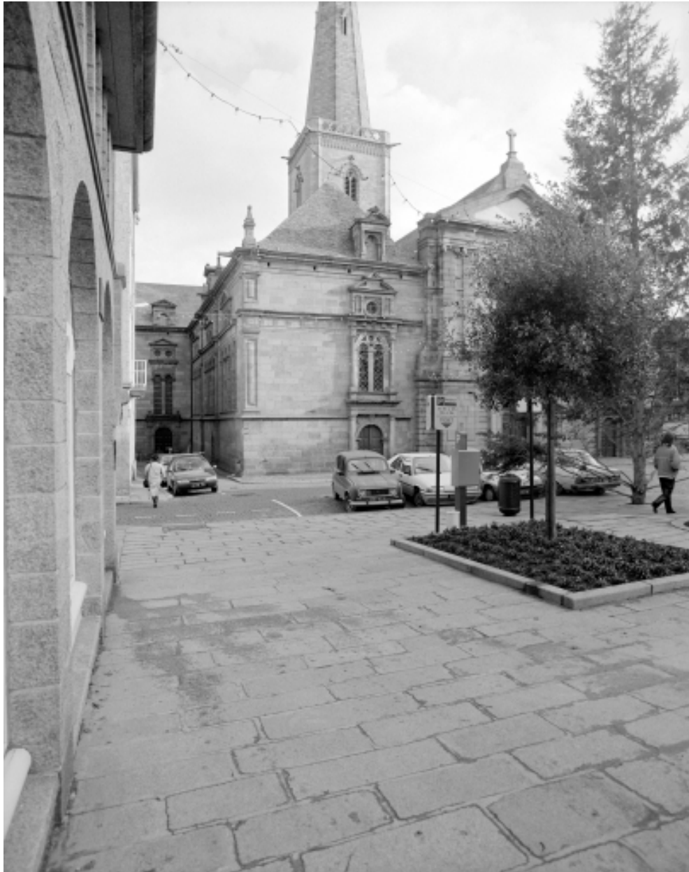
Elévation Nord-Ouest : vue générale
