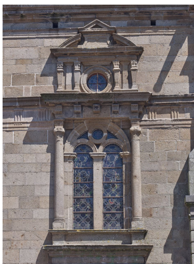
Façade occidentale, baie et détail du décor Phot. Bernard Bègne IVR53_20223500781NUCA
