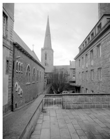
Elévation Sud, clocher : vue générale Phot. A. Boden IVR53_19943500173X
