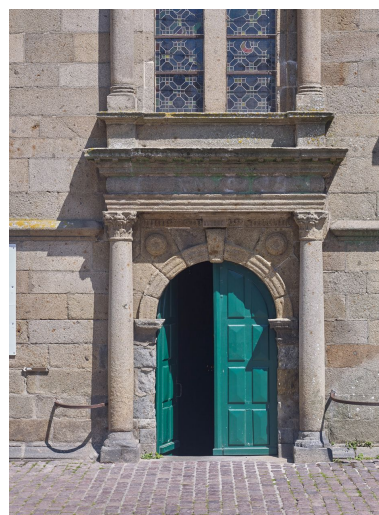
Façade occidentale, portail Phot. Bernard Bègne IVR53_20223500780NUCA
