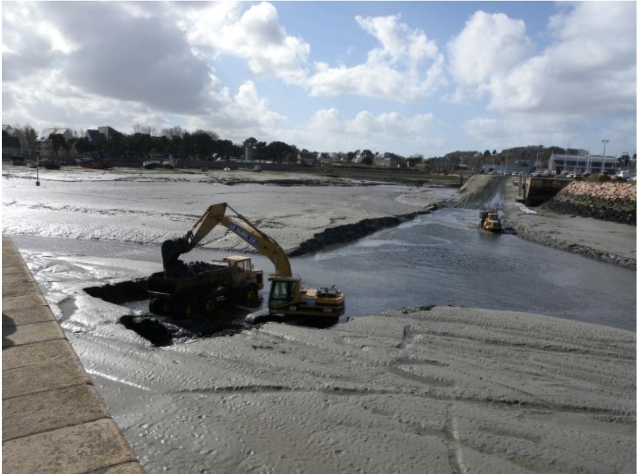
Vue de l'avant-port entre la cale de Kerpallud et la jetée de Kernoa (opération de désenvasage)
