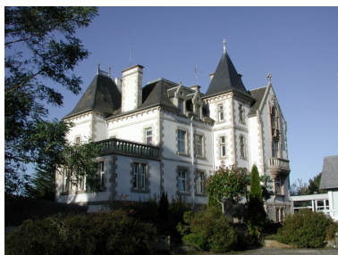
Vue générale (façade postérieure) Phot. Patrick Pichouron IVR53_20042206024NUCA
