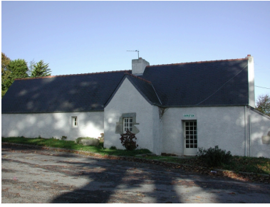
Logement et dépendance Phot. Patrick Pichouron IVR53_20042206025NUCA
