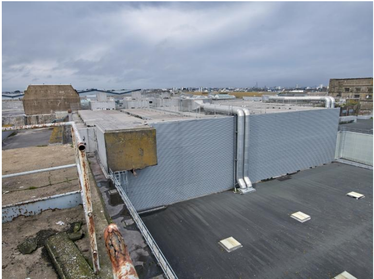
Vue de la dalle de couverture du bunker Keroman I : au centre, accès des trémies à charbon (masqué par le bardage) avec son monorail pour le chargement depuis le parc à charbon
