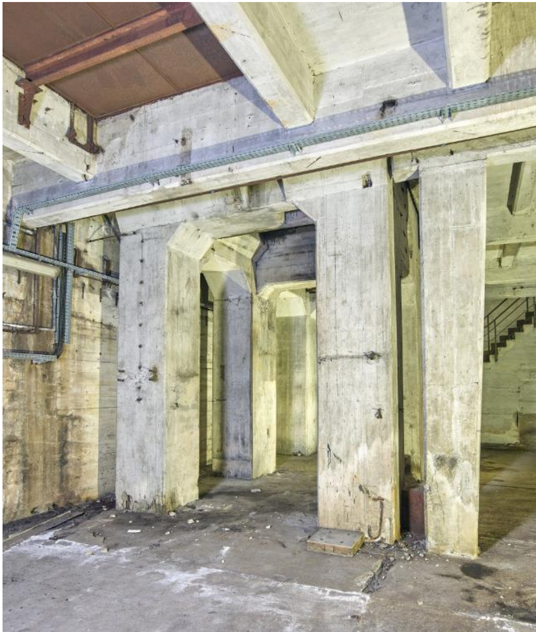
Vue de la salle du condenseur (fonction en 1945) puis atelier (fonction en 1966) dans l'extension sud : piliers en béton armé supportant le plafond sur lequel est implanté un groupe turbo-dynamo (mentionné en 1945). En arrière-plan : l'escalier d'accès au premier étage
