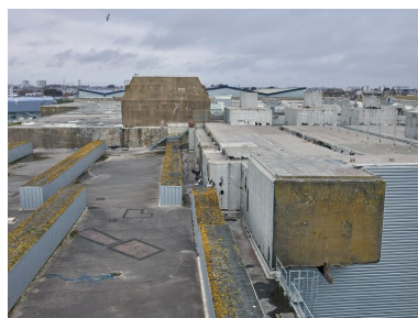
Vue de la dalle de couverture du bunker Keroman I : à droite au premier plan, accès des trémies à charbon (masqué par le bardage) avec son monorail pour le chargement depuis le parc à charbon
