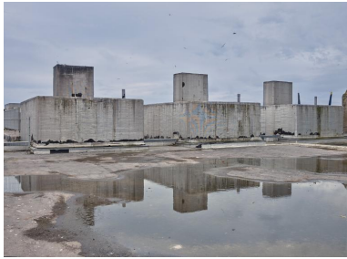
Vue générale des trois cheminées de la chaufferie depuis la dalle de couverture du bunker KI Phot. Bernard Bègne IVR53_20235600227NUCA
