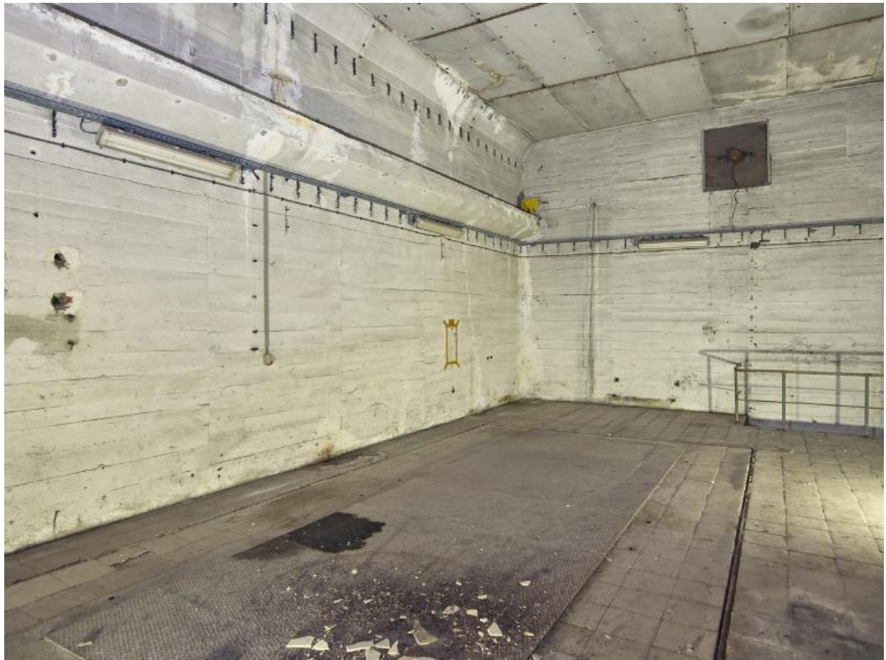
Vue de l'emplacement du groupe turbo-dynamo (fonction en 1945) désignée comme ex local des bouilleurs (1965) au premier étage dans l'extension sud : extrémité est avec débouché de l'escalier
