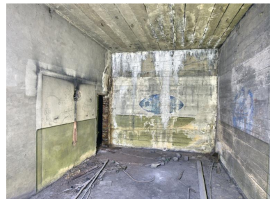
Vue du deuxième étage de l'extension sud : salle de pause ornée de trois peintures murales d'origine allemande. A gauche, mur de refend en brique
