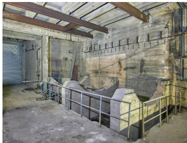
Vue de la salle du condenseur (fonction en 1945) puis atelier (fonction en 1966) dans l'extension sud : berceau en béton armé pour deux cuves (pour l'eau déminéralisée ?). Au fond de la pièce, le rideau métallique donne dans la rue située entre le bunker pour machines et le bunker KI Phot. Bernard Bègne IVR53_20235600167NUCA
