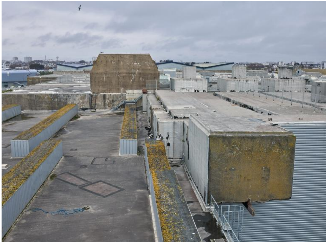
Vue de la dalle de couverture du bunker Keroman I : à droite au premier plan, accès des trémies à charbon (masqué par le bardage) avec son monorail pour le chargement depuis le parc à charbon
