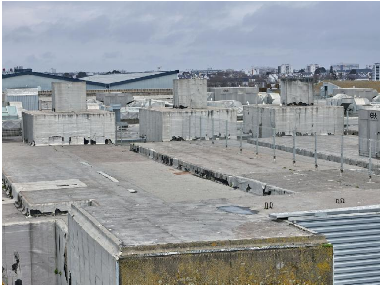
Vue de situation des trois cheminées de la chaufferie depuis la dalle de couverture du bunker KI. Au premier plan, dalle supérieure de l'accès des trémies à charbon
