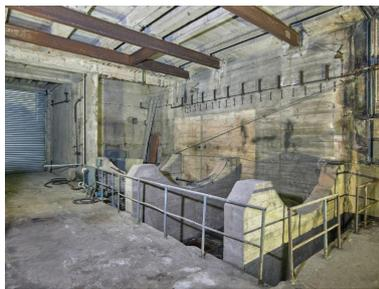
Vue de la salle du condenseur (fonction en 1945) puis atelier (fonction en 1966) dans l'extension sud : berceau en béton armé pour deux cuves (pour l'eau déminéralisée ?). Au fond de la pièce, le rideau métallique donne dans la rue située entre le bunker pour machines et le bunker KI
