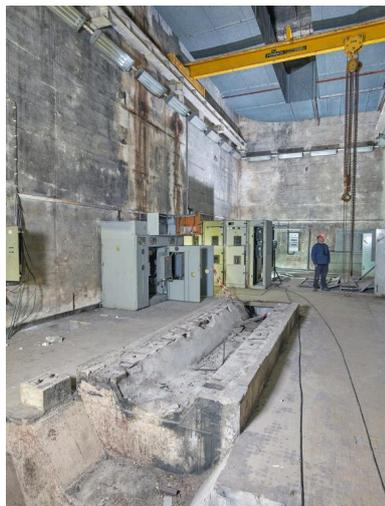
Vue générale de la chaufferie est (fonction en 1945) située au rez-de-chaussée. Le pont roulant - de la période française - d'une capacité de 10 tonnes est de marque FENWICK (PB2-78). Au premier plan, l'emplacement du moteur Duvant. Sur les murs, des lampes fluorescentes
