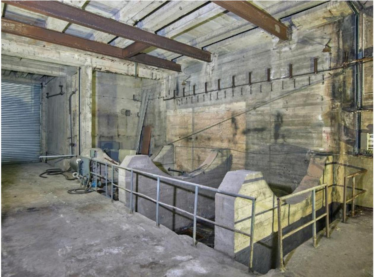
Vue de la salle du condenseur (fonction en 1945) puis atelier (fonction en 1966) dans l'extension sud : berceau en béton armé pour deux cuves (pour l'eau déminéralisée ?). Au fond de la pièce, le rideau métallique donne dans la rue située entre le bunker pour machines et le bunker KI
