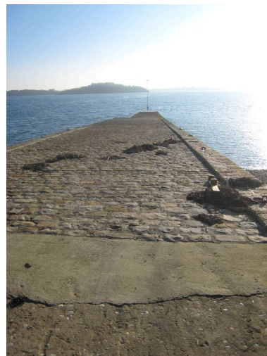
Cale de Quélern Phot. Françoise Péron IVR53_20072908973NUCA
