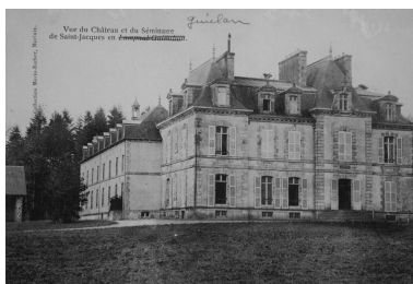
Vue générale Phot. Elise Lauranceau IVR53_20052904372NUCB
