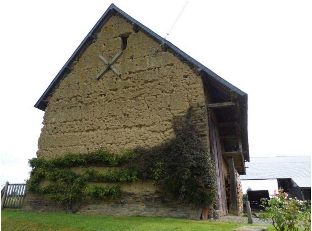
Vue du pignon ouest de la grange, maçonnerie mixte en schiste et terre, détail de l'auvent sur la façade principale
