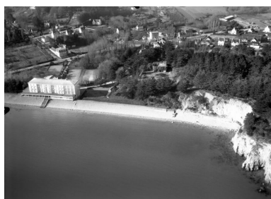
Vue aérienne du corps de garde crénelé n° 3 de Rulianec en 1971 Phot. Guy Artur, Phot. Norbert Lambart IVR53_19712902381NUCA
