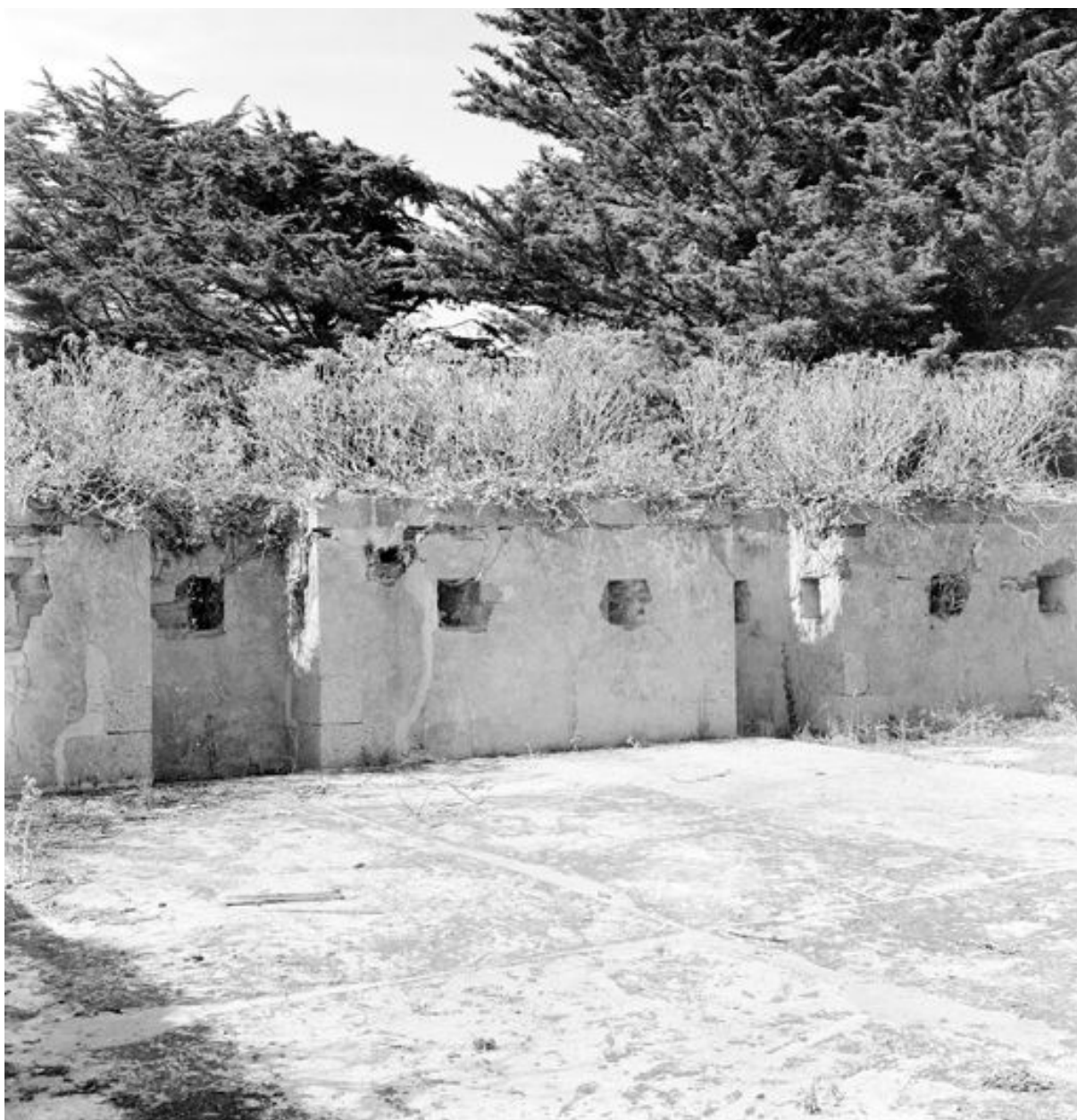
Vue du parapet du corps de garde crénelé n° 3 de Rulianec en 1969
