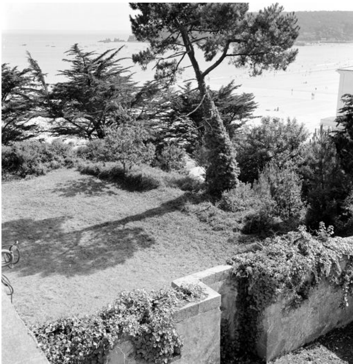
Vue du parapet du corps de garde crénelé n° 3 de Rulianec depuis le sommet de la citerne en 1969
