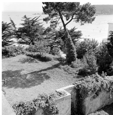
Vue du parapet du corps de garde crénelé n° 3 de Rulianec depuis le sommet de la citerne en 1969 Phot. Guy Artur IVR53_19692900267X
