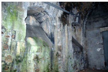
Vue de l'entrée du tunnel d'Heurtebise traversant le front bastionné de l'Harteloire dit Nouvelle enceinte (construite en 1848) : intérieur du sas, deux créneaux de fusillade disposés à gauche en entrant Phot. Guillaume Lécueillier IVR53_20082909594NUCA
