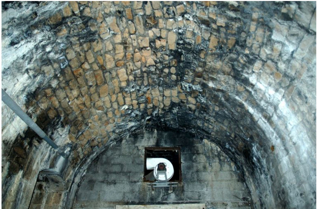
Vue de l'entrée du tunnel d'Heurtebise traversant le front bastionné de l'Harteloire dit Nouvelle enceinte (construite en 1848) : intérieur du sas, voûte en moellons
