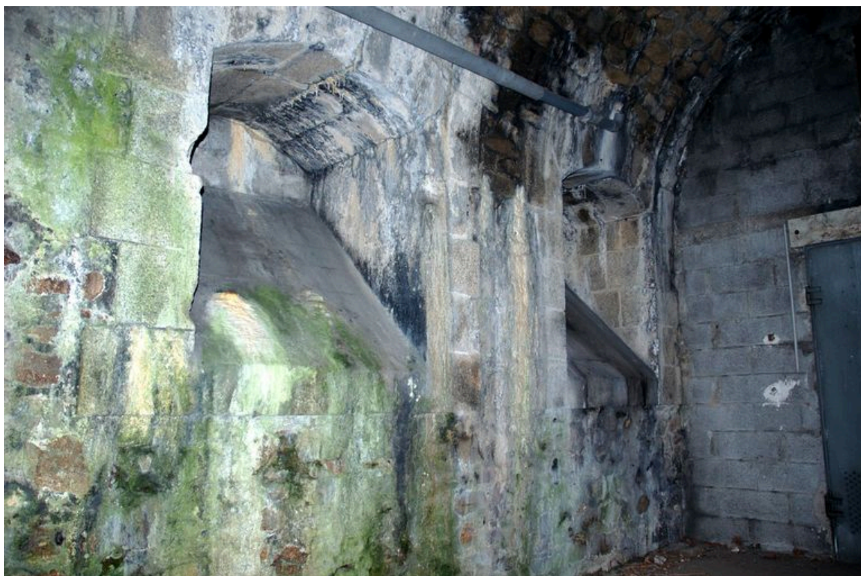
Vue de l'entrée du tunnel d'Heurtebise traversant le front bastionné de l'Harteloire dit Nouvelle enceinte (construite en 1848) : intérieur du sas, deux créneaux de fusillade disposés à gauche en entrant
