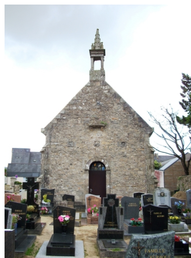
Gouesnou, chapelle Sainte- Anne : élévation ouest Phot. Gwénaél Fauchille IVR53_20082906197NUCA
