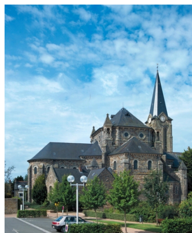
Vue générale ouest Phot. Guy Artur, Phot. Norbert Lambart
