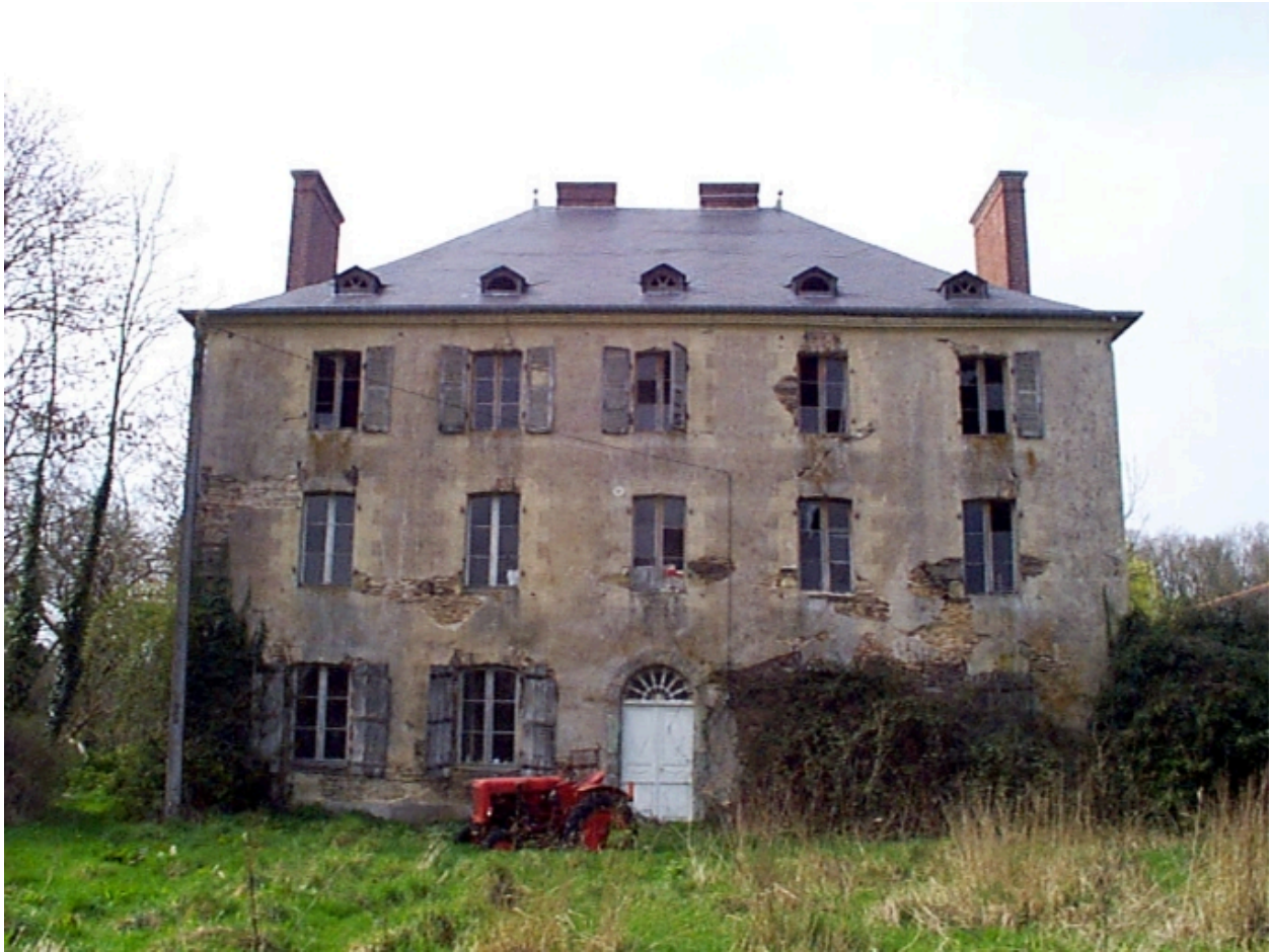
Façade postérieure : vue générale ouest
