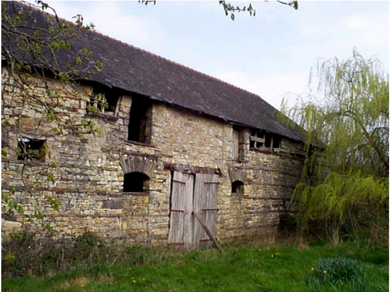
Les communs : vue générale sud-ouest
