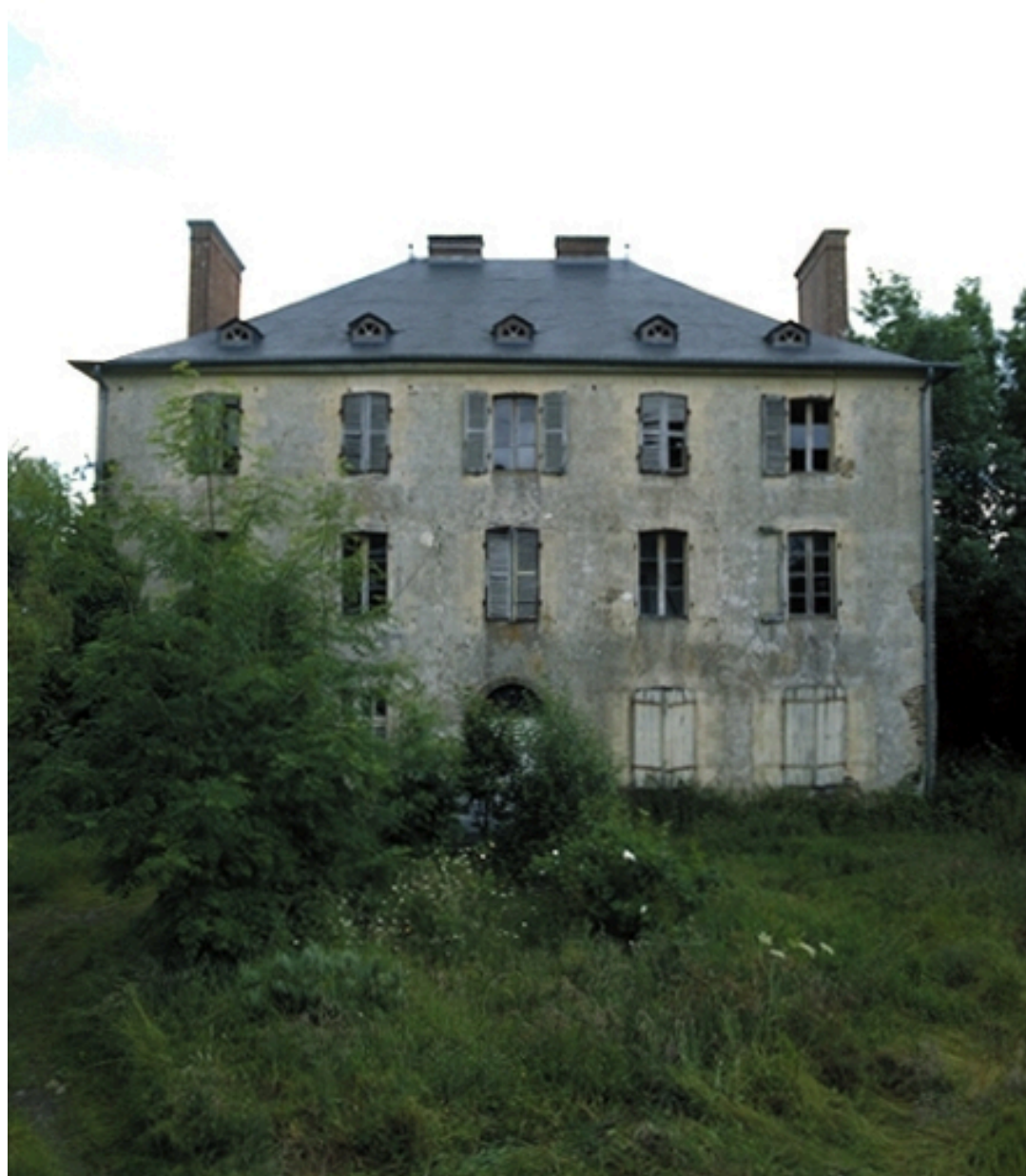
Façade antérieure : vue générale ouest
