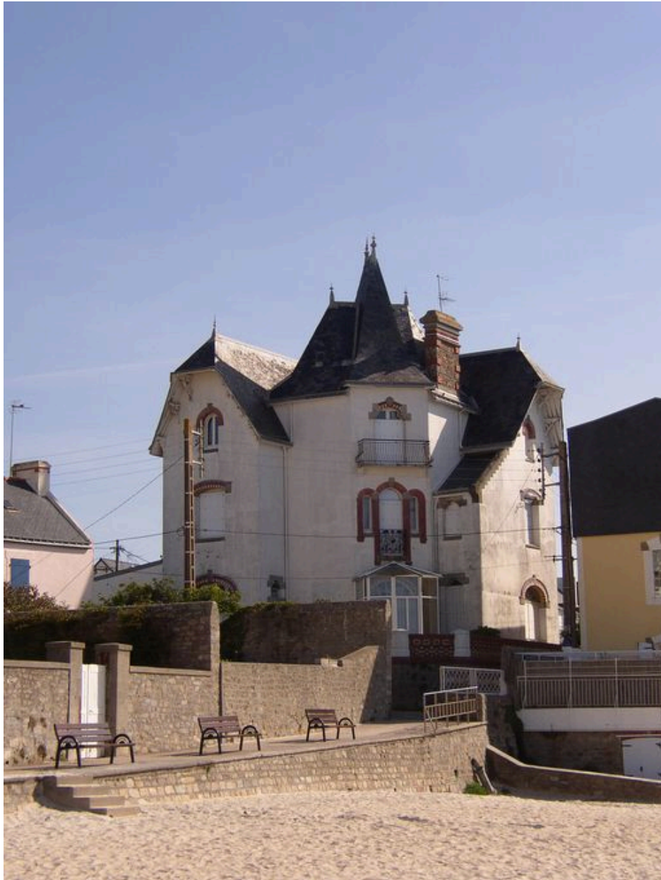
Vue générale de la maison de villégiature Ty Karet
