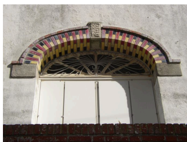
Détail d'un fronton Phot. Johan Vincent IVR53_20065606517NUCA
