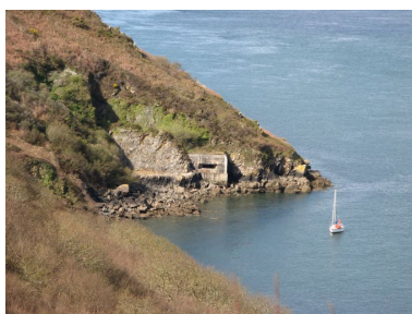
Situation de la batterie de rupture de Pourjoint Phot. Guillaume Marie IVR53_20082908425NUCA
