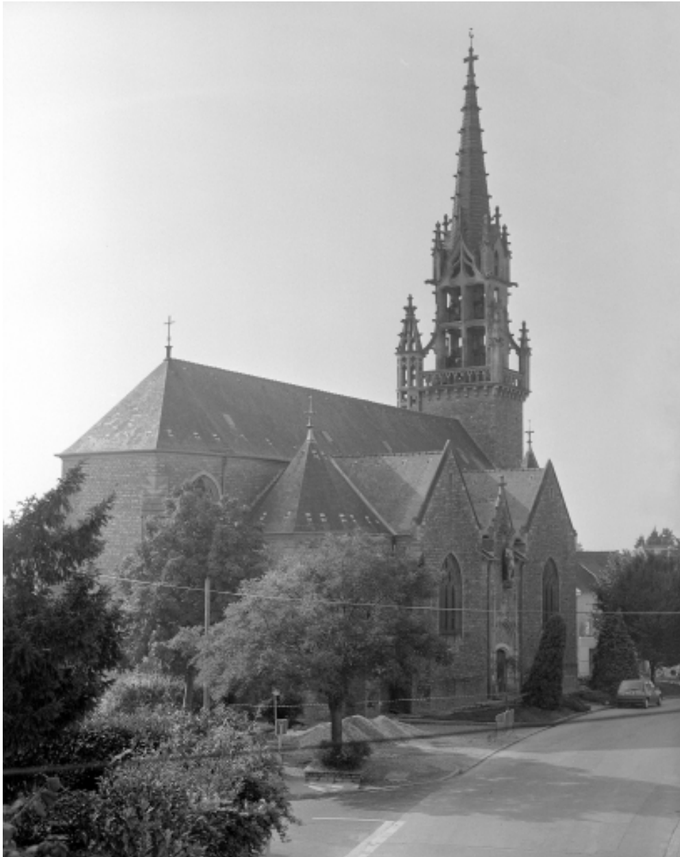
Vue générale nord-est
