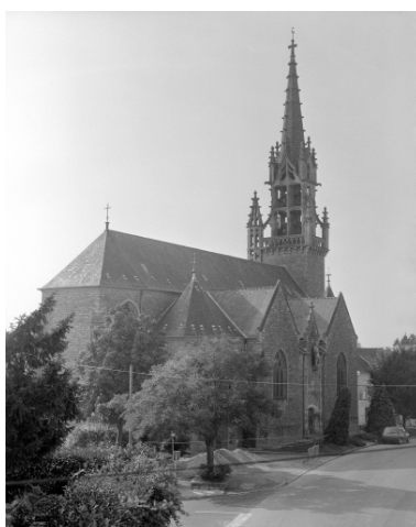
Vue générale nord-est Phot. Guy Artur, Phot. Norbert Lambart IVR53_19943501930X
