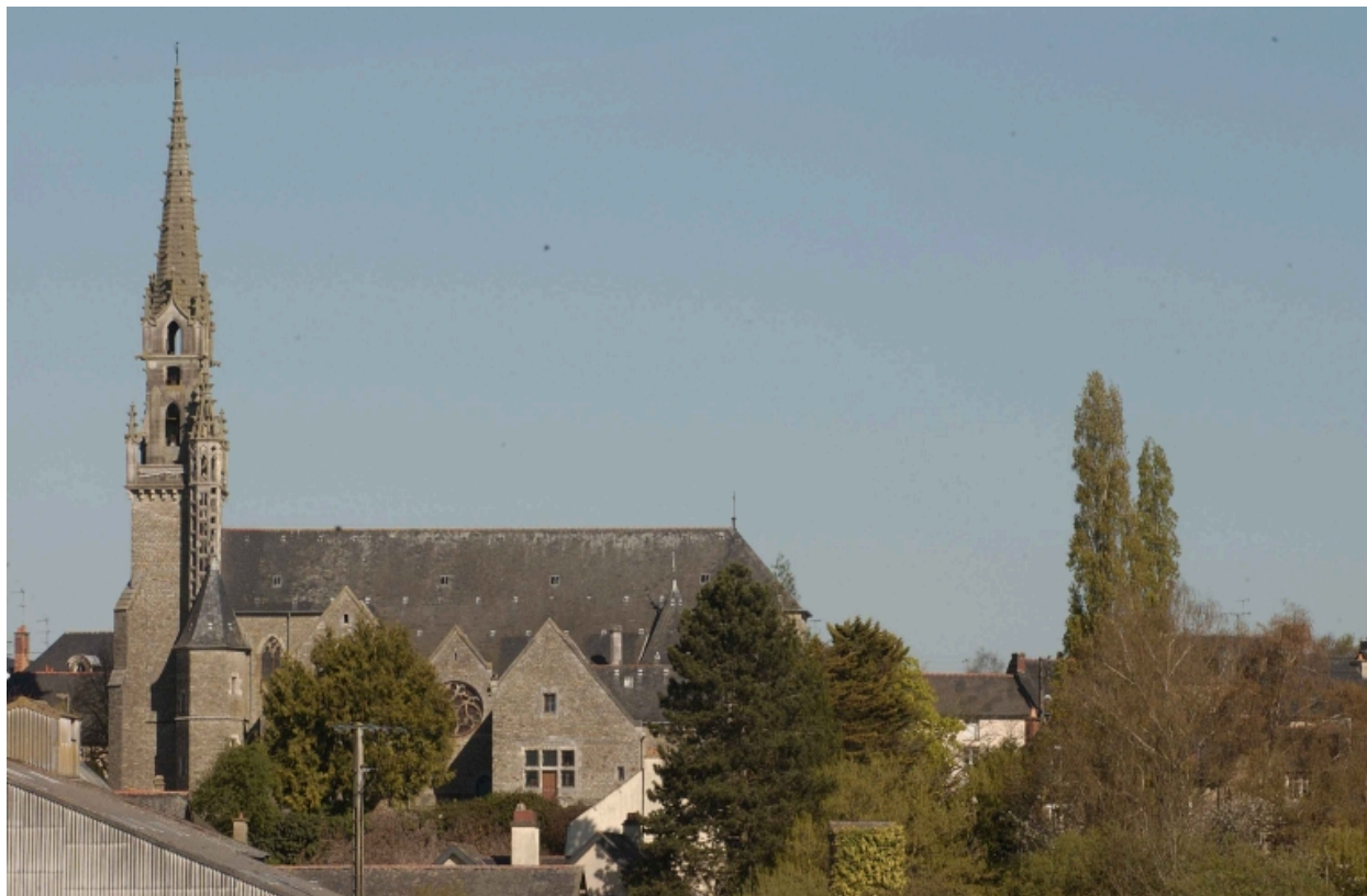
Vue de situation sud
